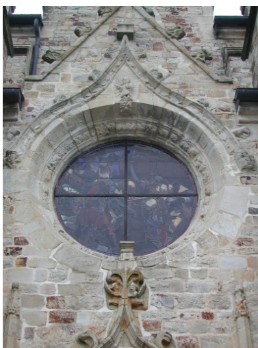
Elément en remploi : fenêtre Phot. Claude Quillivic IVR53_20033507600NUCA
