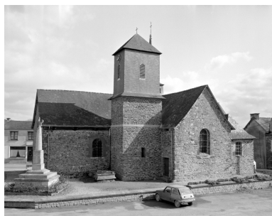
Elévation Sud : vue générale
