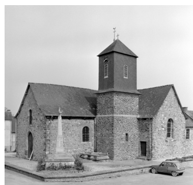
Elévation Sud-Ouest : vue générale
