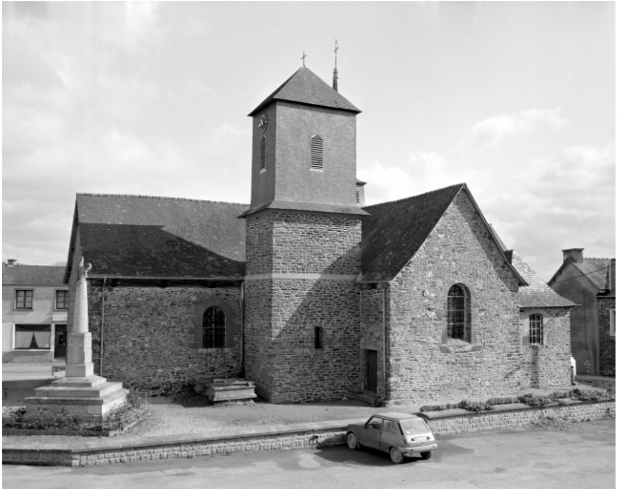
Elévation Sud : vue générale
