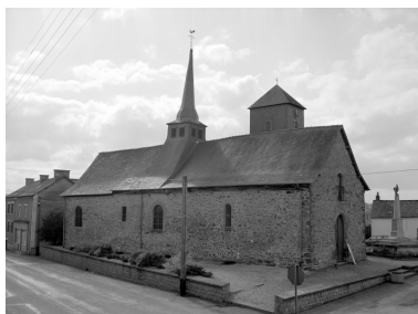
Elévation Nord : vue générale
