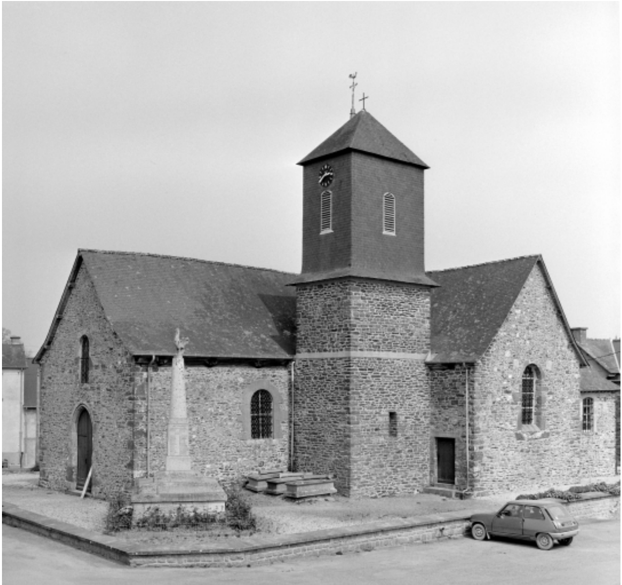
Elévation Sud-Ouest : vue générale
