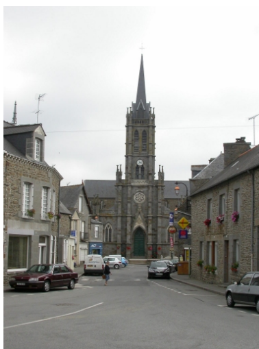
Vue générale, depuis la rue Phot. Claire Bonnet IVR53_20063513109NUCA
