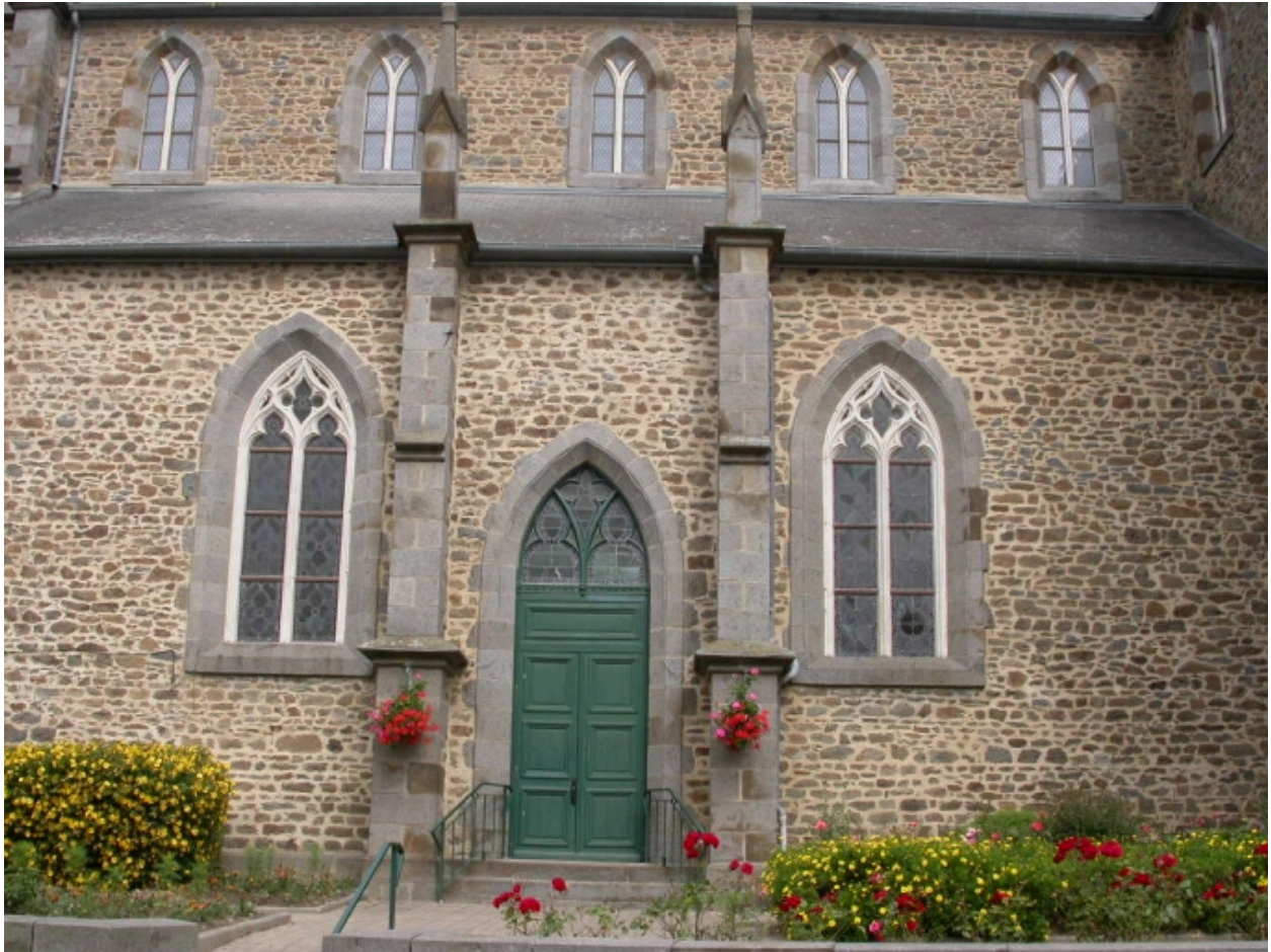
Façade sud, baies
