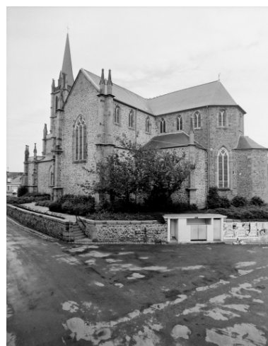
Elévation est, vue générale Phot. Guy Artur, Phot. Norbert Lambart IVR53_19943501783X
