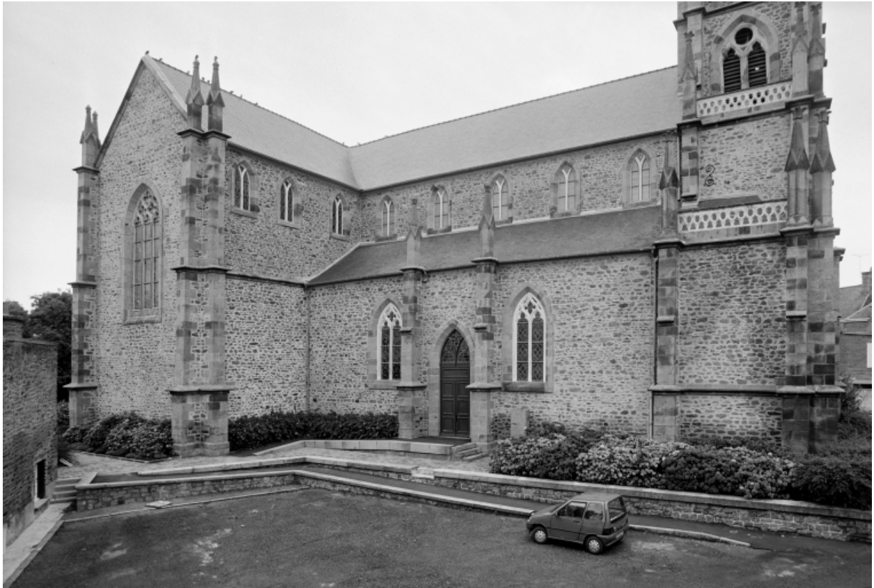
Elévation ouest, vue générale
