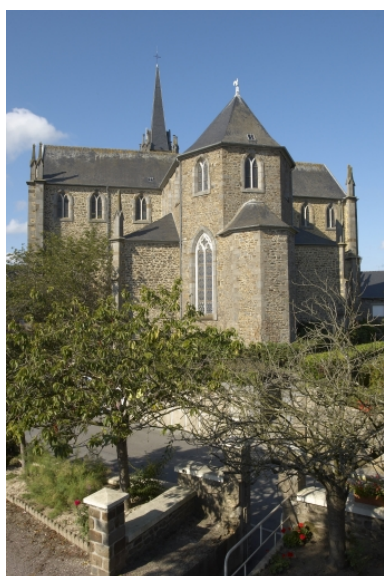
Vue est Phot. Norbert Lambart IVR53_20063501678NUCA
