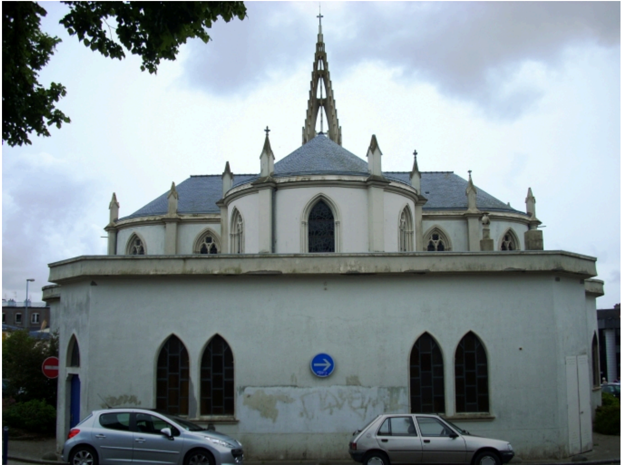
Brest, église Saint-Marc : élévation est
