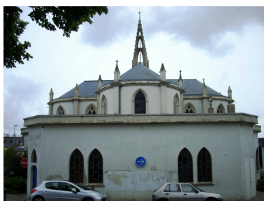
Brest, église Saint-Marc : élévation est Phot. Gwénaél Fauchille IVR53_20082906024NUCA
