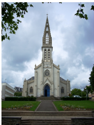
Brest, église Saint-Marc : élévation ouest Phot. Gwénaél Fauchille IVR53_20082906023NUCA
