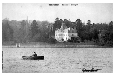
Vue latérale depuis la rivière de Quimper Phot. Elise Lauranceau IVR53_20042905623NUCB
