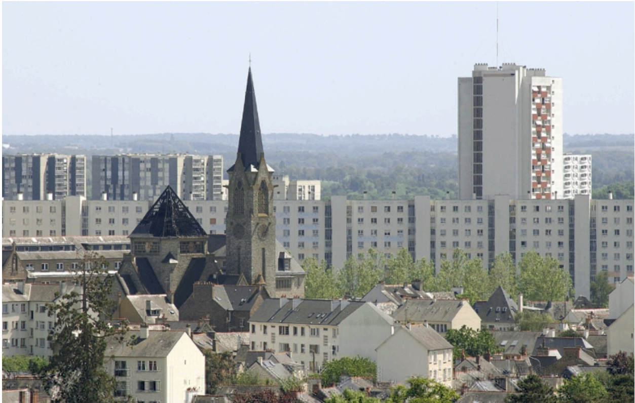
Vue de situation prise du nord-ouest
