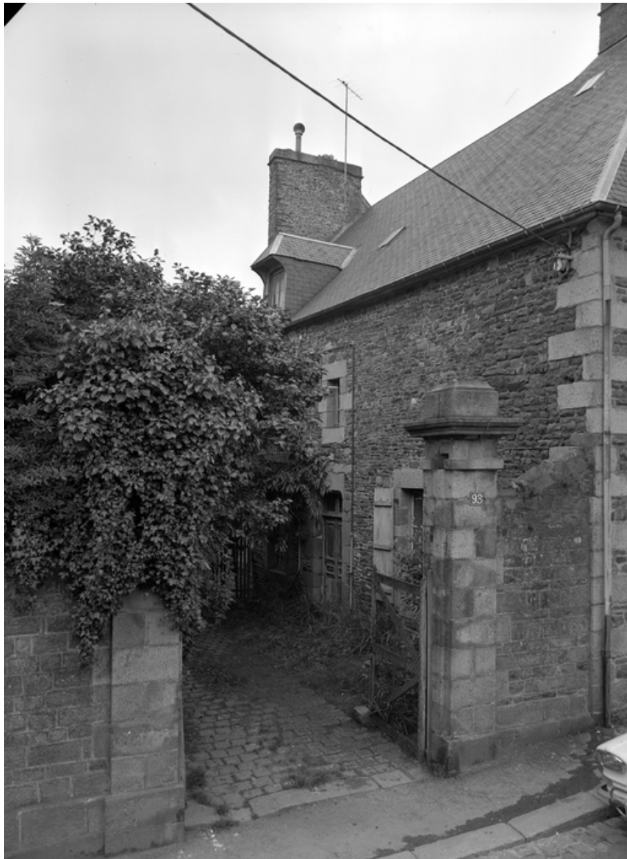
Façade sud et portail, vue générale.
