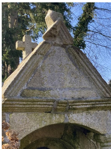
Toit à bâtière avec date, 1847, vue sud. Phot. Baptiste Oligo IVR53_20255610532NUCA
