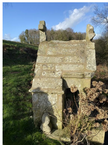
Vue sud Phot. Baptiste Oligo IVR53_20255610535NUCA
