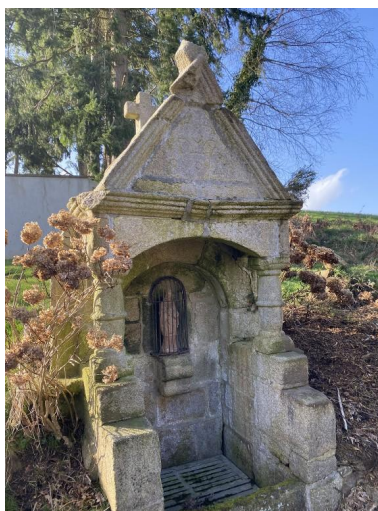
Vue générale sud-est Phot. Baptiste Oligo IVR53_20255610529NUCA
