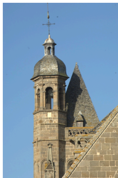
Vue du beffroi de la tour sud Phot. Norbert Lambart IVR53_20093501001NUCA
