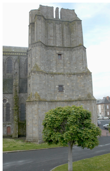
Tour nord, vue générale de la face nord Phot. Norbert Lambart IVR53_20073500762NUCA
