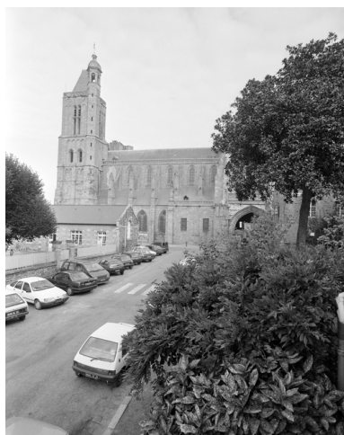
Elévation Sud, partie Ouest : vue générale. Phot. Guy Artur, Phot. Norbert Lambart IVR53_19943501887X
