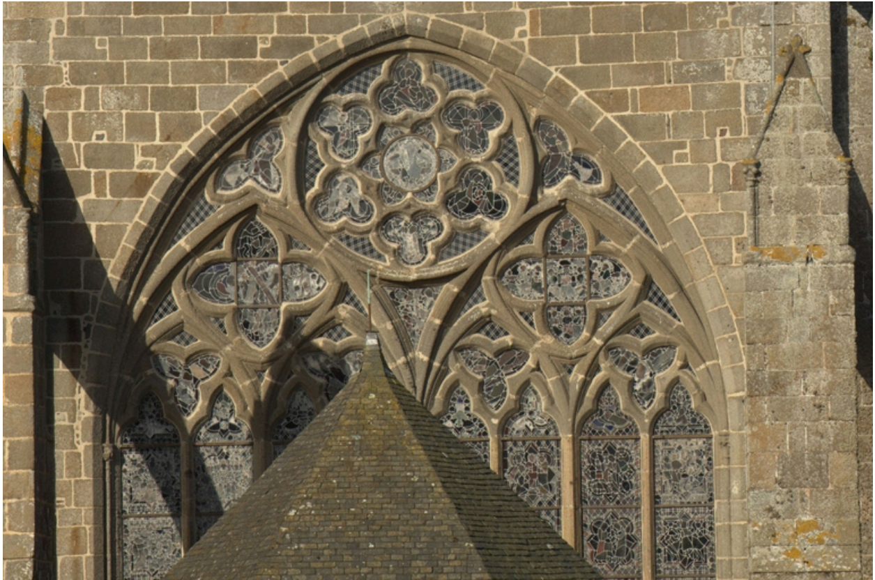
Chevet, réseau de la maîtresse-vitre
