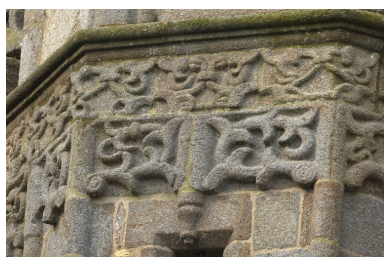
Tour nord, détail décor du bandeau du second étage Phot. Norbert Lambart IVR53_20073500770NUCA
