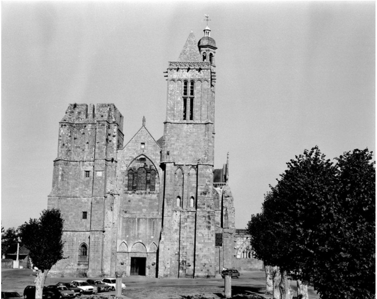
Vue générale Ouest.
