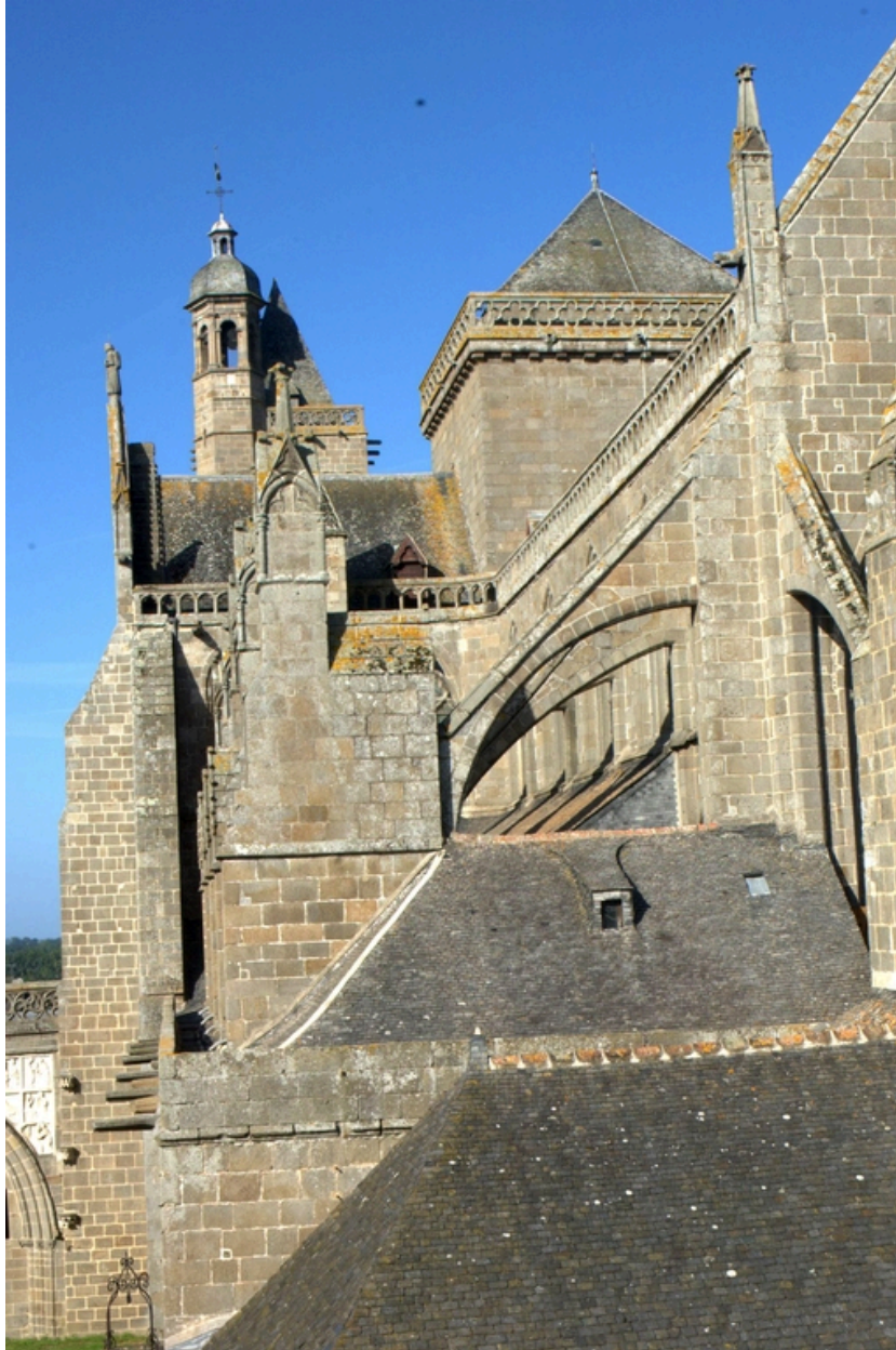
Arcs boutants de l'élévation sud du choeur
