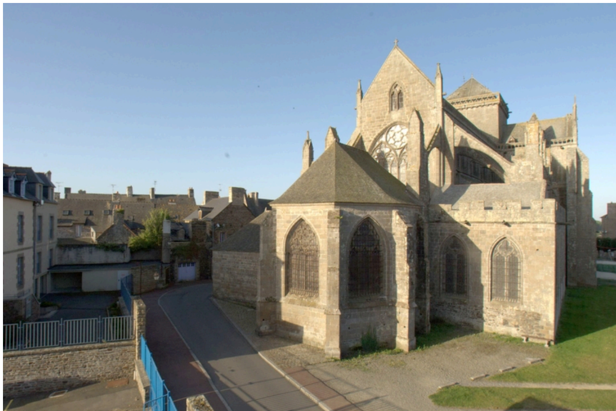
Chevet vue générale prise du nord-est
