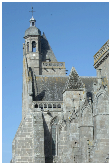
Pinacles côté sud du chœur, bras sud et sommet de la tour sud Phot. Norbert Lambart IVR53_20093501010NUCA
