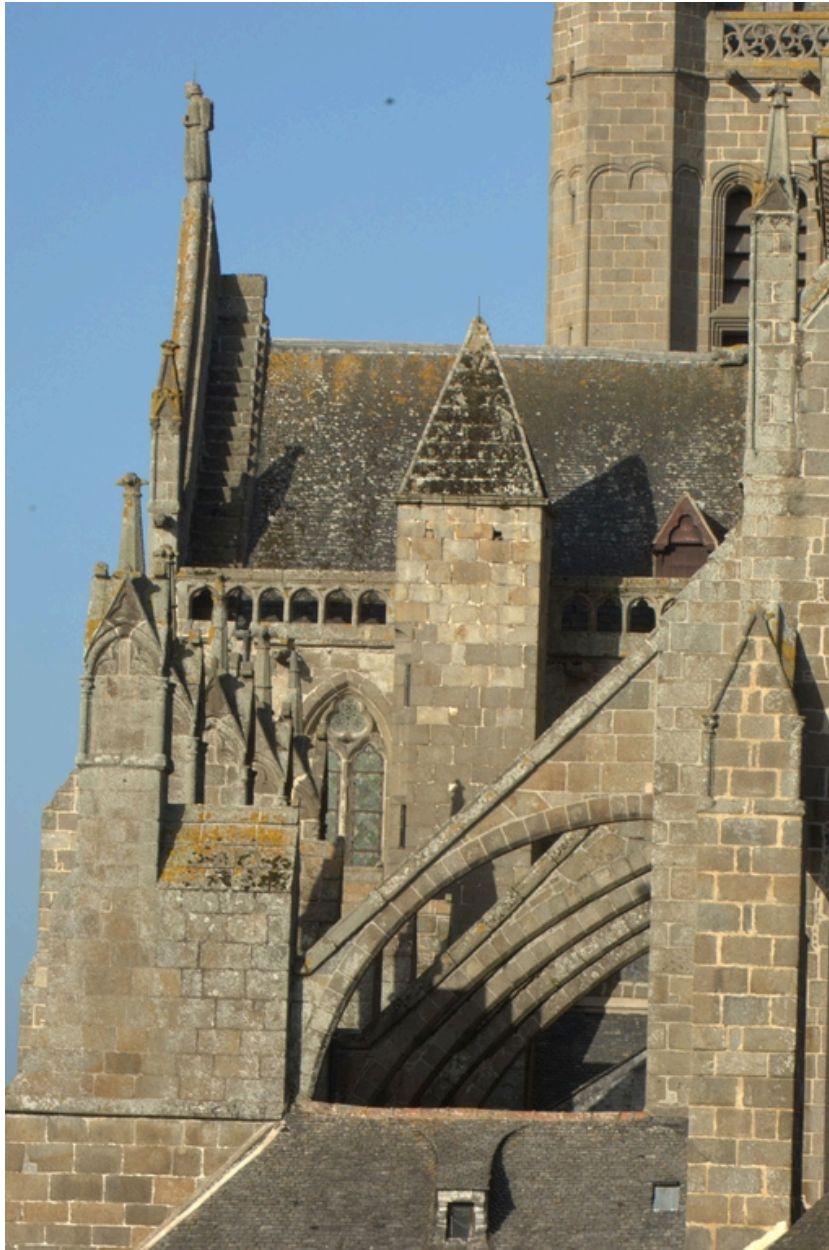
Vue en enfilade des arcs boutans du côté sud depuis l'est
