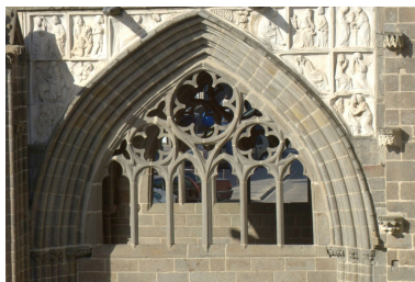
Porche sud, face est, détail réseau Phot. Norbert Lambart IVR53_20093501022NUCA
