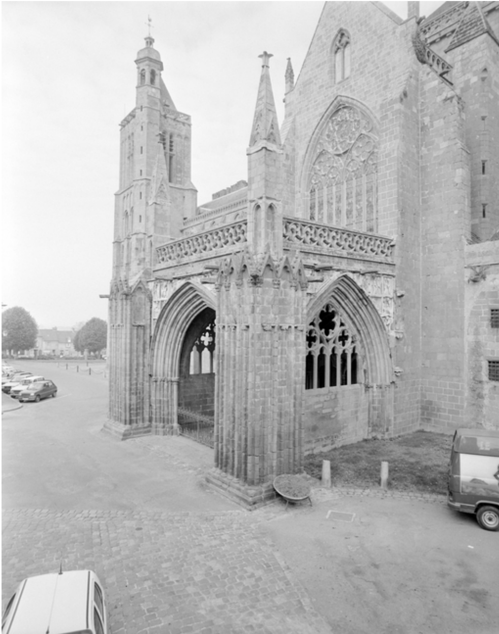
Elévation Sud, porche : vue générale.
