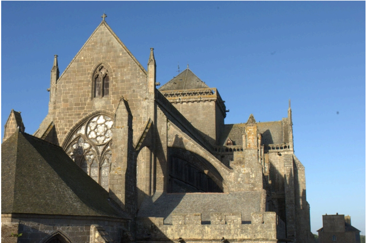
Partie supérieure du chevet prise du nord-est
