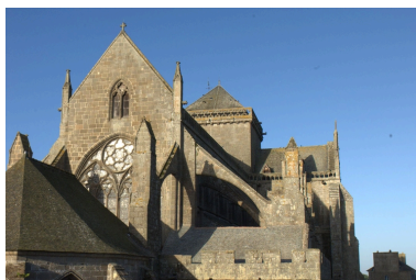
Partie supérieure du chevet prise du nord-est Phot. Norbert Lambart IVR53_20093500981NUCA
