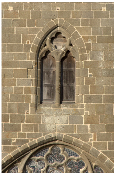
Chevet, détail baie du comble Phot. Norbert Lambart IVR53_20093501004NUCA
