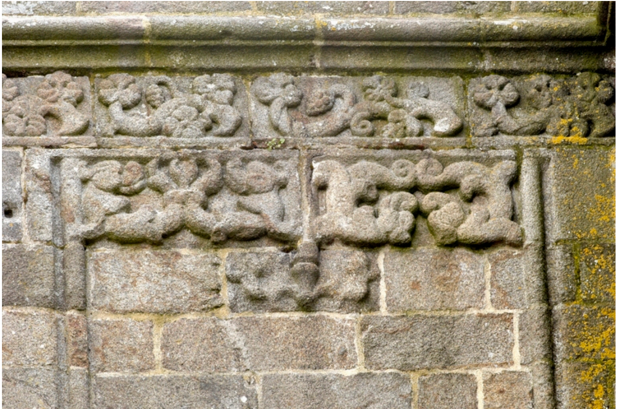
Tour nord, troisième étage détail de décor aux dauphins
