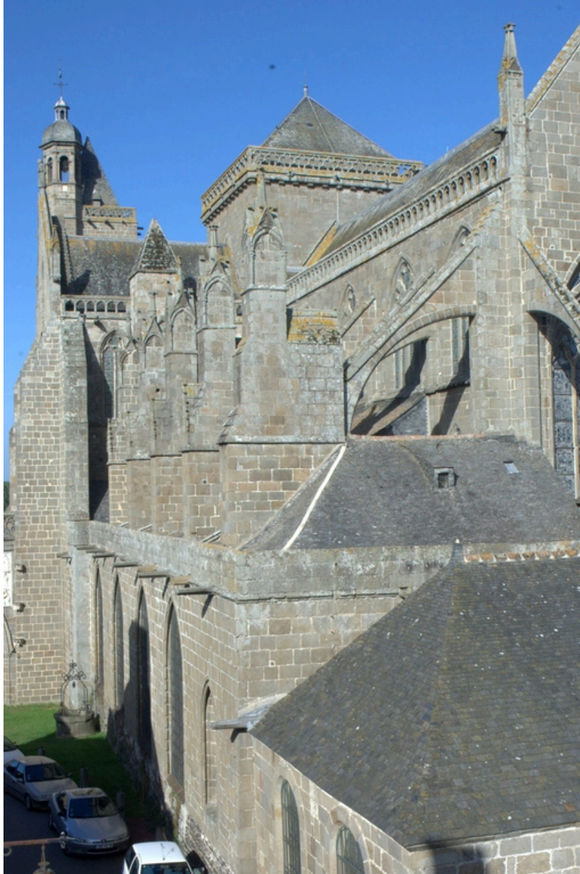
Elévation sud du choeur, vue en enfilade depuis le sud-est
