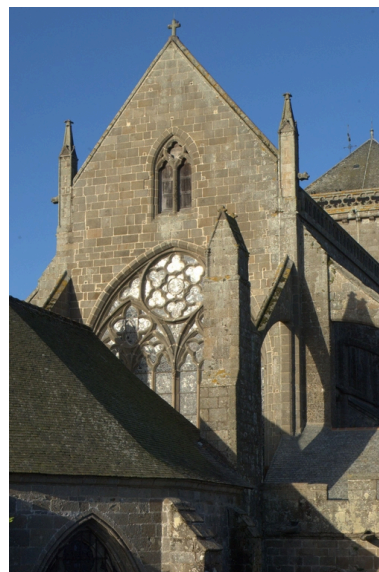
Chevet, pignon du vaisseau central du chœur Phot. Norbert Lambart IVR53_20093500982NUCA
