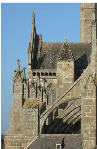
Arcs boutants du choeur côté sud, vue en enfilade Phot. Norbert Lambart IVR53_20093500997NUCA
