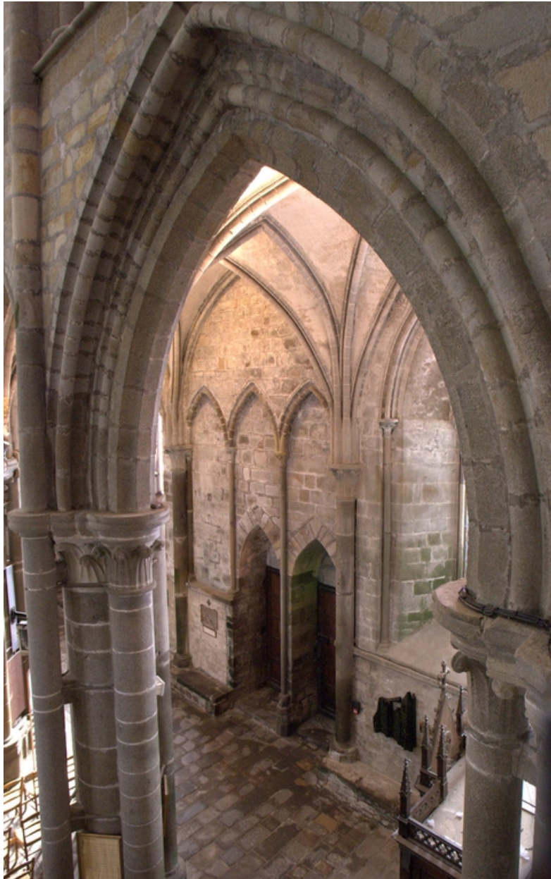
Première arcade de la l'élévation sud de la nef, vue vers le revers du petit porche sud
