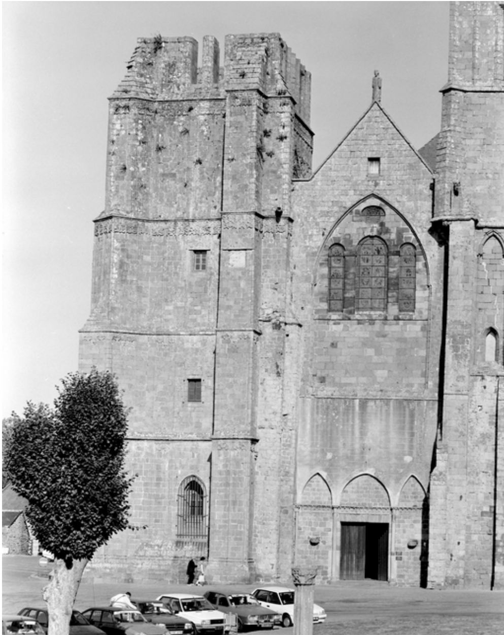
Façade Ouest : détail de la tour Sud.
