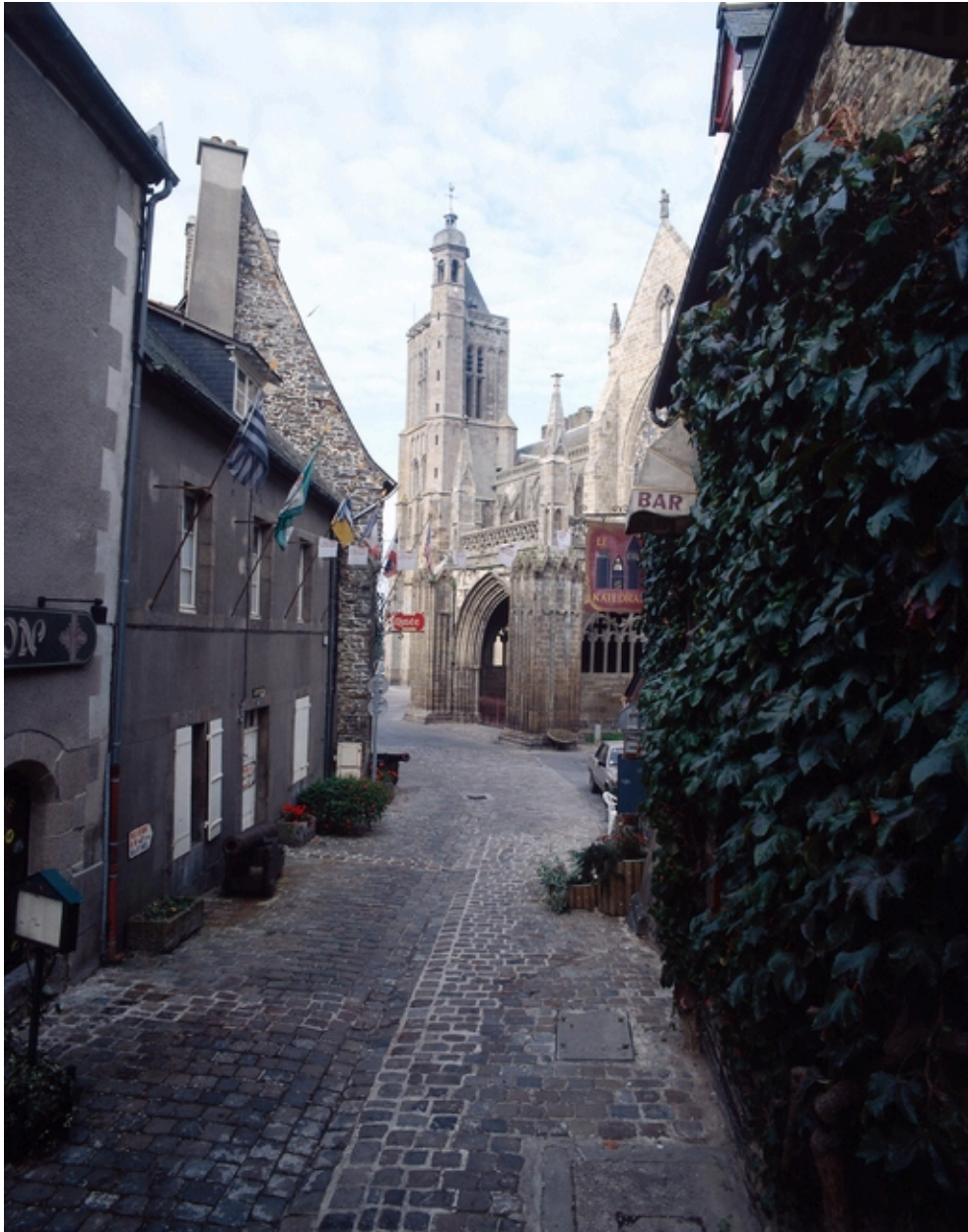
Elévation sud, porche : vue de situation.
