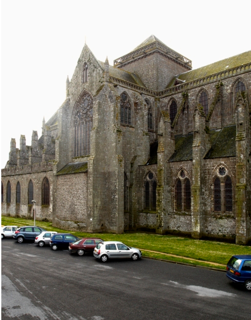
Elévation nord de la nef et de la tour
