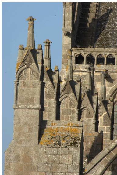
Pinacles des arcs boutants côté sud Phot. Norbert Lambart IVR53_20093501003NUCA
