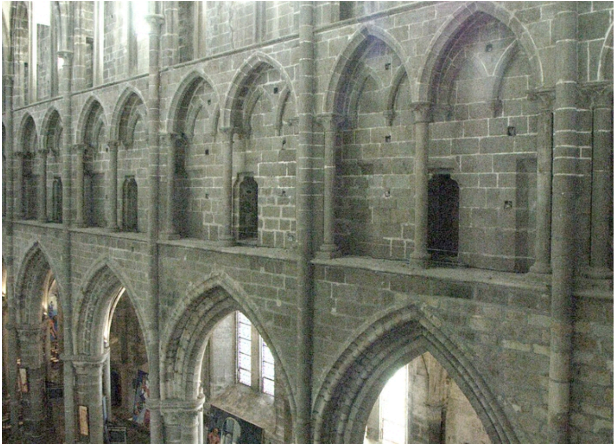
Intérieur, élévation sud de la nef depuis le nord-ouest, détail du triforium
