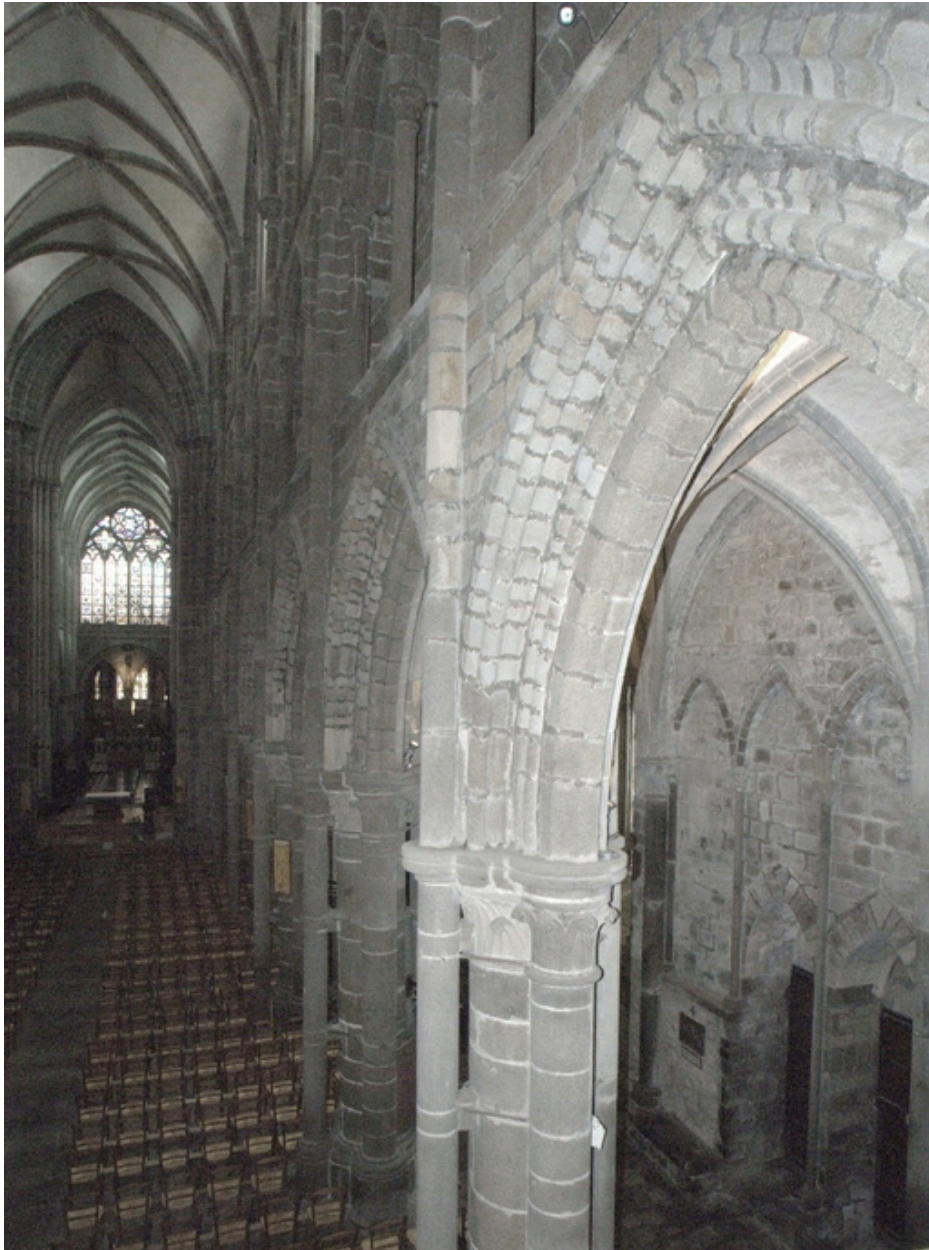
Vue rapprochée de la première arcade de l'élévation sud de la nef
