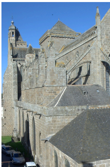
Élévation sud du chœur, vue en enfilade depuis le sud-est Phot. Norbert Lambart IVR53_20093501011NUCA
