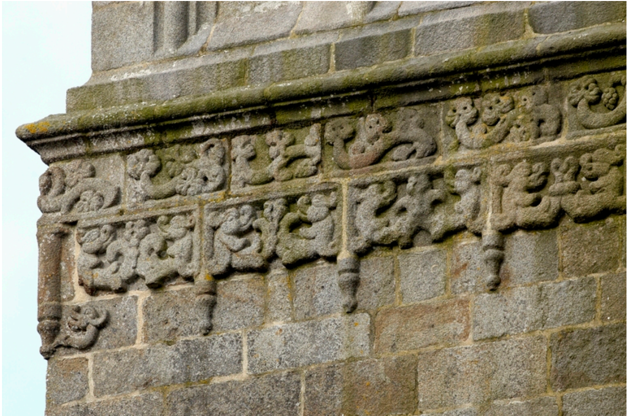
Tour nord, troisième étage, bandeau aux dauphins affrontés
