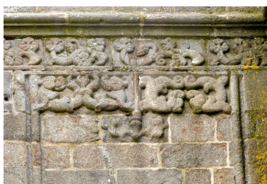
Tour nord, troisième étage détail de décor aux dauphins Phot. Norbert Lambart IVR53_20073500784NUCA
