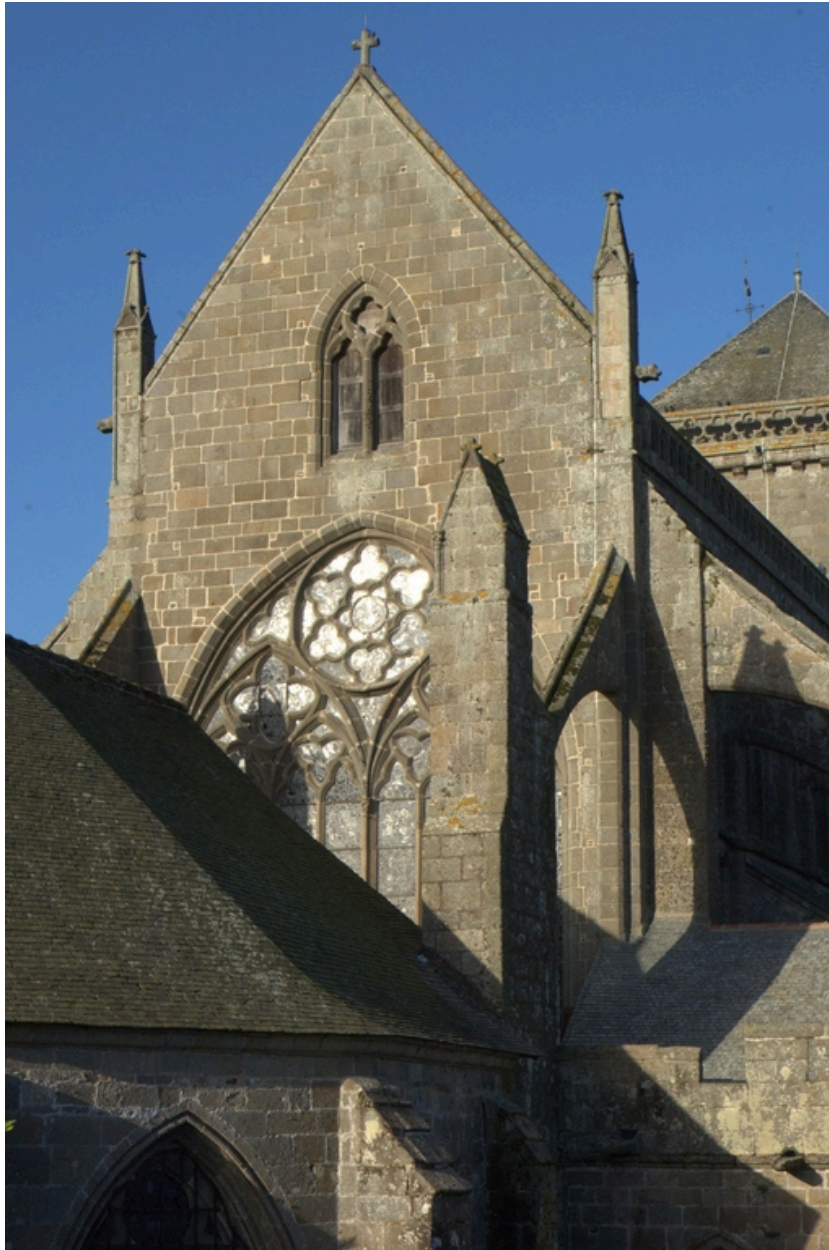
Chevet, pignon du vaisseau central du choeur
