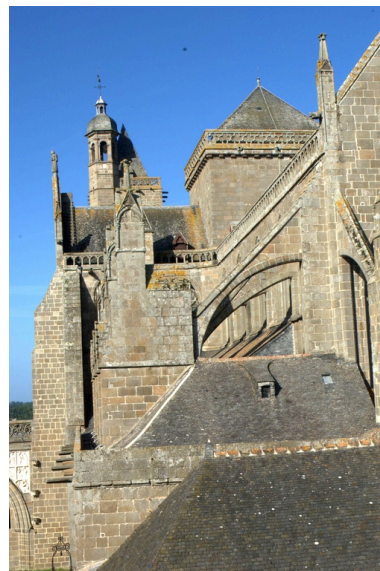
Arcs boutants de l'élévation sud du chœur Phot. Norbert Lambart IVR53_20093501023NUCA
