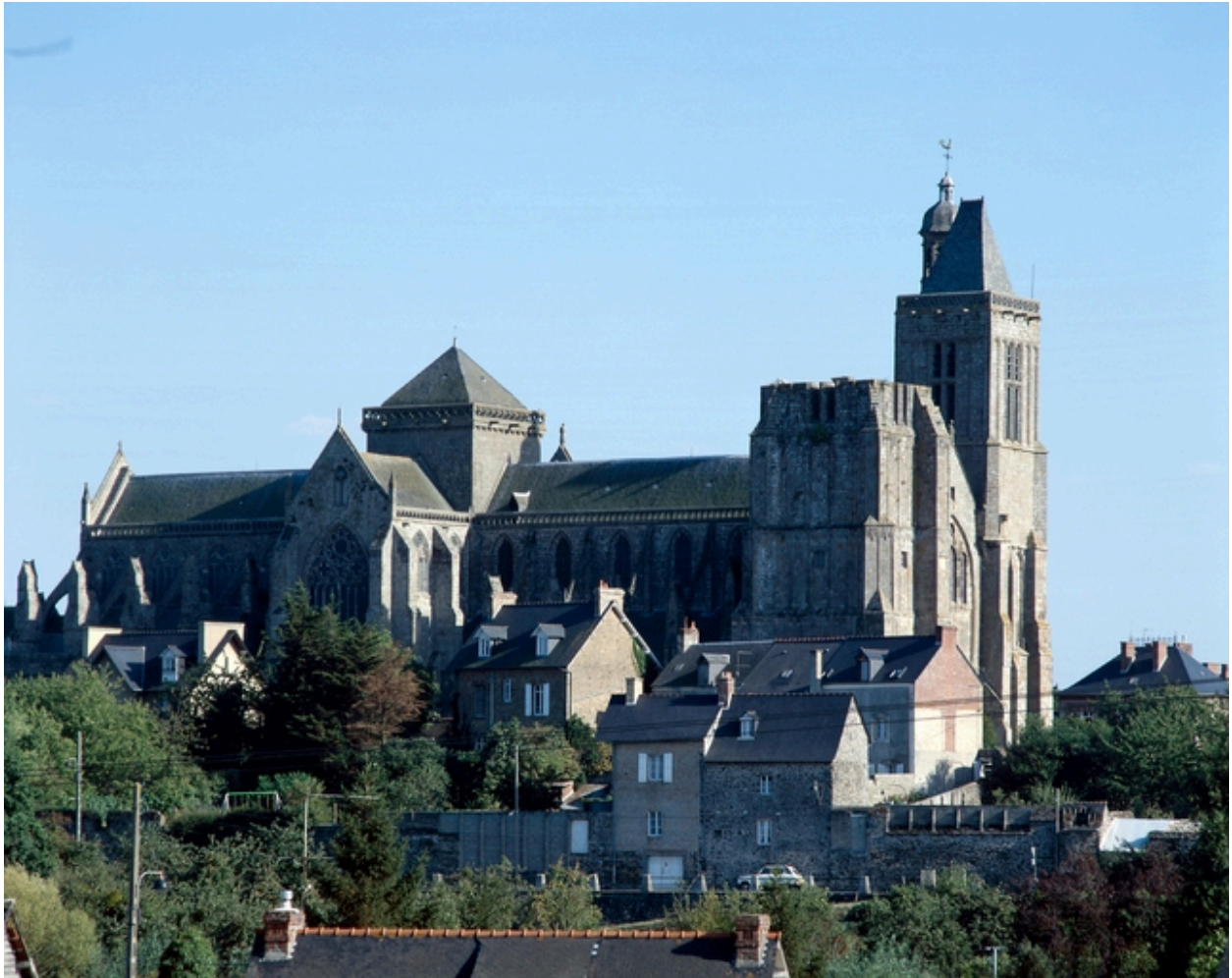
Vue générale depuis le nord.
