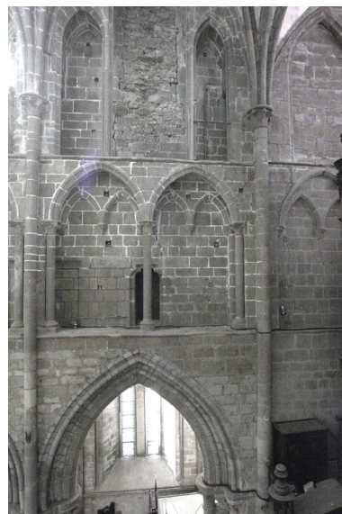
Intérieur, élévation sud de la nef au revers de la tour sud-ouest Phot. Norbert Lambart IVR53_20093501026NUCA
