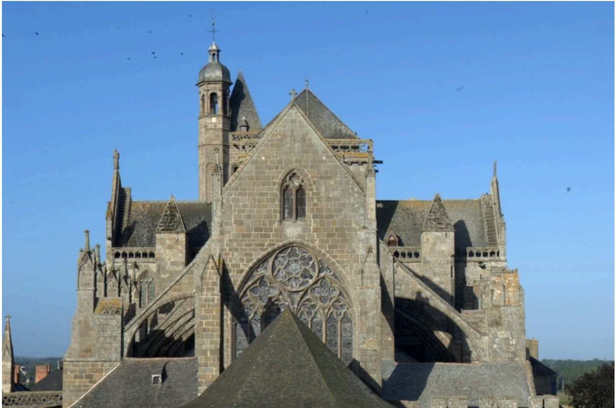
Partie haute du chevet, vue prise dans l'axe
