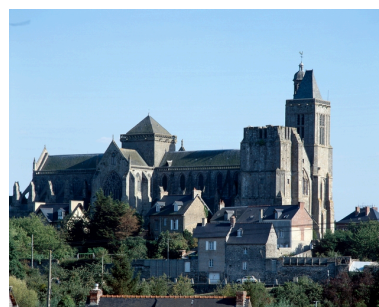
Vue générale depuis le nord. Phot. Guy Artur IVR53_19893500209XA
