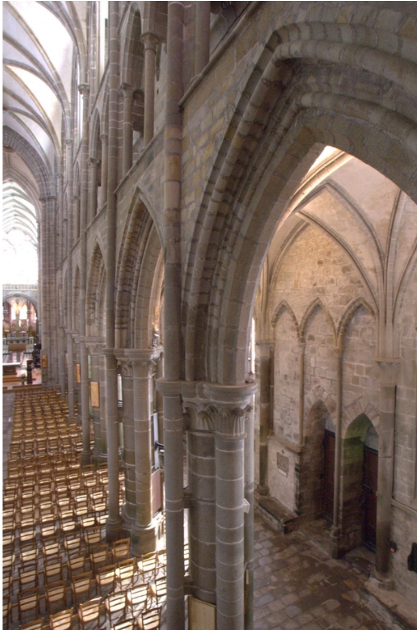
Vue prise en enfilade du côté sud de la nef et du bas du collatéral sud
