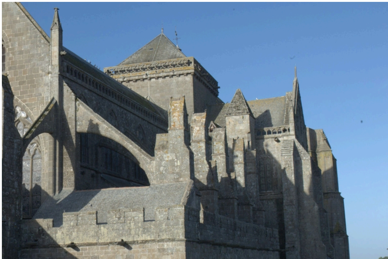
Enfilade des arcs-boutants du choeur côté nord
