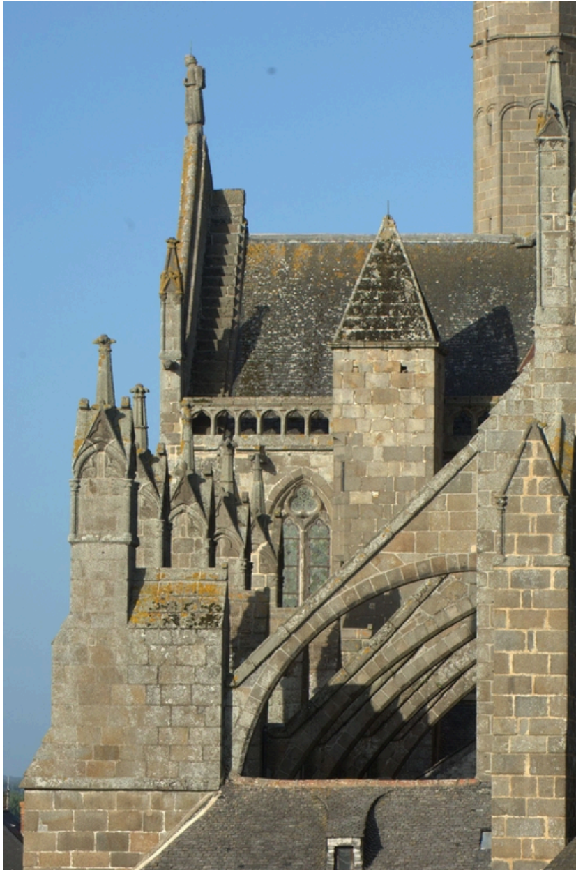
Arcs boutants du choeur côté sud, vue en enfilade
