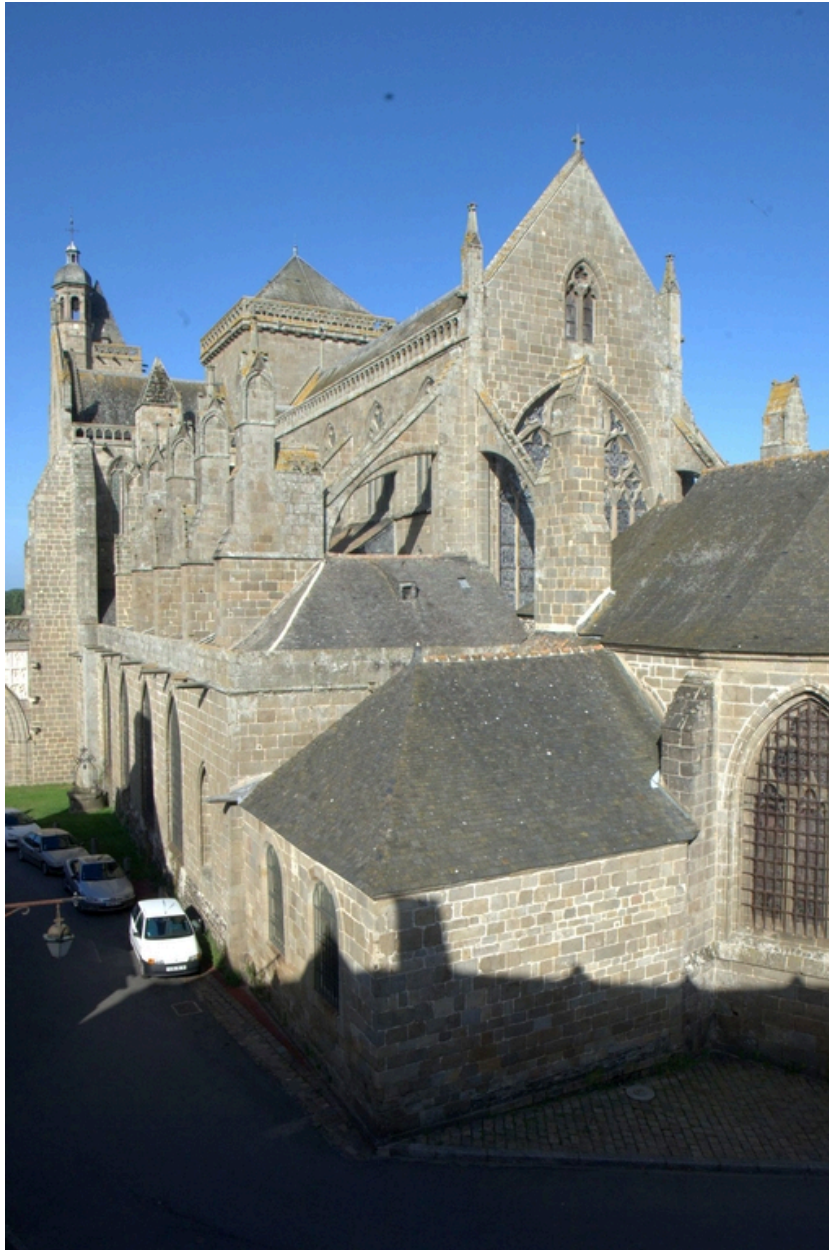
Vue du chevet et de l'élévation sud du choeur depuis le sud-est
