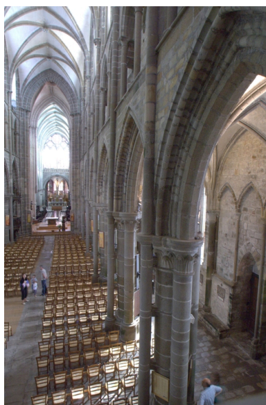
Intérieur, vue en enfilade de la nef et du collatéral sud Phot. Norbert Lambart IVR53_20093501031NUCA
