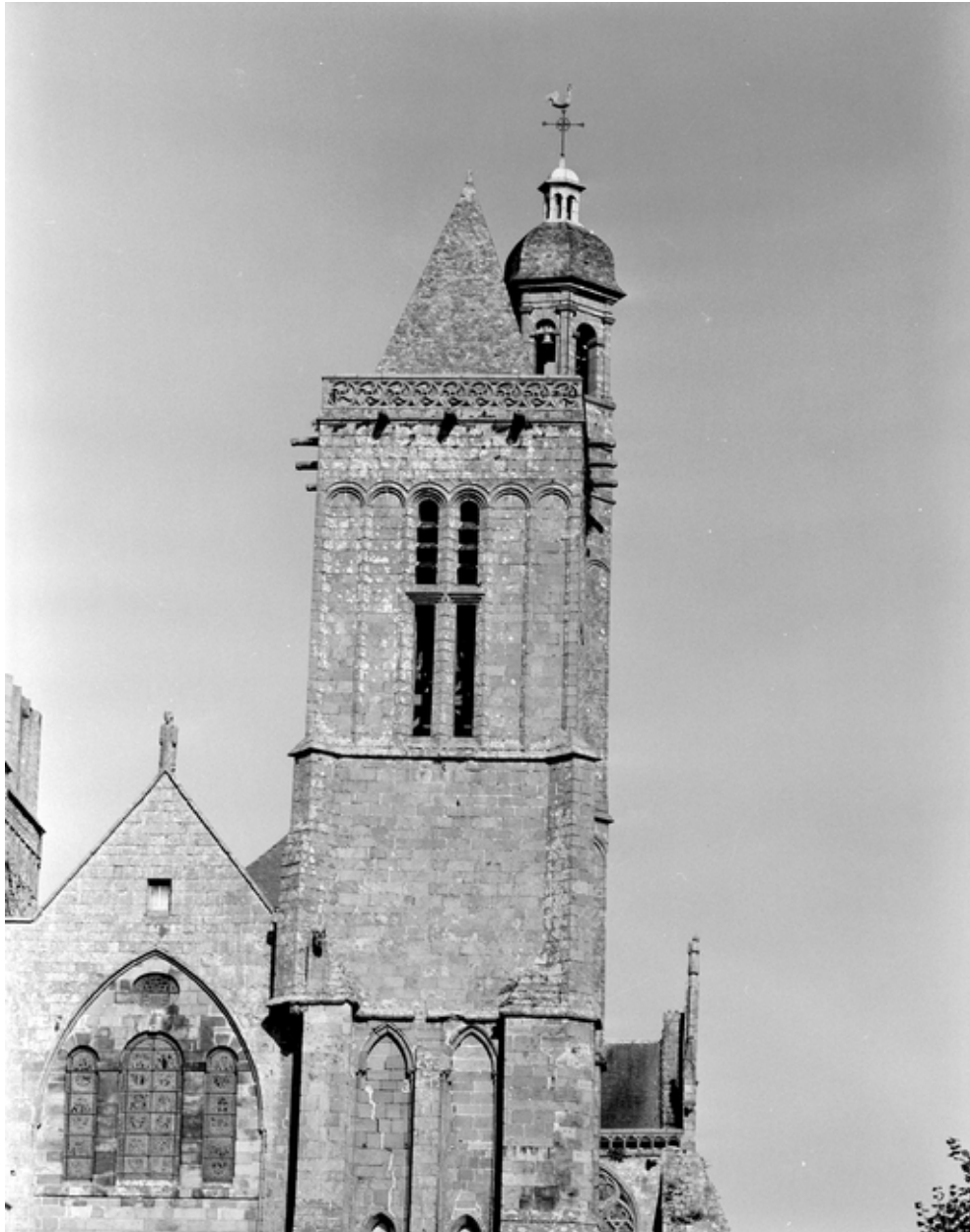
Façade Ouest : détail de la tour Nord.
