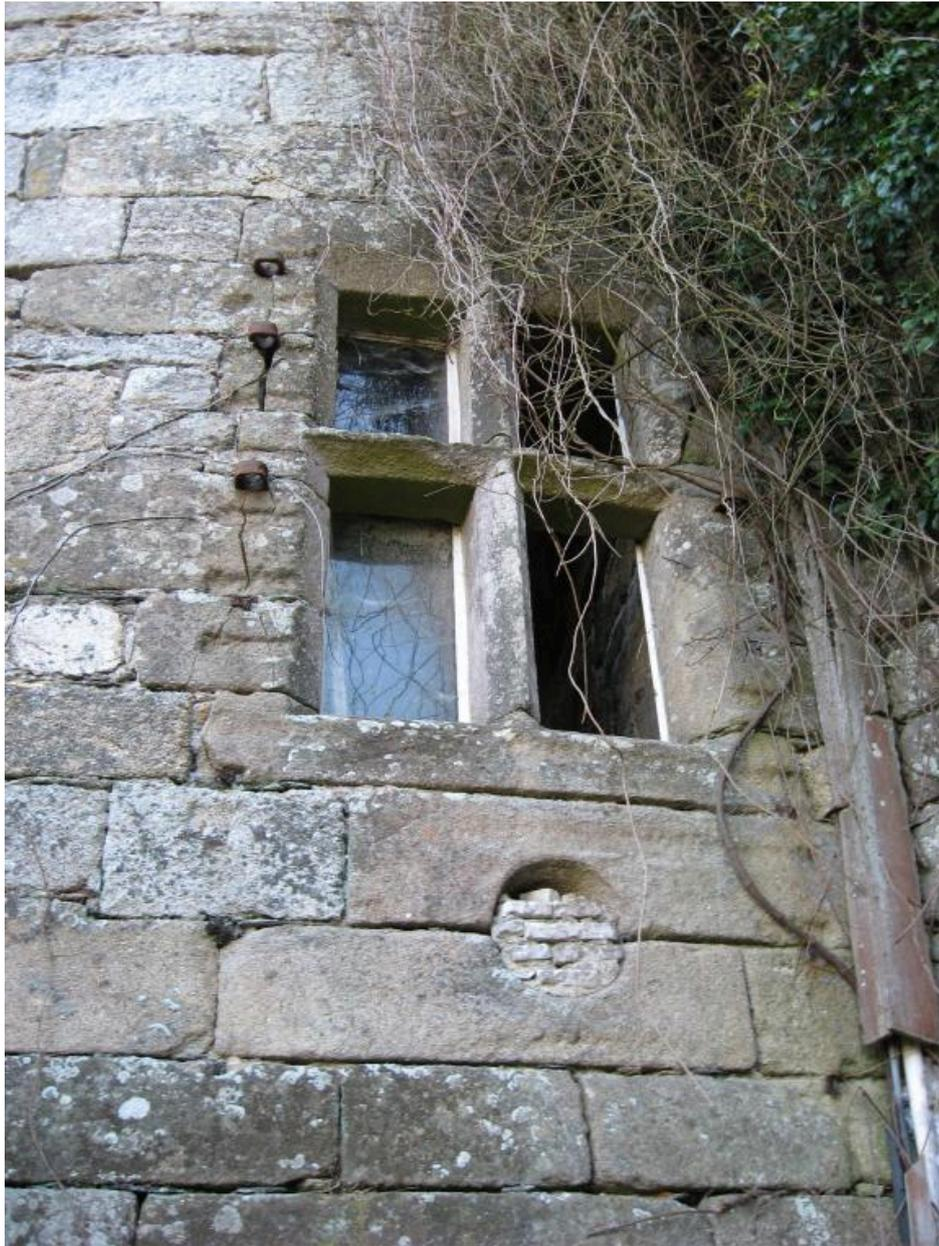
Fenêtre à meneaux et canonnière dans l'allège. On notera la présence d'anneaux de fixation d'une grille
