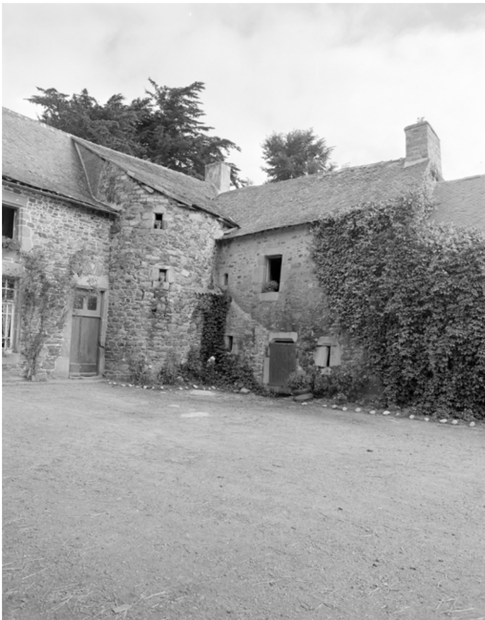
Façade sud, angle sud-ouest de la tourelle
