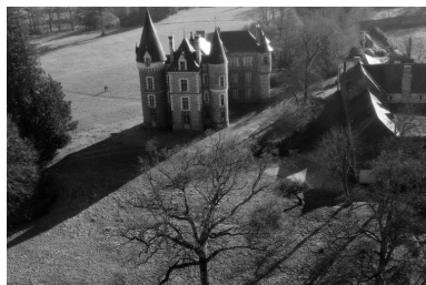
Vue aérienne depuis le nord-ouest Phot. G.A.L.A.T. IVR53_19713500480V
