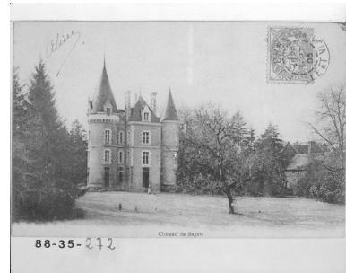
Vue de la façade principale Repro. Guy Artur, Repro. Norbert Lambart IVR53_19883500272X
