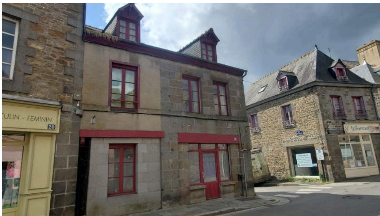
Vue façade nord avec l'ancien pontet comblé (2024).
