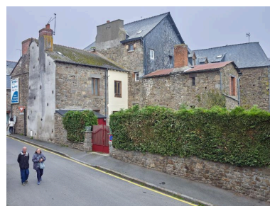
On retrouve, côté cour, la distinction entre la partie maçonnée et l'ancien corps de passage en pan de bois enduit. Phot. Bernard Bègne IVR53_20243501230NUCA
