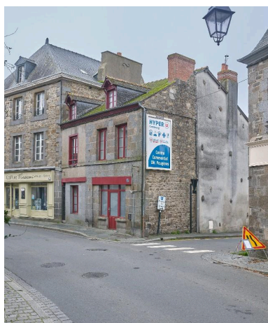
Ce bâtiment, fortement remanié, conserve une partie en pan de bois sous enduit. Phot. Bernard Bègne IVR53_20243501231NUCA
