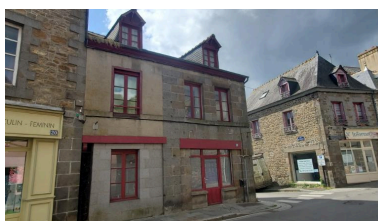
Vue façade nord avec l'ancien pontet comblé (2024). Phot. Sébastien Chauvel IVR53_20243510115NUCA
