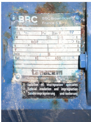
Inscription technique du moteur asynchrone. Phot. Marina Gasnier
