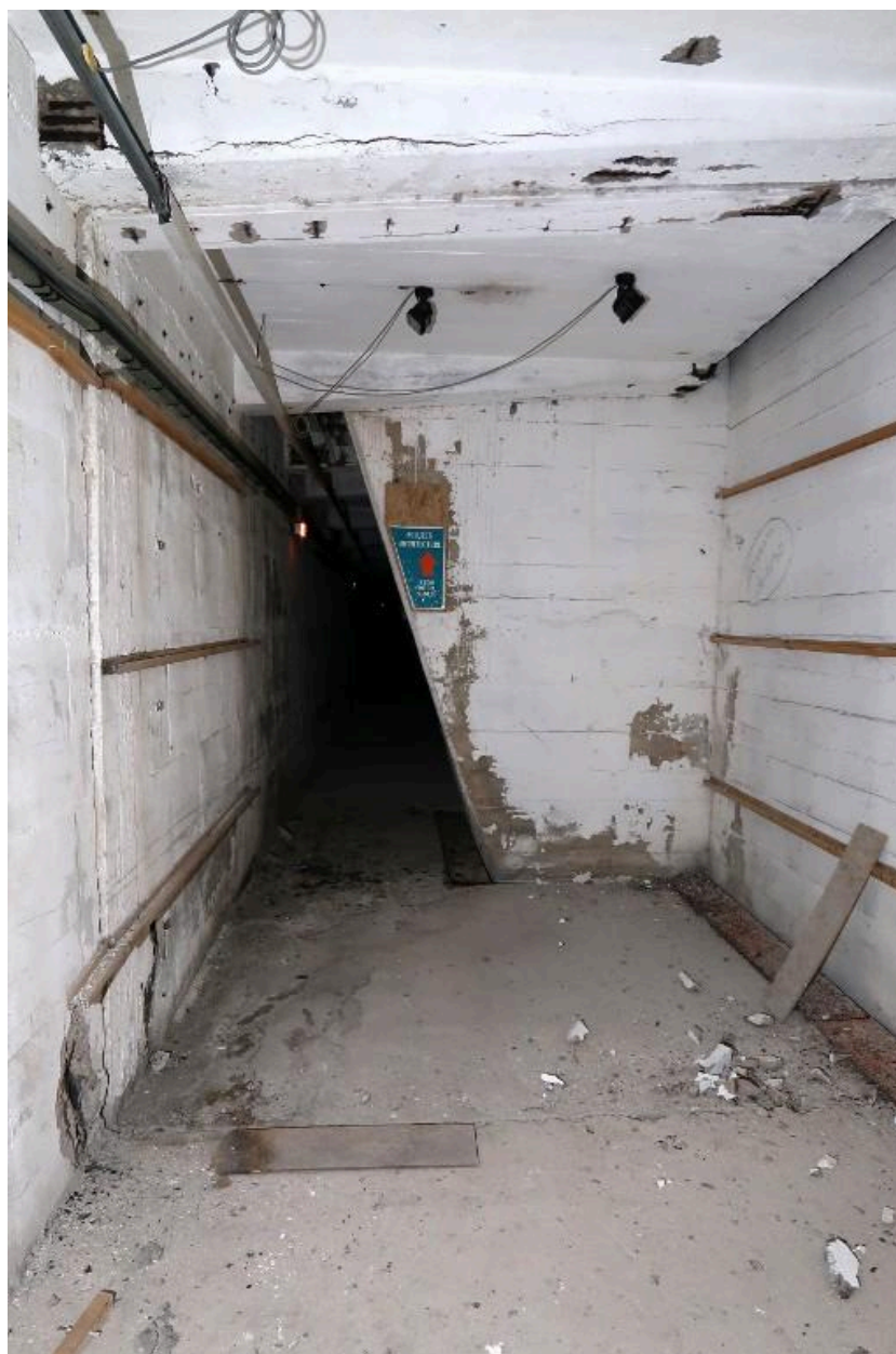
Vue de l'extension nord-ouest : premier étage, l'un des contreforts du bunker Keroman III englobé dans l'extension
