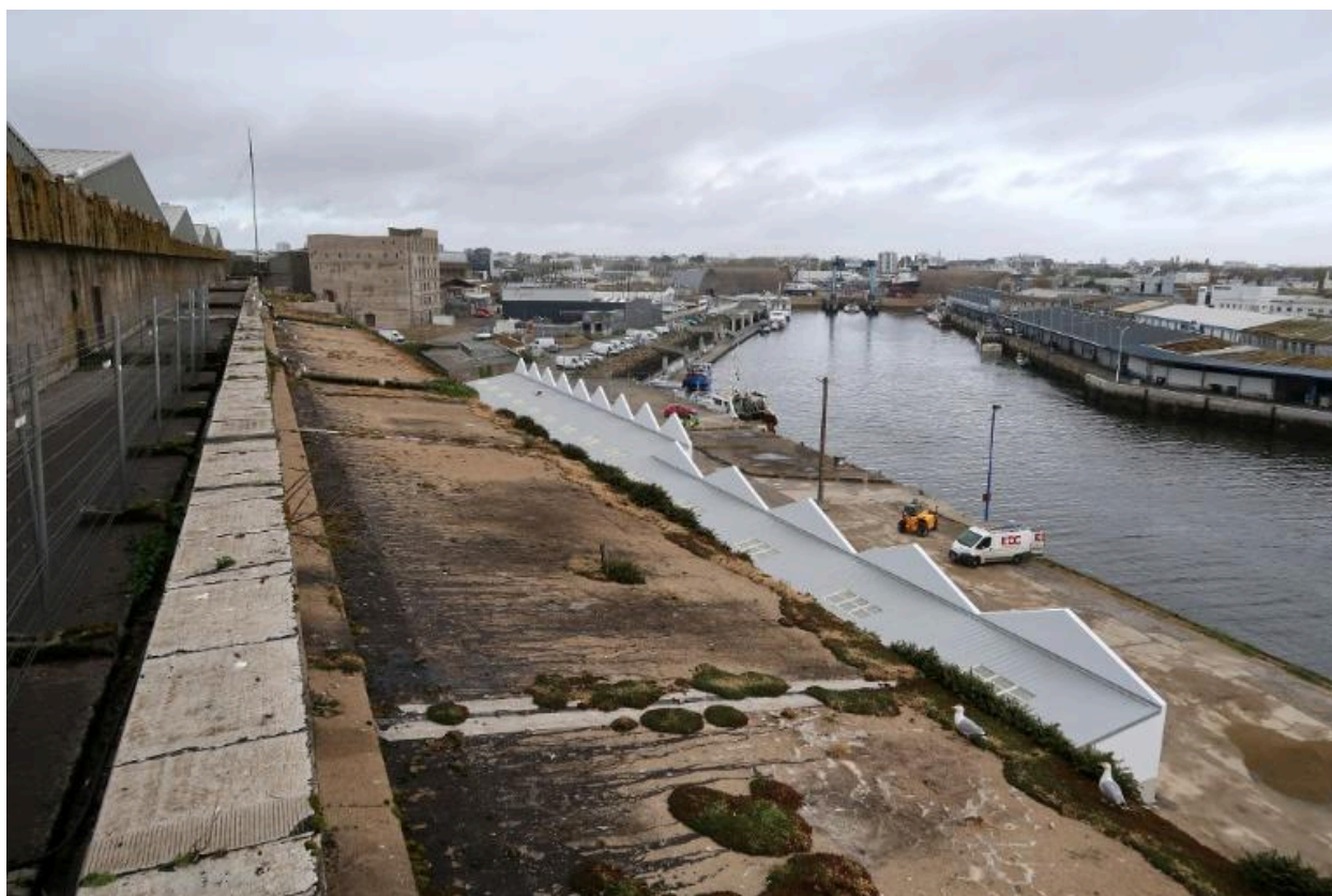
Vue de l'extension nord-est depuis la dalle de couverture du bunker Keroman III. Au second plan, le Bassin long
