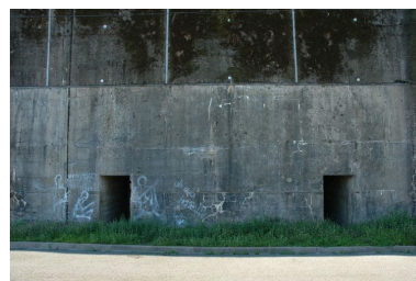
Vue de l'extension nord-est : entrées protégées (état en 2005) Phot. Guillaume Lécueillier IVR53_20055603577NUCA
