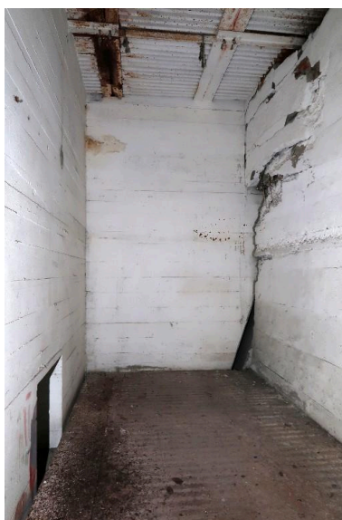
Vue de l'extension nord- ouest : deuxième étage, l'un des contreforts du bunker Keroman III englobé dans l'extension Phot. Guillaume Lécueillier IVR53_20245610093NUCA
