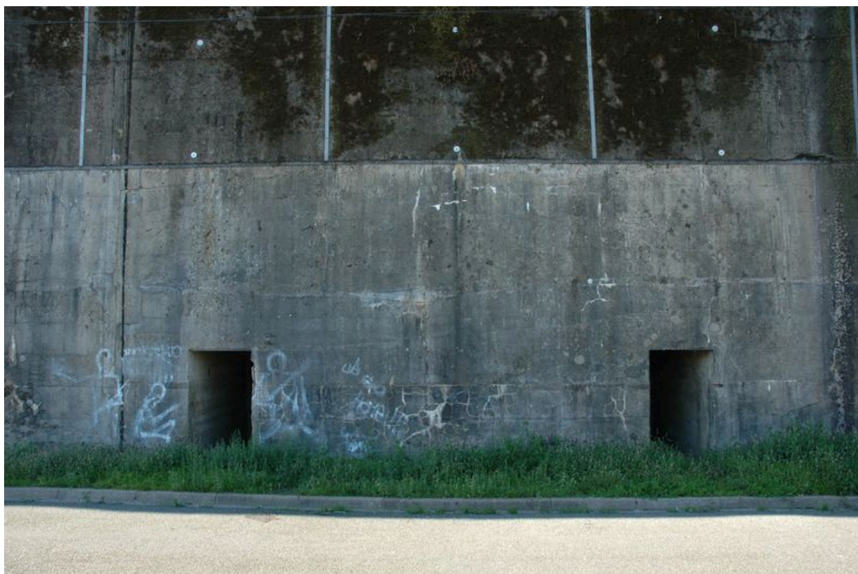
Vue de l'extension nord-est : entrées protégées (état en 2005)
