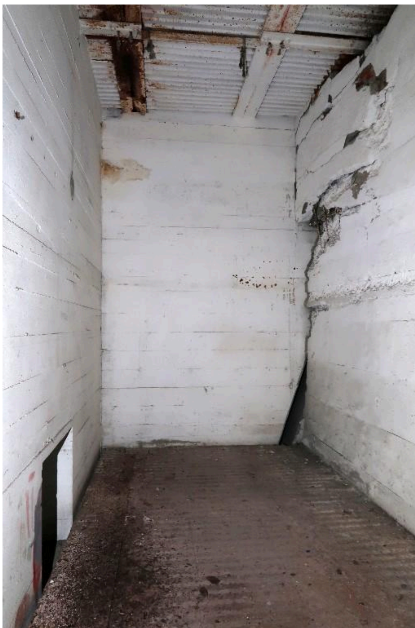
Vue de l'extension nord-ouest : deuxième étage, l'un des contreforts du bunker Keroman III englobé dans l'extension
