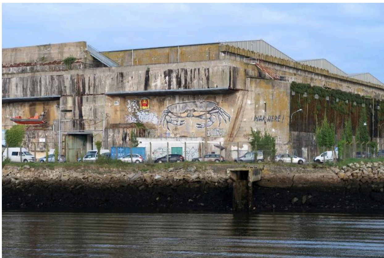
Vue de l'angle est du bunker Keroman III depuis le môle central : à gauche, l'entrée sud-est ; à droite, l'extension nord-est
