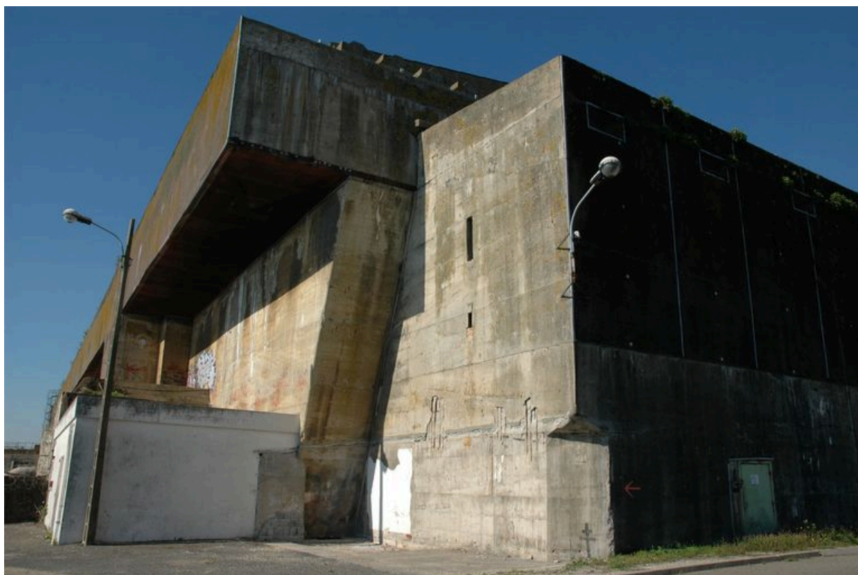
Vue de l'angle est du bunker KIII : à droite, l'extension nord-est
