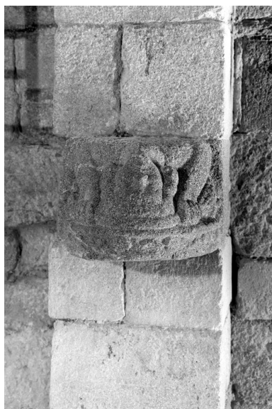
Nef, contrefort nord du mur ouest : détail du bénitier Phot. François Dagorn IVR53_19692200604V
