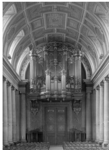
Vue intérieure prise du chœur vers la nef. Vue sur les orgues Phot. Guy Artur, Phot. Norbert Lambart IVR53_19843501200V
