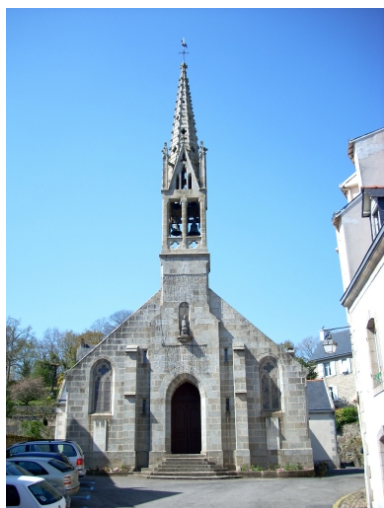
Pont-Aven, église paroissiale Saint-Joseph : élévation ouest Phot. Gwénaél Fauchille IVR53_20082905716NUCA
