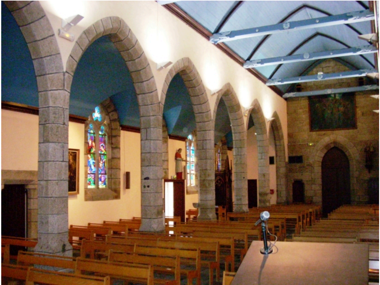
Pont-Aven, église paroissiale Saint-Joseph : vue transversale nord-ouest
