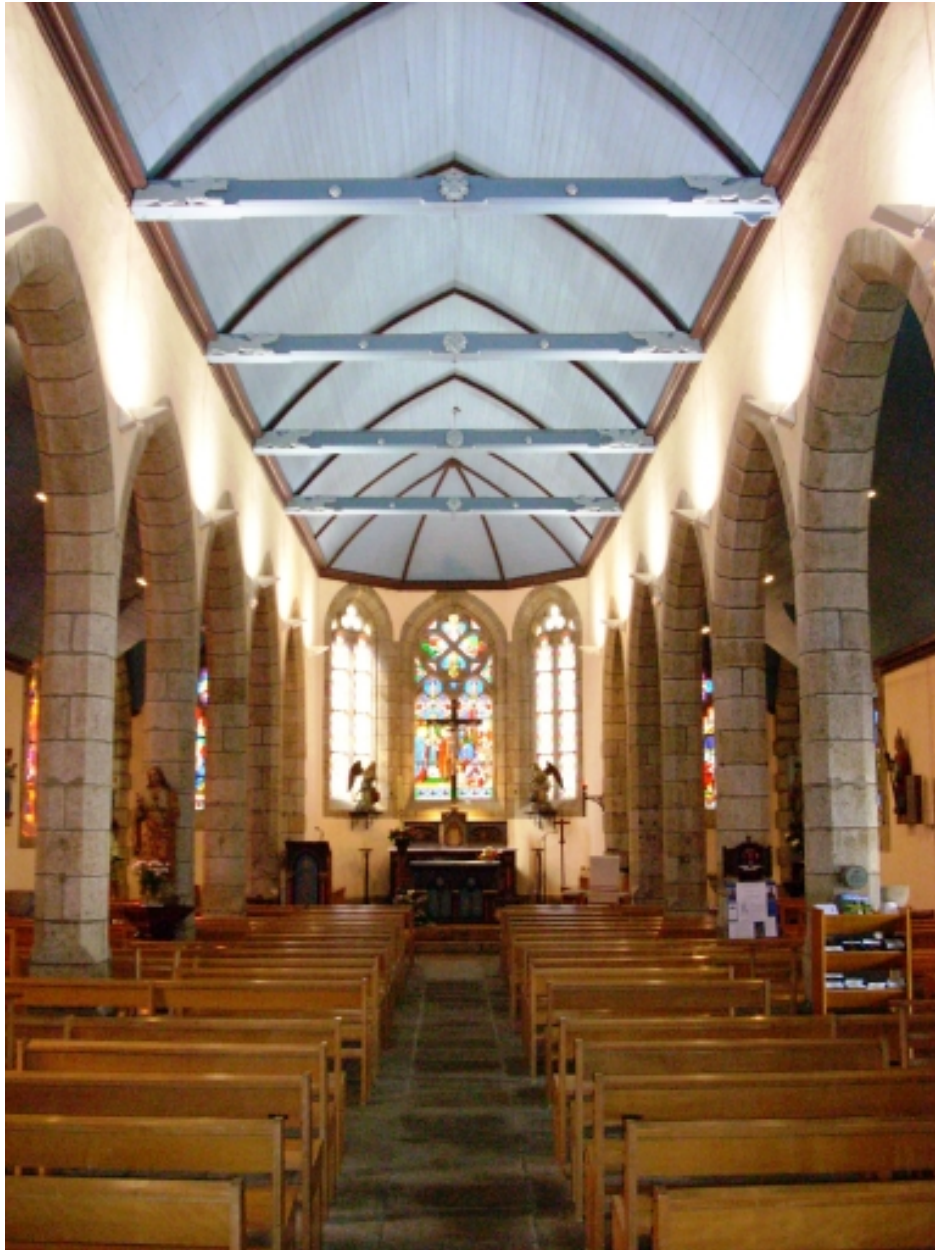
Pont-Aven, église paroissiale Saint-Joseph : vue axiale est
