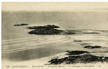
Vue du rocher Martin dans son environnement, vers 1910-1920 (carte postale, AD 22) Phot. Auteur inconnu IVR53_20082213059NUCB
