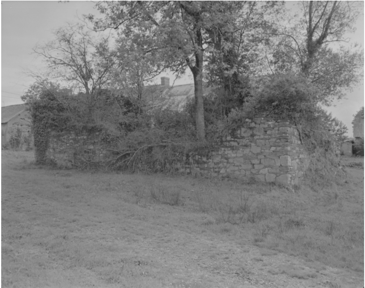
Elévation latérale : vue générale
