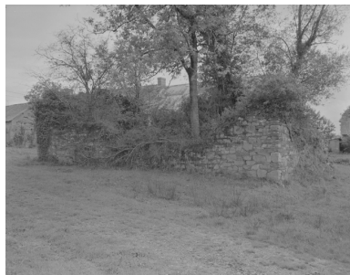
Elévation latérale : vue générale Phot. Guy Artur, Phot. Norbert Lambart IVR53_19953500521X
