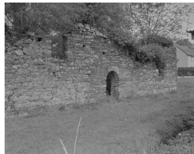
Elévation latérale : vue générale Phot. Guy Artur, Phot. Norbert Lambart IVR53_19953500523X
