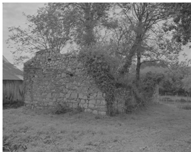
Chevet : vue générale Phot. Guy Artur, Phot. Norbert Lambart IVR53_19953500522X
