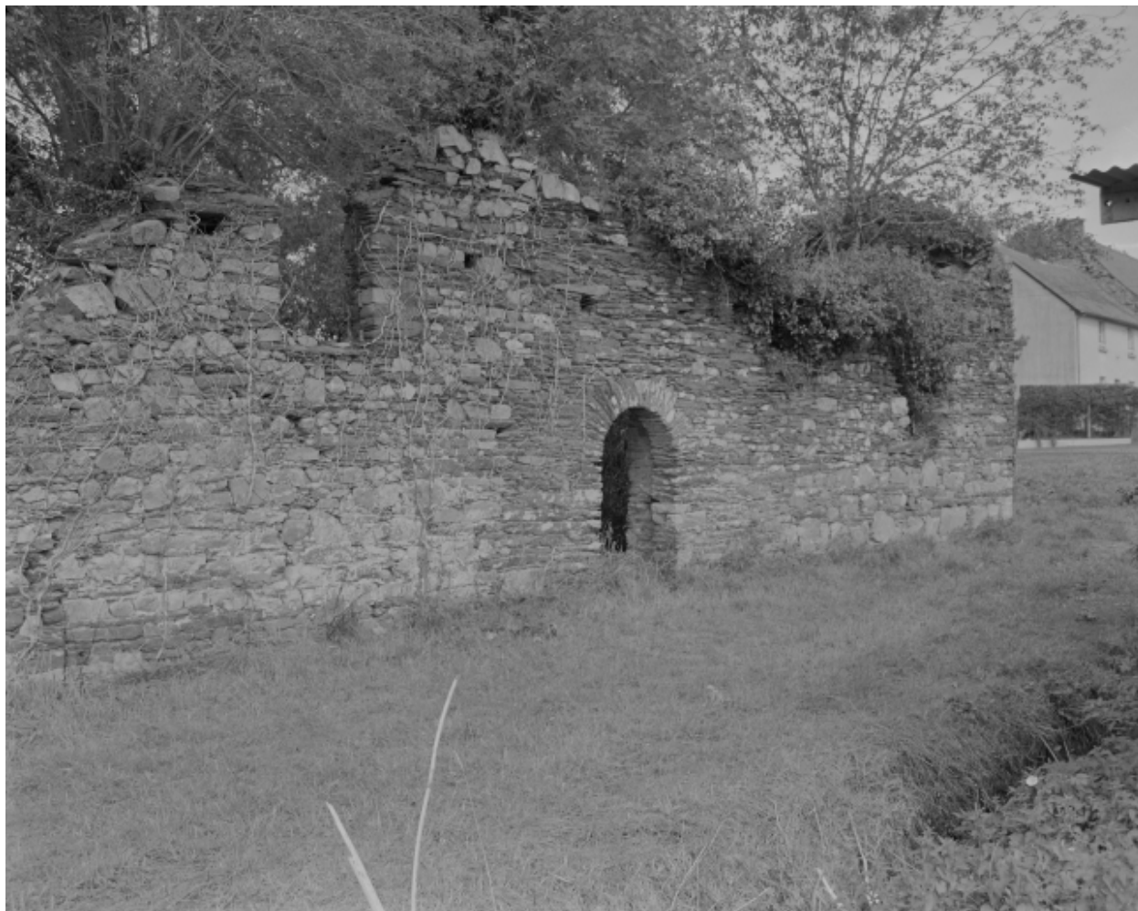
Elévation latérale : vue générale
