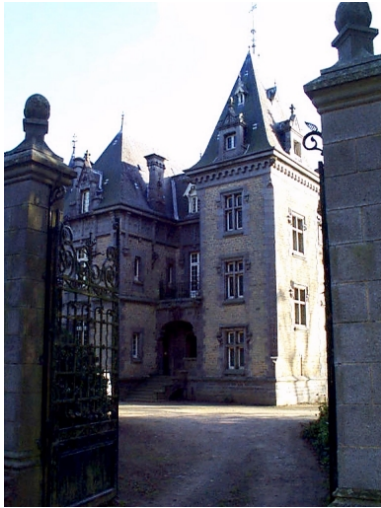
Vue partielle du château depuis la grille d'entrée Phot. Claude Quillivic IVR53_19973502686NUCA
