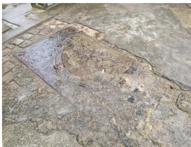
Vue des vestiges d'une sellette d'affût pour canon de 47 mm implantée au sud-ouest du phare du Minou Phot. Guillaume Lécuillier IVR53_20242910074NUCA
