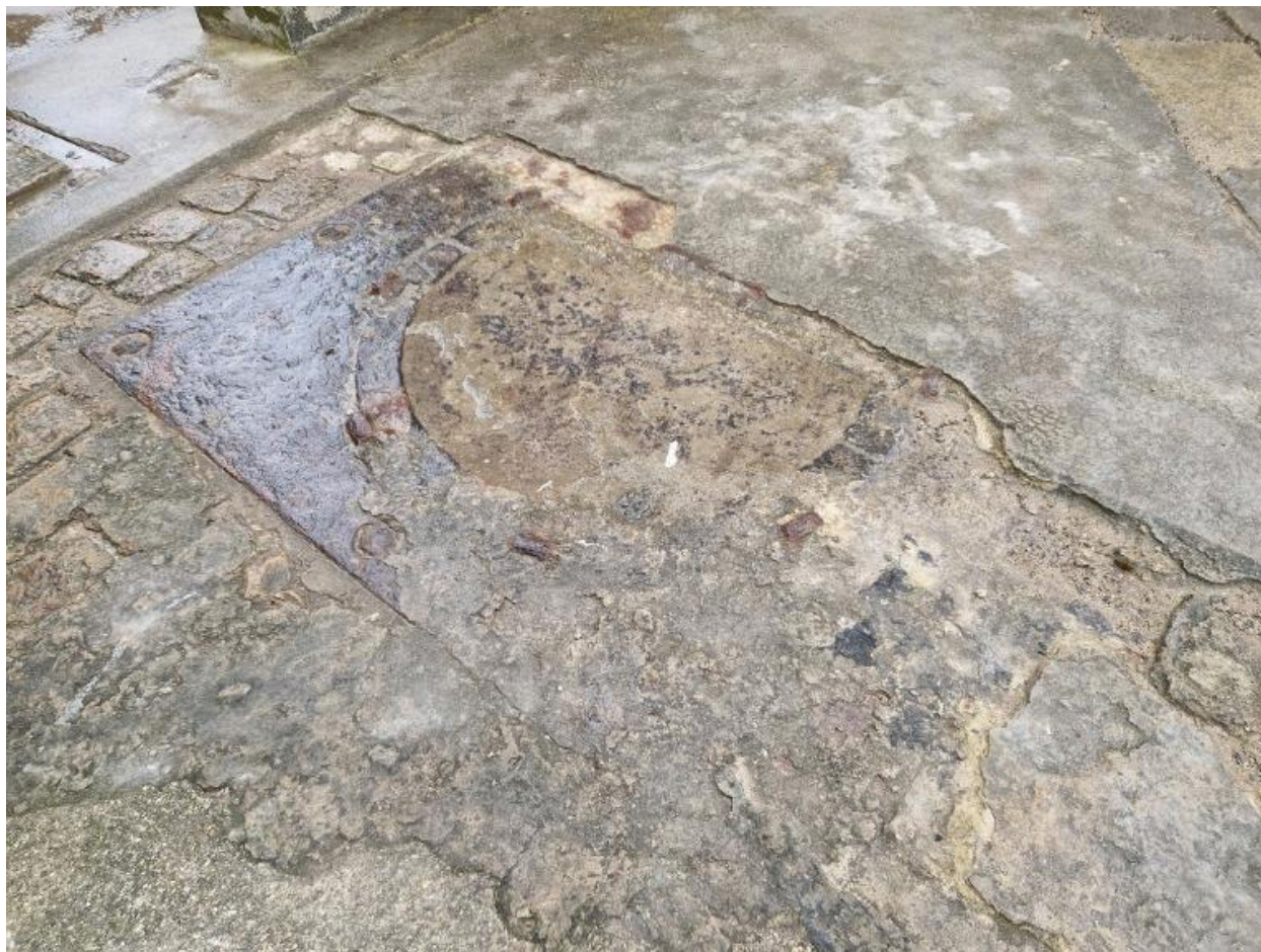
Vue des vestiges d'une sellette d'affût pour canon de 47 mm implantée au sud-ouest du phare du Minou
