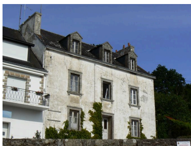
Maison 1 du Vieux Doëlan Phot. Johan Vincent IVR53_20082908623NUCA
