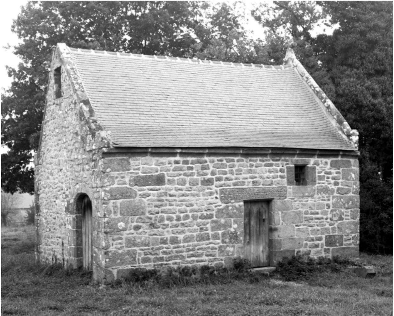
Vue générale sud
