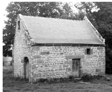
Vue générale sud Phot. Guy Artur, Phot. Norbert Lambart IVR53_19923501101X
