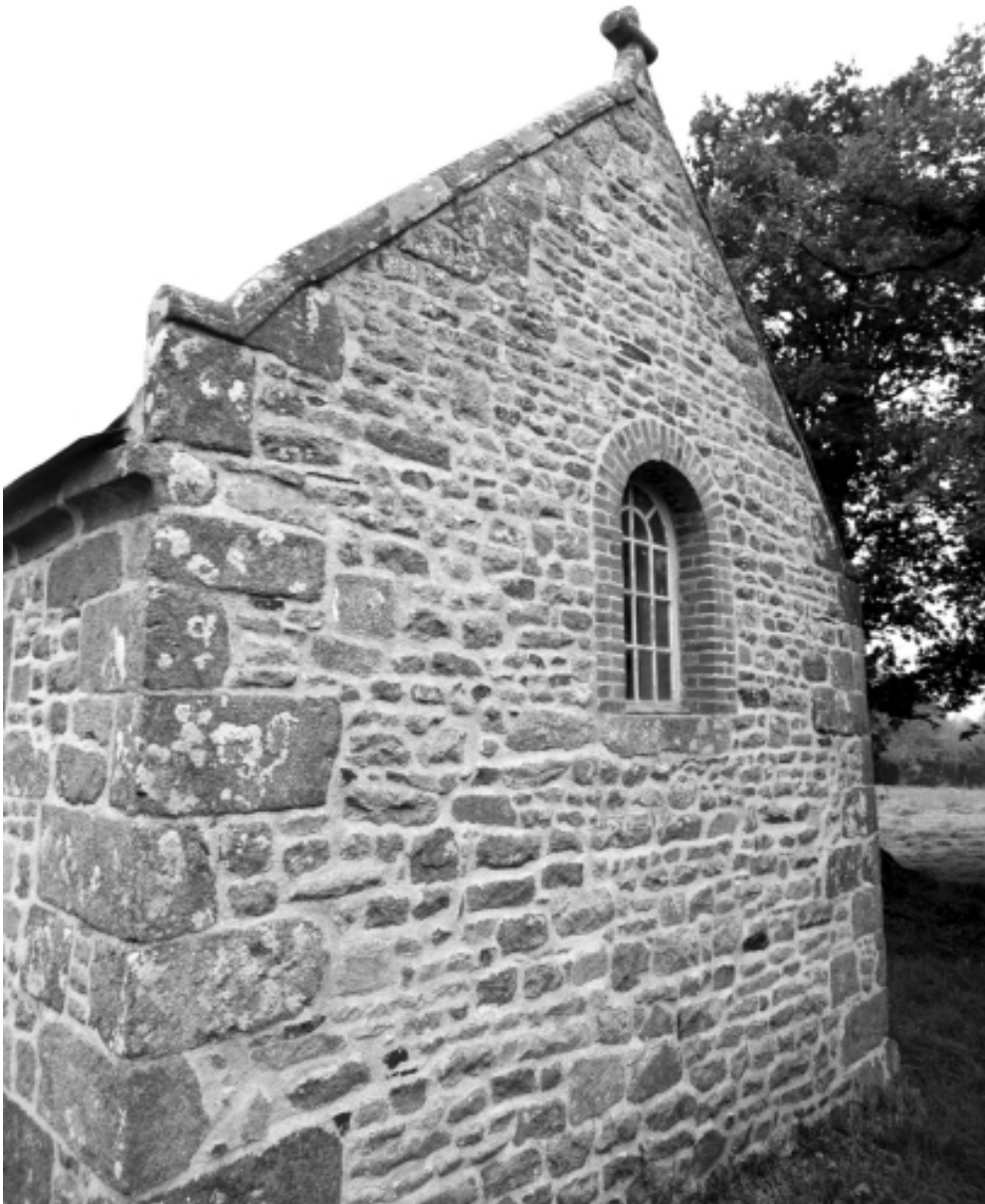
Le chevet : vue générale sud-est
