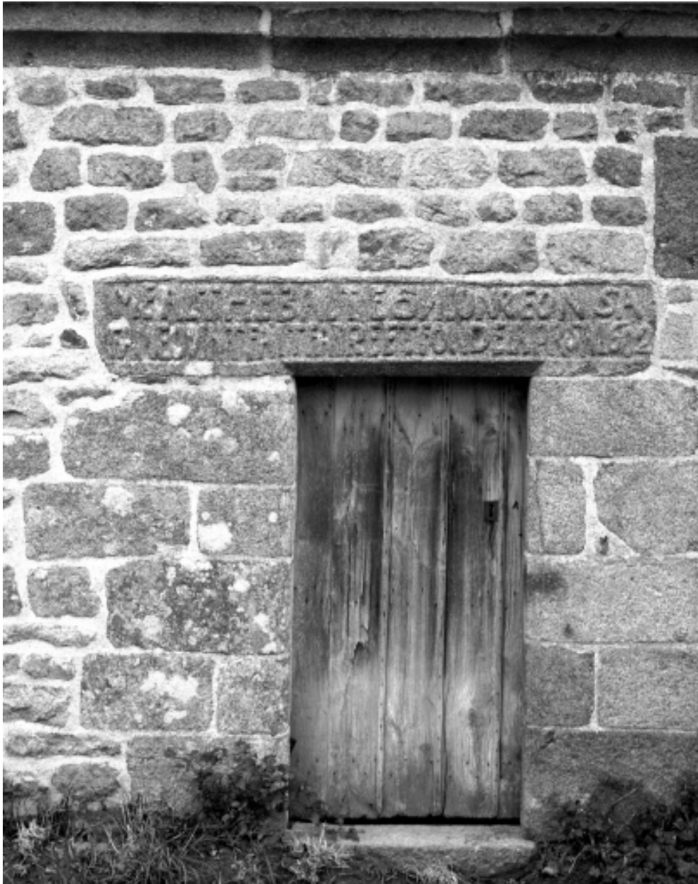
La porte sud : vue générale
