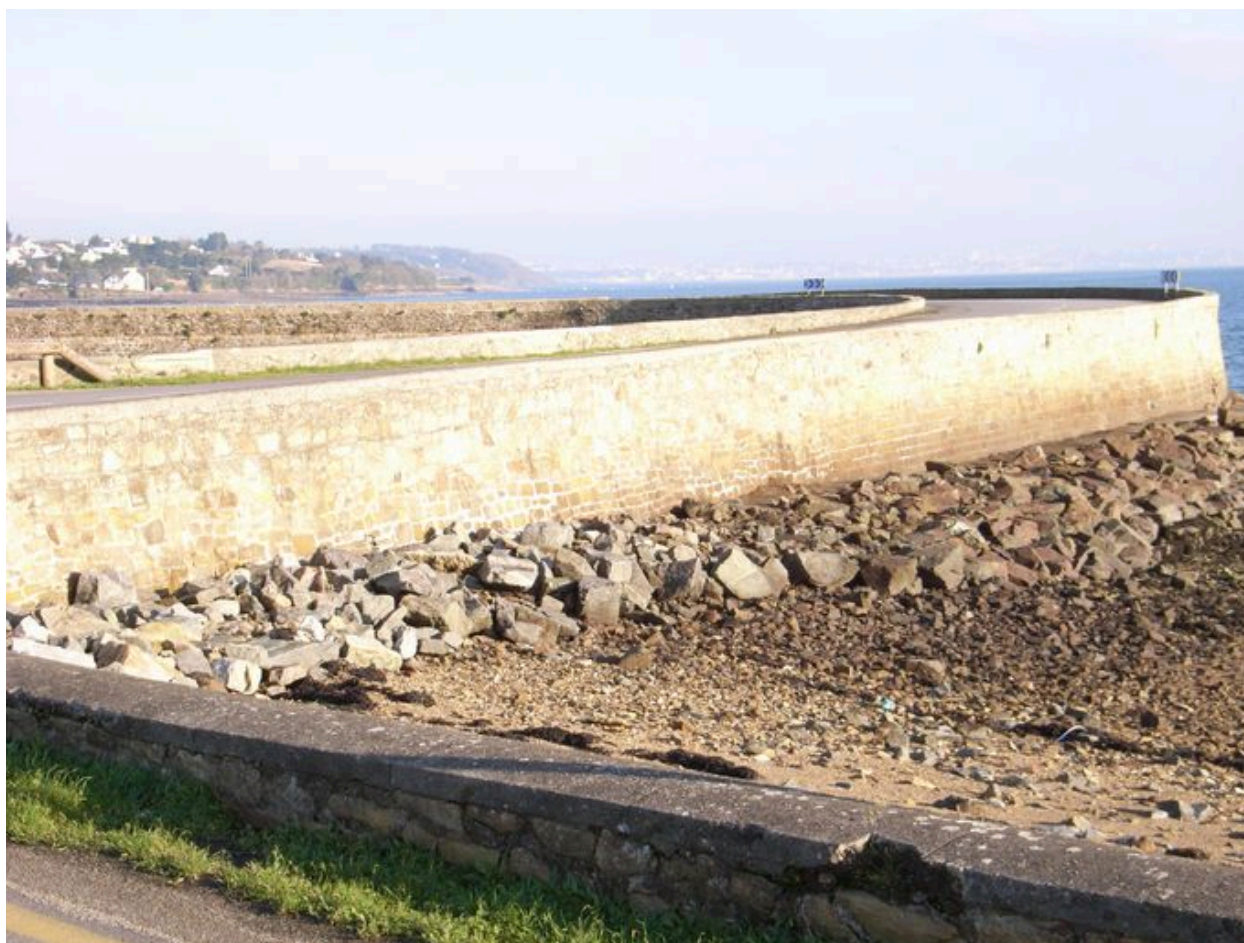
Digue-route de Quélern
