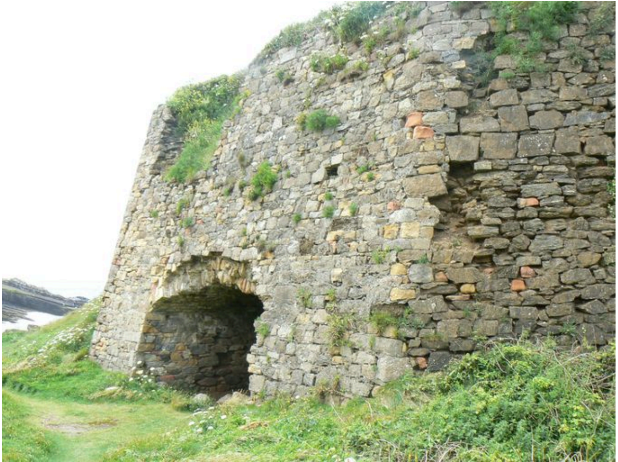
Four à chaux de la Fraternité
