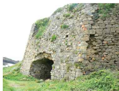
Four à chaux de la Fraternité Phot. Lénaïg L'Aot IVR53_20072908985NUCA
