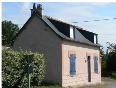
Bistrot 'Au départ du vapeur' Phot. Lénaïg L'Aot IVR53_20072908975NUCA
