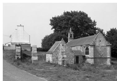
Saint-Vougay, chapelle Saint-Jean-Baptiste : chevet, vue générale, état en 1983 Phot. Guy Artur, Phot. Norbert Lambart IVR53_19832901702X
