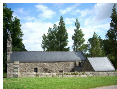
Saint-Vougay, chapelle Saint-Jean-Baptiste : élévation sud Phot. Gwénaél Fauchille IVR53_20082906519NUCA
