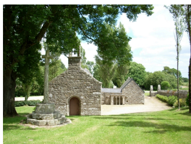
Saint-Vougay, chapelle Saint-Jean-Baptiste : vue générale ouest Phot. Gwénaél Fauchille IVR53_20082906517NUCA
