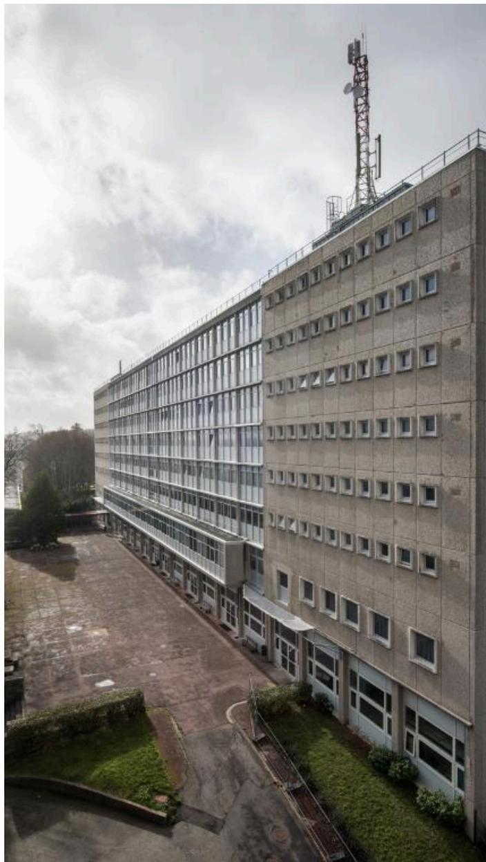
Façade sud-est du bâtiment D, grande barre d'internat de 8 niveaux. Raymond Lopez architecte, 1958. Noter l'alternance des matériaux entre les parties réservées aux sanitaires (premier plan) : "plaques de 80 cm en béton armé avec face extérieure de béton dans lequel sont incorporés des éléments de pierre et de granit d'Orient" et celles réservées aux dortoirs (second plan) : "éléments Jean Prouvé".
