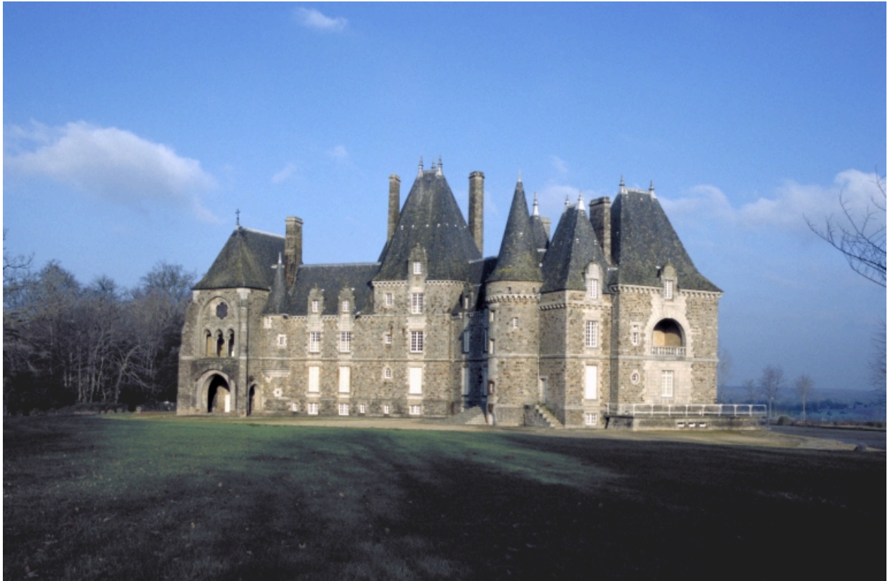
Vue générale, façade antérieure, vue rapprochée
