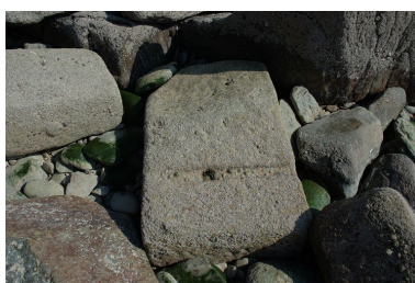
Vue de la batterie basse du Mengant : extrémité ouest ruinée Phot. Guillaume Lécueillier IVR53_20072905848NUCA
