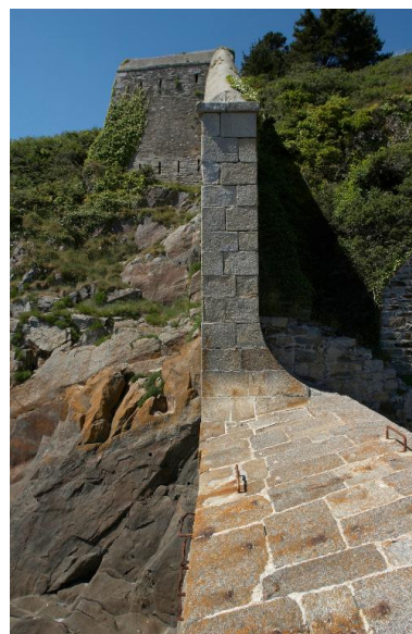
Plouzané : vue du fort du Mengant, mur d'enceinte dit branche tombante ouest percée de créneaux de mousqueterie et escalier parallèle Phot. Bernard Bègne IVR53_20122901635NUCA
