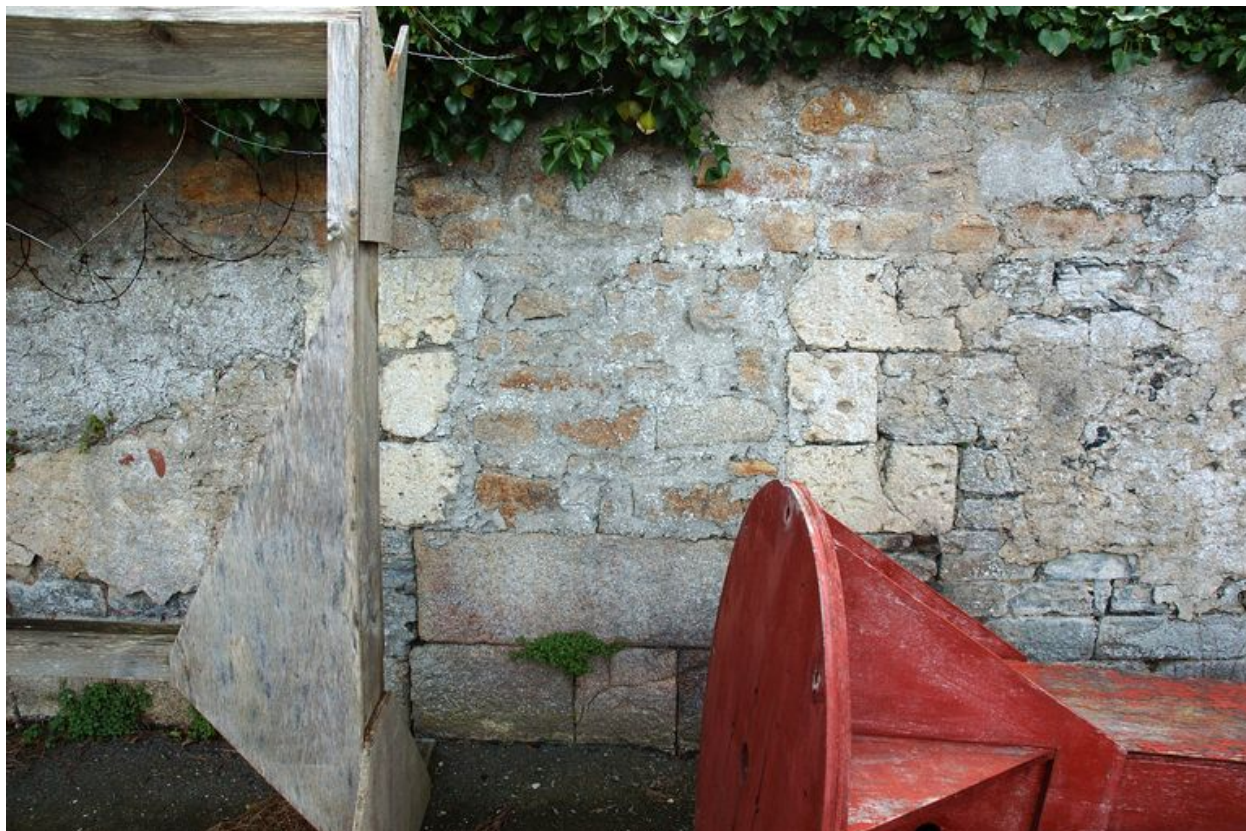
Vue de la batterie haute du Mengant : embrasure murée
