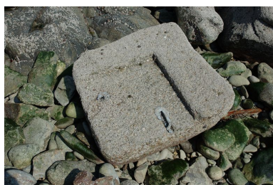
Vue de la batterie basse du Mengant : extrémité ouest ruinée Phot. Guillaume Lécueillier IVR53_20072905850NUCA
