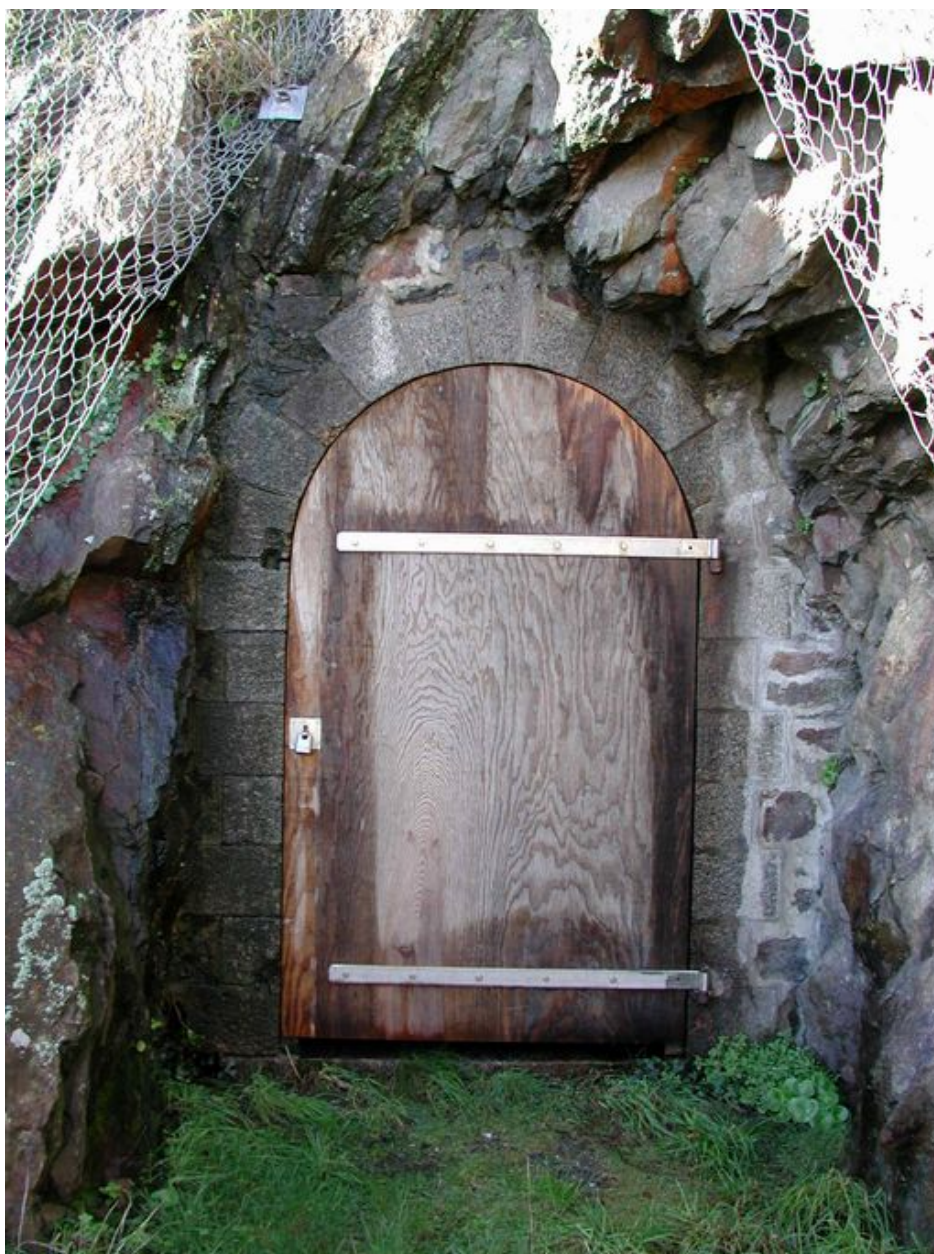
Vue du fort du Mengant : petit magasin à munitions sous roc
