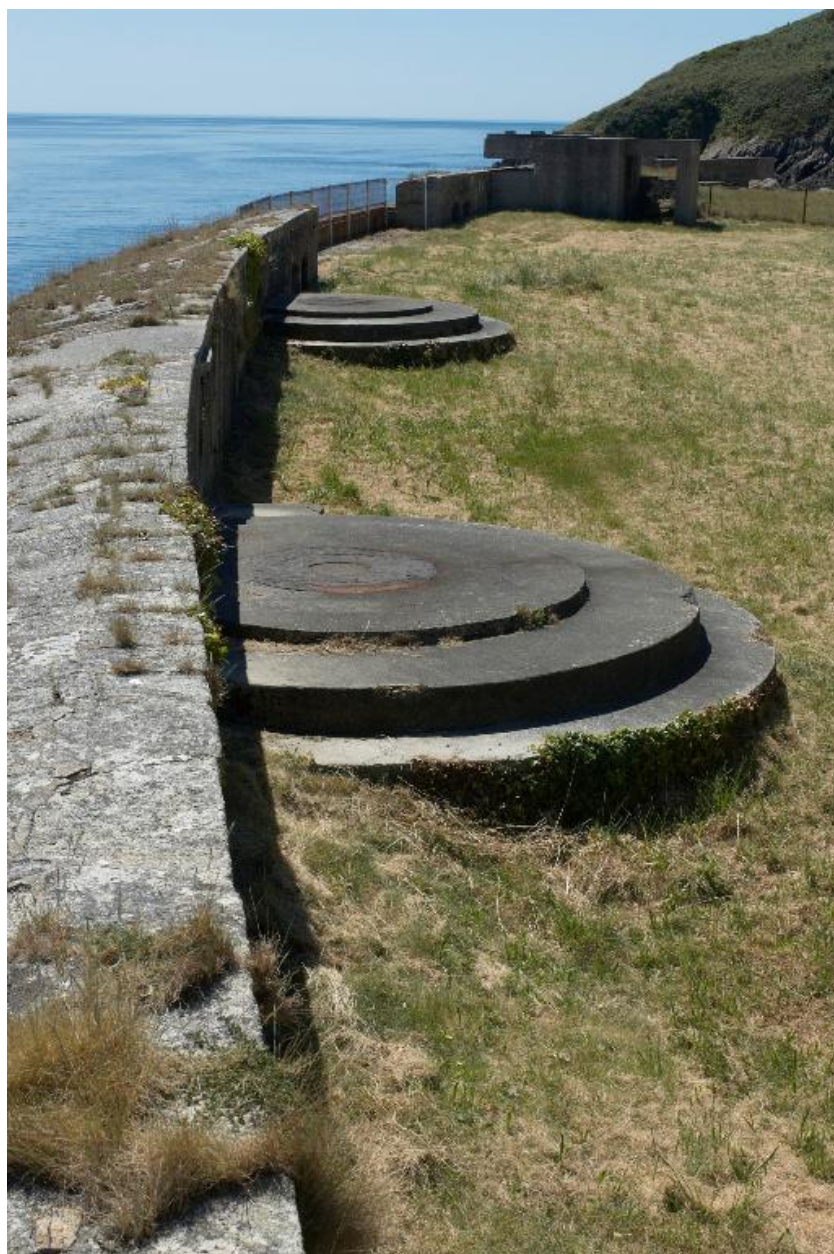
Plouzané : vue du fort du Mengant, détail de la batterie basse, plate-formes bétonnées pour canon
