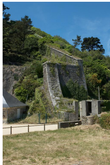
Plouzané : vue du fort du Mengant, mur d'enceinte dit branche tombante est percée de créneaux de mousqueterie et escalier parallèle Phot. Bernard Bègne IVR53_20122901591NUCA
