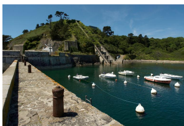
Plouzané : vue du fort du Mengant, môle construit en 1877 dans l'anse Phot. Bernard Bègne IVR53_20122901596NUCA
