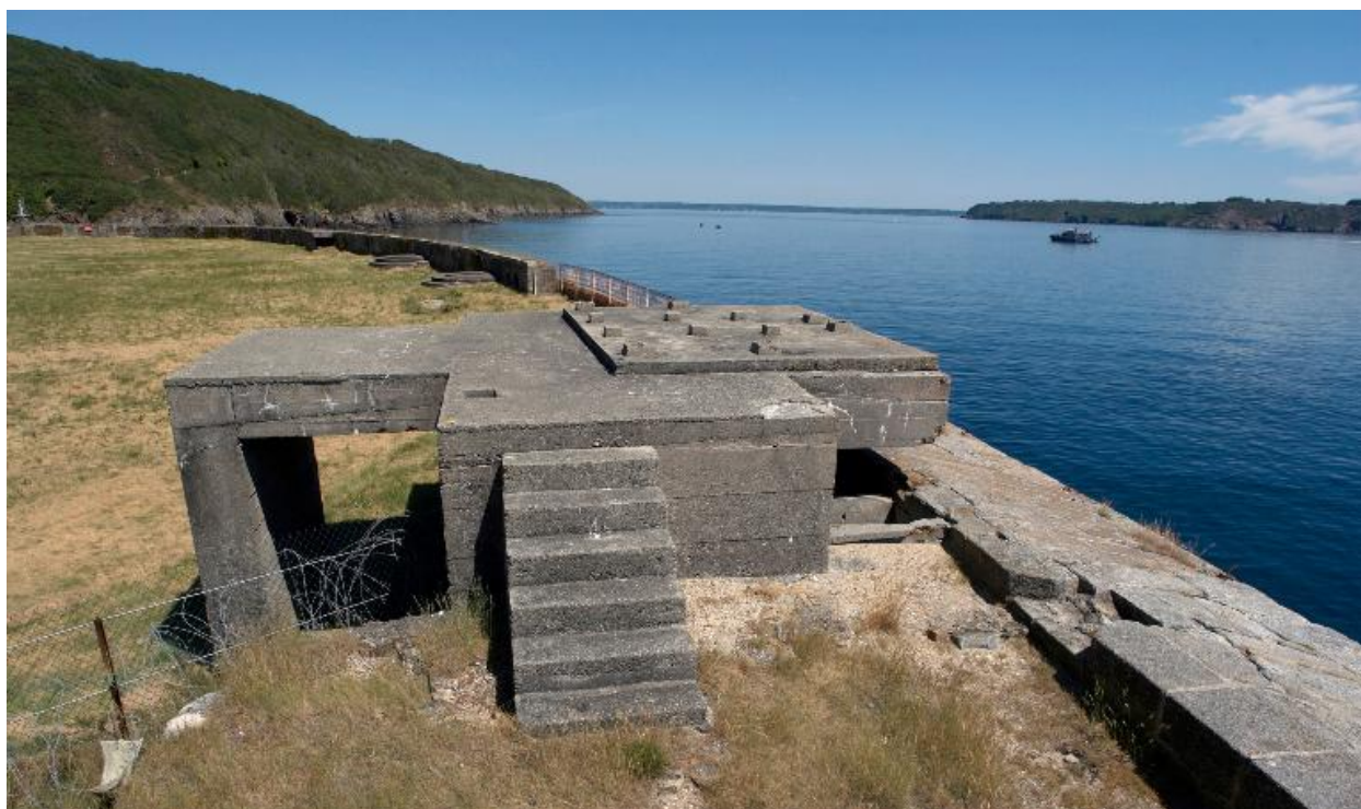
Plouzané : vue du fort du Mengant, détail de la batterie basse, parapet et poste de combat en béton armé (vraisemblablement allemand)
