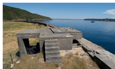
Plouzané : vue du fort du Mengant, détail de la batterie basse, parapet et poste de combat en béton armé (vraisemblablement allemand) Phot. Bernard Bègne IVR53_20122901620NUCA
