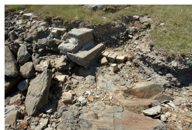
Plouzané : vue du fort du Mengant, détail de la batterie basse, extrémité ouest ruinée, niveau de sol primitif Phot. Bernard Bègne
