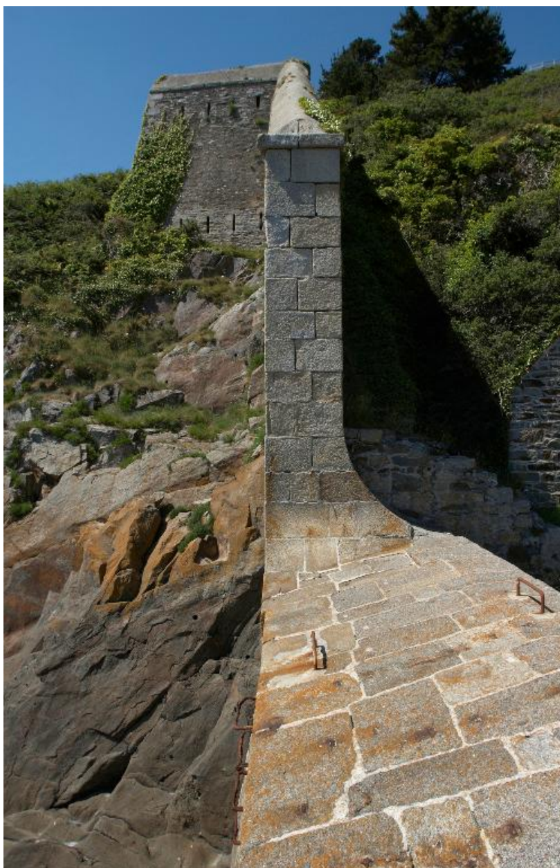
Plouzané : vue du fort du Mengant, mur d'enceinte dit branche tombante ouest percée de créneaux de mousqueterie et escalier parallèle
