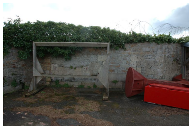
Vue de la batterie haute du Mengant : piedroits, embrasure murée Phot. Guillaume Lécueillier IVR53_20072905867NUCA
