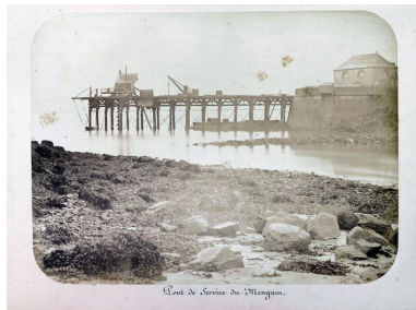
Vue du fort du Mengant en 1877 : chantier de construction du môle d'accostage Repro. Archives municipales et communautaires. Brest Métropole Océane IVR53_20062907423NUCA
