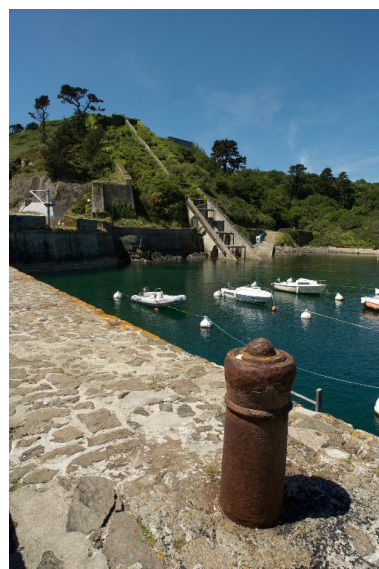
Plouzané : vue du fort du Mengant, môle construit en 1877 dans l'anse Phot. Bernard Bègne IVR53_20122901598NUCA
