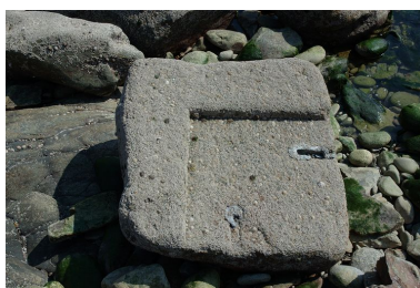
Vue de la batterie basse du Mengant : extrémité ouest ruinée Phot. Guillaume Lécueillier IVR53_20072905853NUCA
