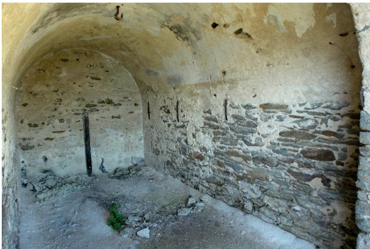
Plouzané : vue du fort du Mengant, abri de jour du projecteur, intérieur
