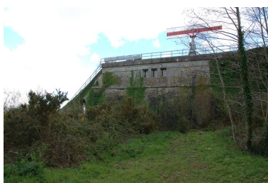
Vue de la batterie haute du Mengant : angle nord-est, vestiges d'un cul de lampe pentagonal d'échauguette Phot. Guillaume Lécueillier IVR53_20072905865NUCA
