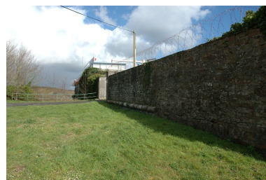
Vue de la batterie haute du Mengant : entrée. Situé au ras du sol du fait du comblement des fossés, le cordon Phot. Guillaume Lécueillier IVR53_20072905863NUCA
