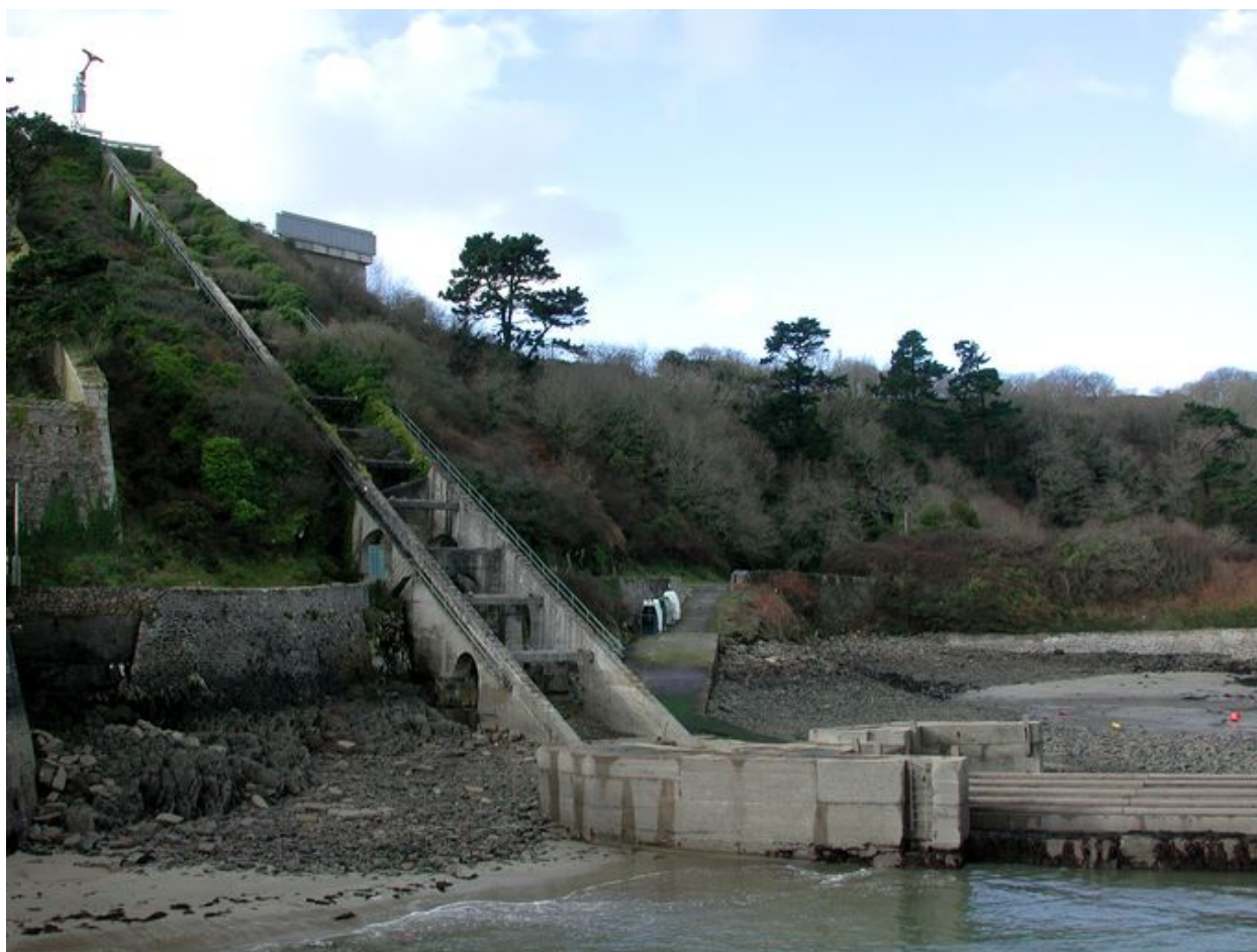
Vue du fort du Mengant depuis le môle construit en 1877 : partie basse du funiculaire, môle de translation
