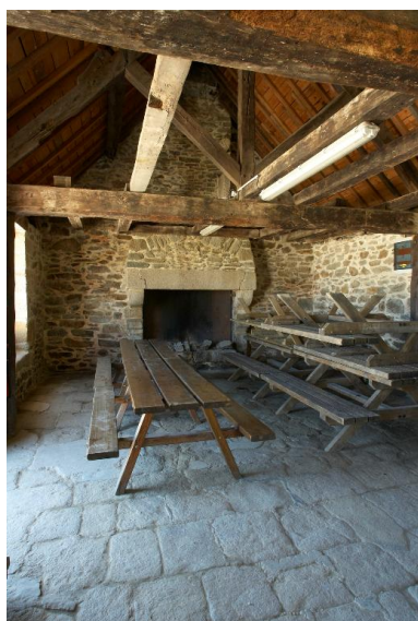
Plouzané : vue du fort du Mengant, corps de garde, cheminée et poutres Phot. Bernard Bègne IVR53_20122901644NUCA
