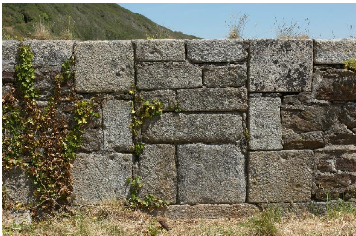
Plouzané : vue du fort du Mengant, détail de la batterie basse, embrasure murée
