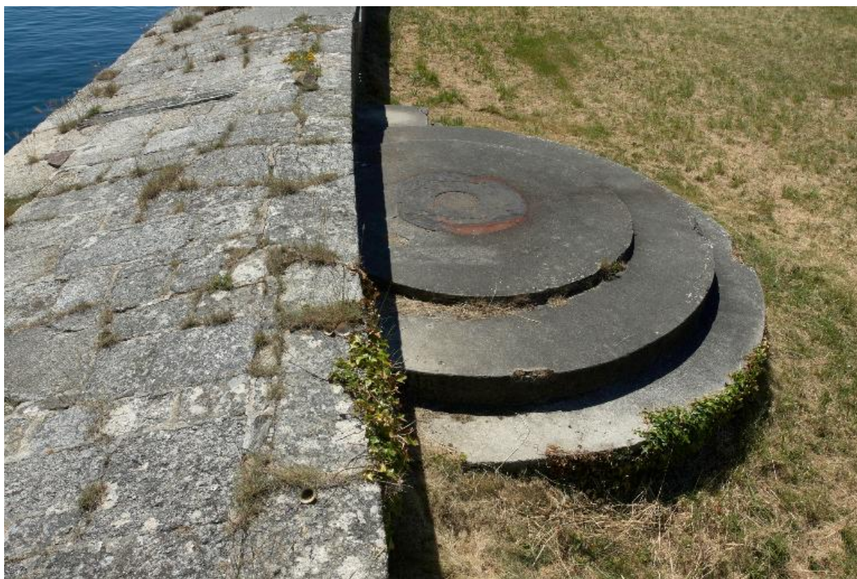
Plouzané : vue du fort du Mengant, détail de la batterie basse, plate-forme bétonnée pour canon
