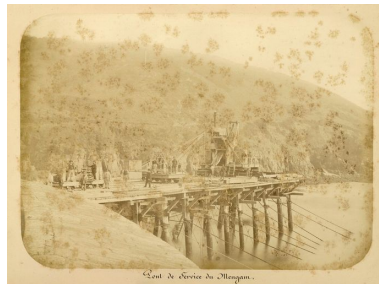
Vue du fort du Mengant en 1877 : chantier de construction du môle d'accostage Repro. Archives municipales et communautaires. Brest Métropole Océane IVR53_20062907427NUCA
