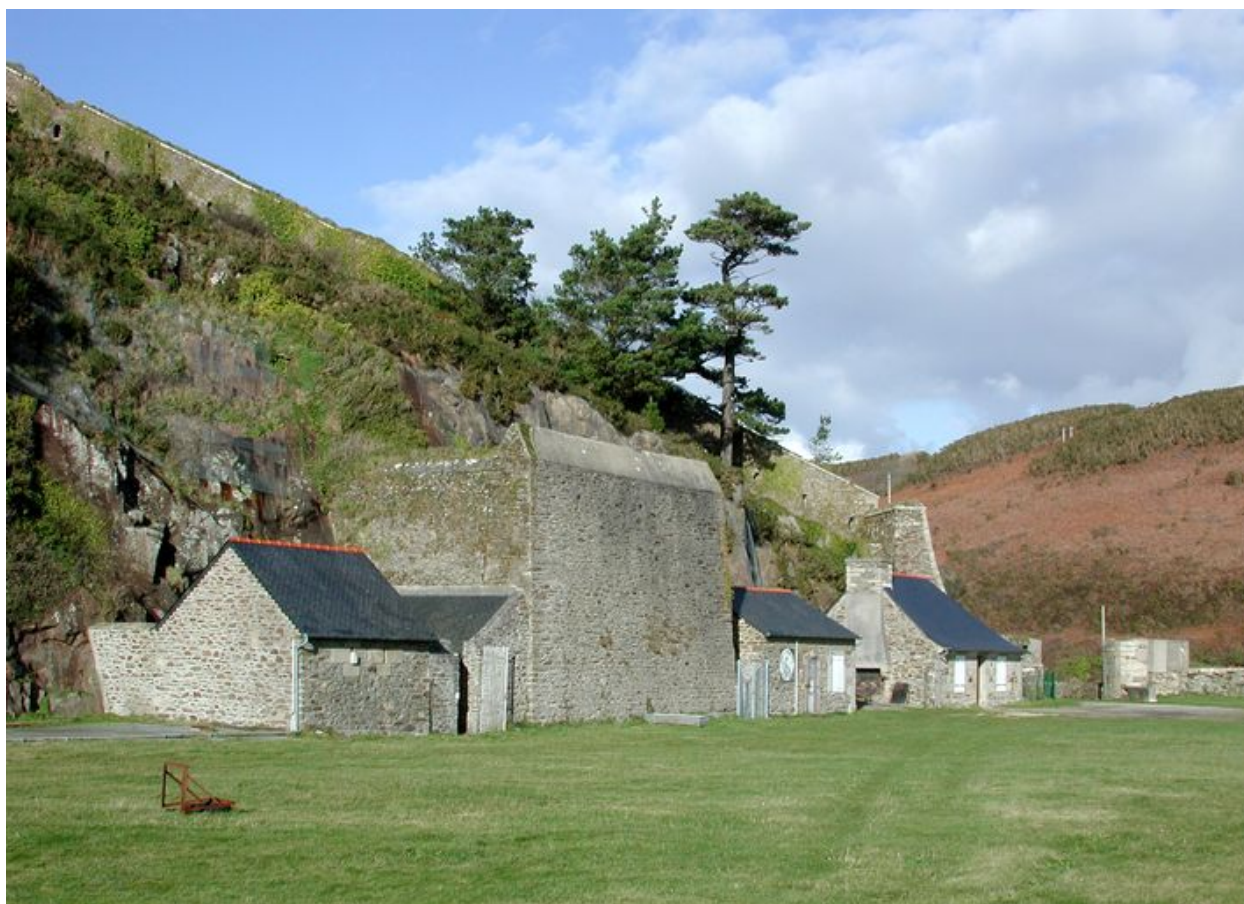
Vue du fort du Mengant : bâtiments en alignement orientés est-ouest (respectivement, corps de garde, remise et magasin à poudre) et adossés à la falaise. Au centre : traverse en maçonnerie protégeant l'usine électrique
