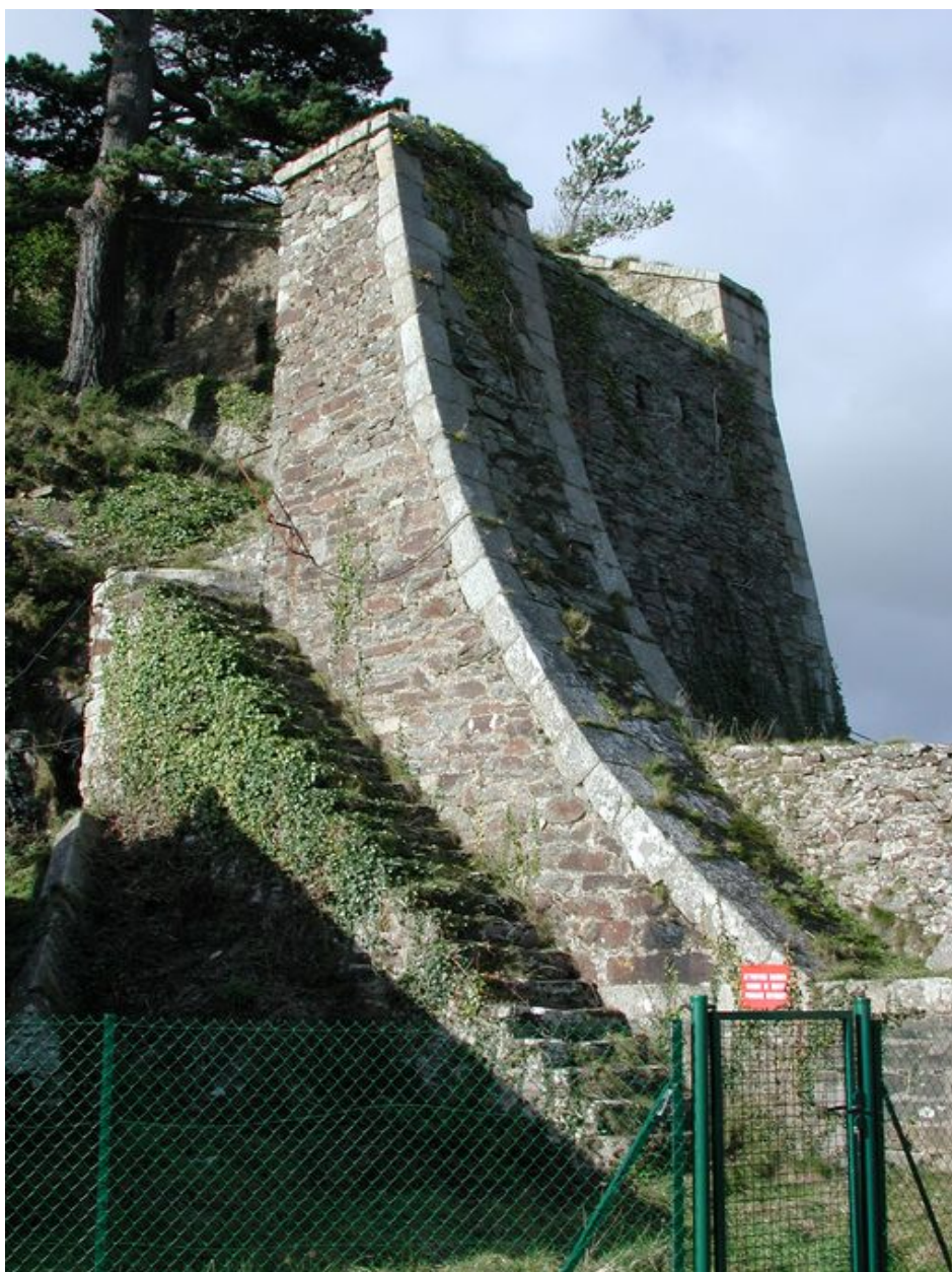
Vue du fort du Mengant : mur d'enceinte dit branche tombante percée de créneaux de mousqueterie et escalier parallèle
