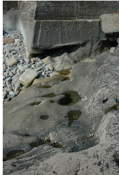
Vue de la batterie basse du Mengant : extrémité ouest ruinée Phot. Guillaume Lécueillier IVR53_20072905834NUCA
