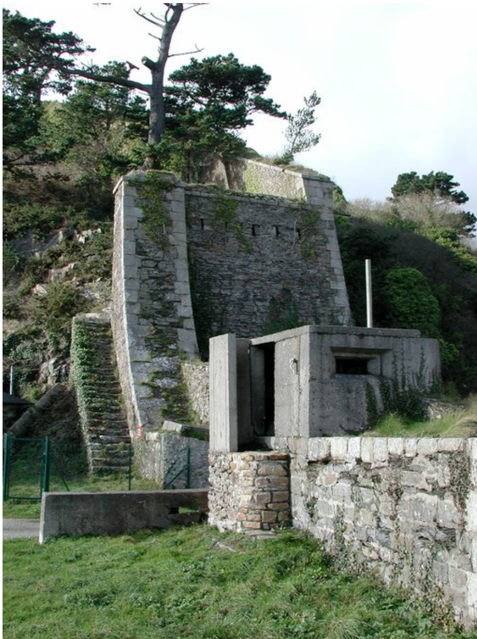
Vue du fort du Mengant : entrée de la batterie basse flanquée par la branche tombante. Ouvrage bétonné allemand protégeant l'entrée
