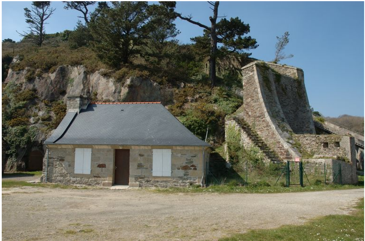
Vue du fort du Mengant : bâtiment couvert à deux pans à coyaux en ardoises et renseigné en 1696 comme logements des canonniers, halle et corps de garde
