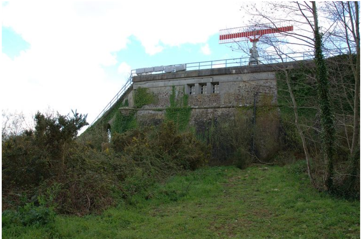
Vue de la batterie haute du Mengant : angle nord-est, vestiges d'un cul de lampe pentagonal d'échauguette
