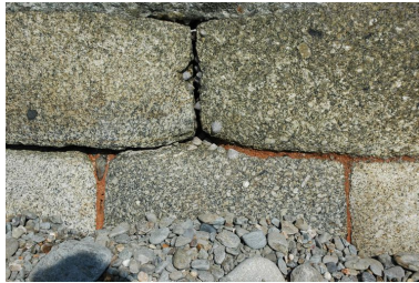
Vue de la batterie basse du Mengant : extrémité ouest ruinée Phot. Guillaume Lécueillier IVR53_20072905833NUCA
