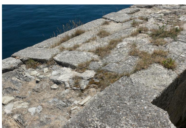
Plouzané : vue du fort du Mengant, détail de la batterie basse, parapet Phot. Bernard Bègne IVR53_20122901609NUCA
