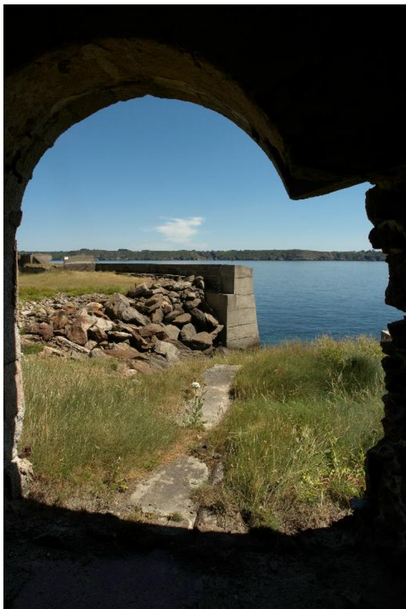
Plouzané : vue du fort du Mengant, abri de jour du projecteur
