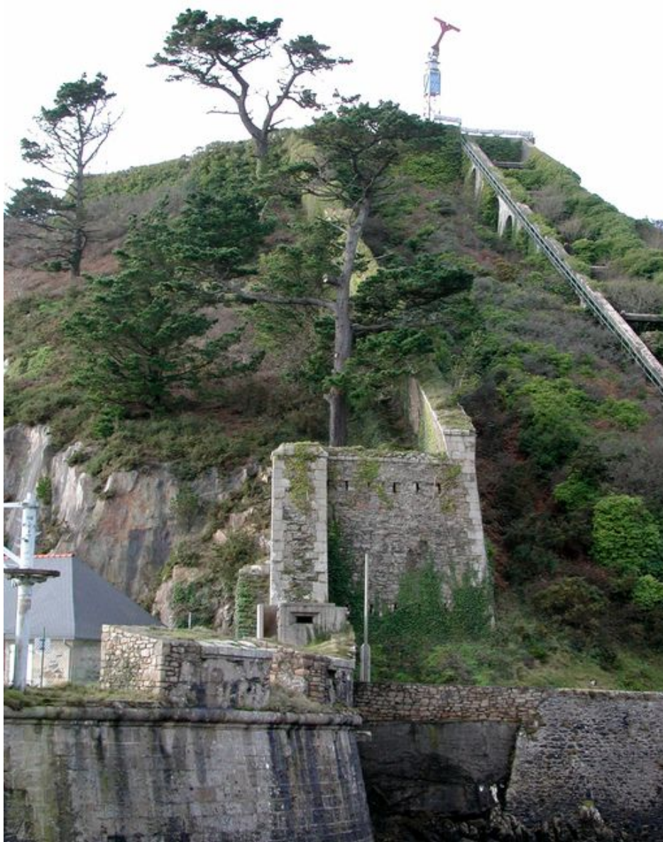
Vue du fort du Mengant depuis le môle construit en 1877 : entrée de la batterie basse flanquée par la branche tombante, funiculaire
