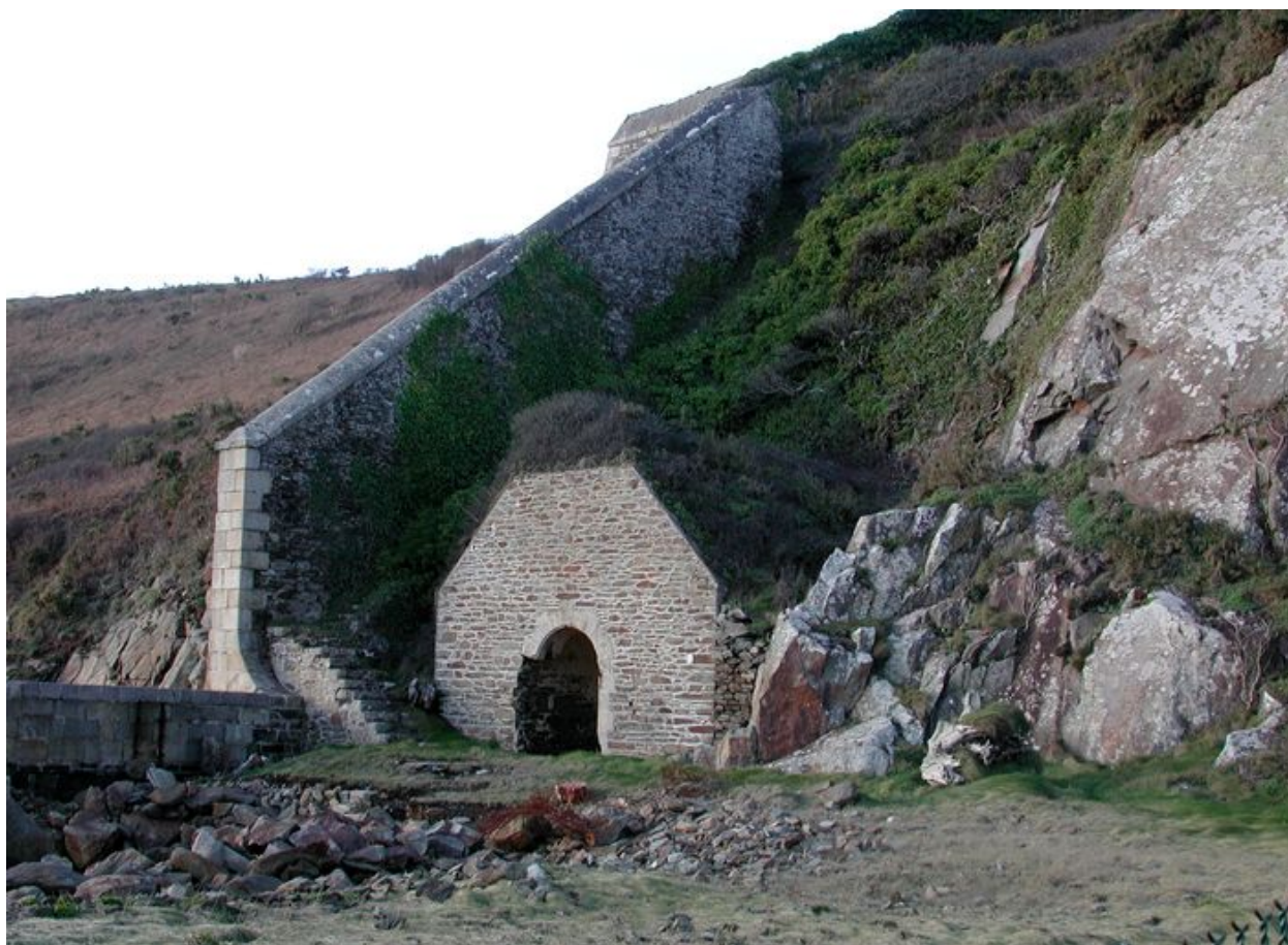
Vue du fort du Mengant : abri de jour du projecteur
