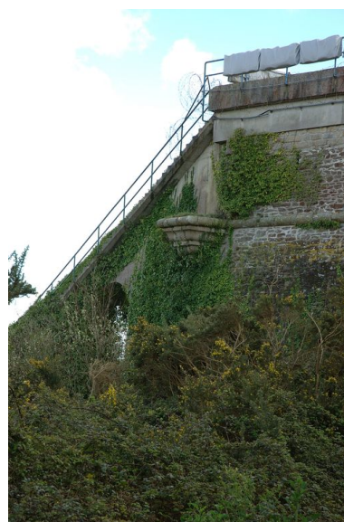
Vue de la batterie haute du Mengant : angle nord-est, vestiges d'un cul de lampe pentagonal d'échauguette
