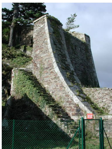
Vue du fort du Mengant : mur d'enceinte dit branche tombante percée de créneaux de mousqueterie et escalier parallèle Phot. Guillaume Lécueillier IVR53_20052903318NUCA
