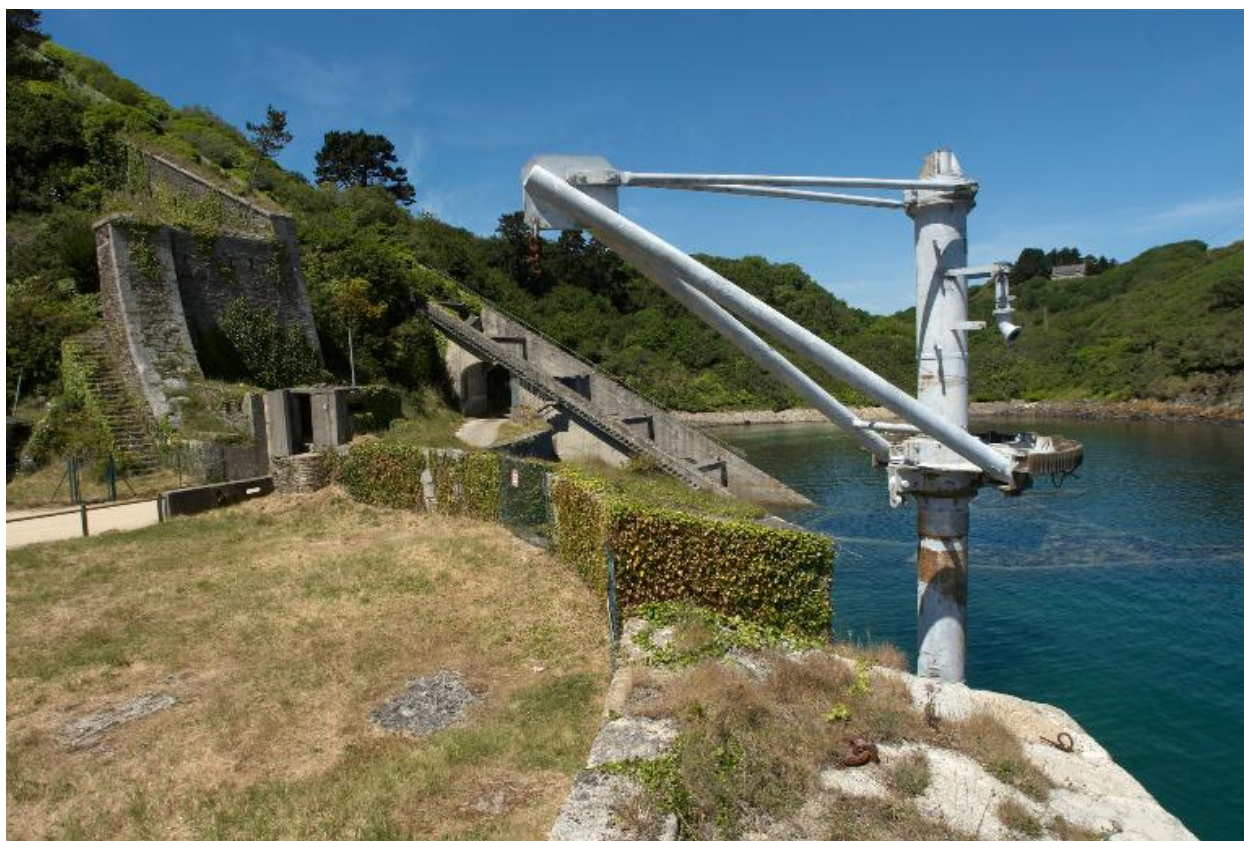
Plouzané : vue du fort du Mengant, détail de la batterie basse, parapet et grue servant à la manutention
