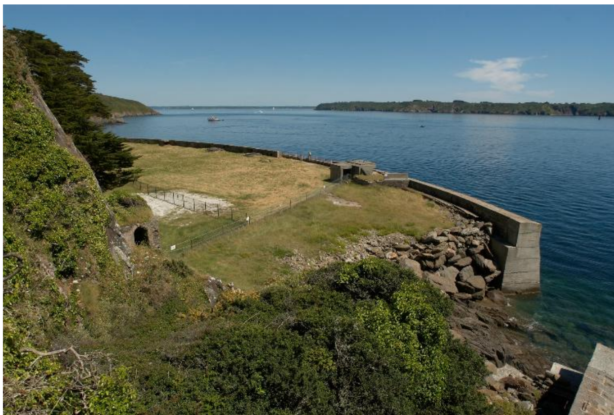
Plouzané : vue du fort du Mengant, abri
