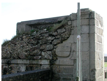
Vue du fort du Mengant : pilier d'entrée de la batterie basse intégré dans un ouvrage bétonné allemand protégeant l'entrée Phot. Guillaume Lécueillier IVR53_20052903319NUCA
