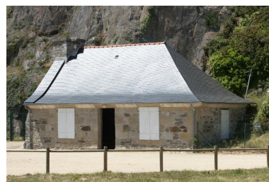
Plouzané : vue du fort du Mengant, corps de garde Phot. Bernard Bègne IVR53_20122901606NUCA
