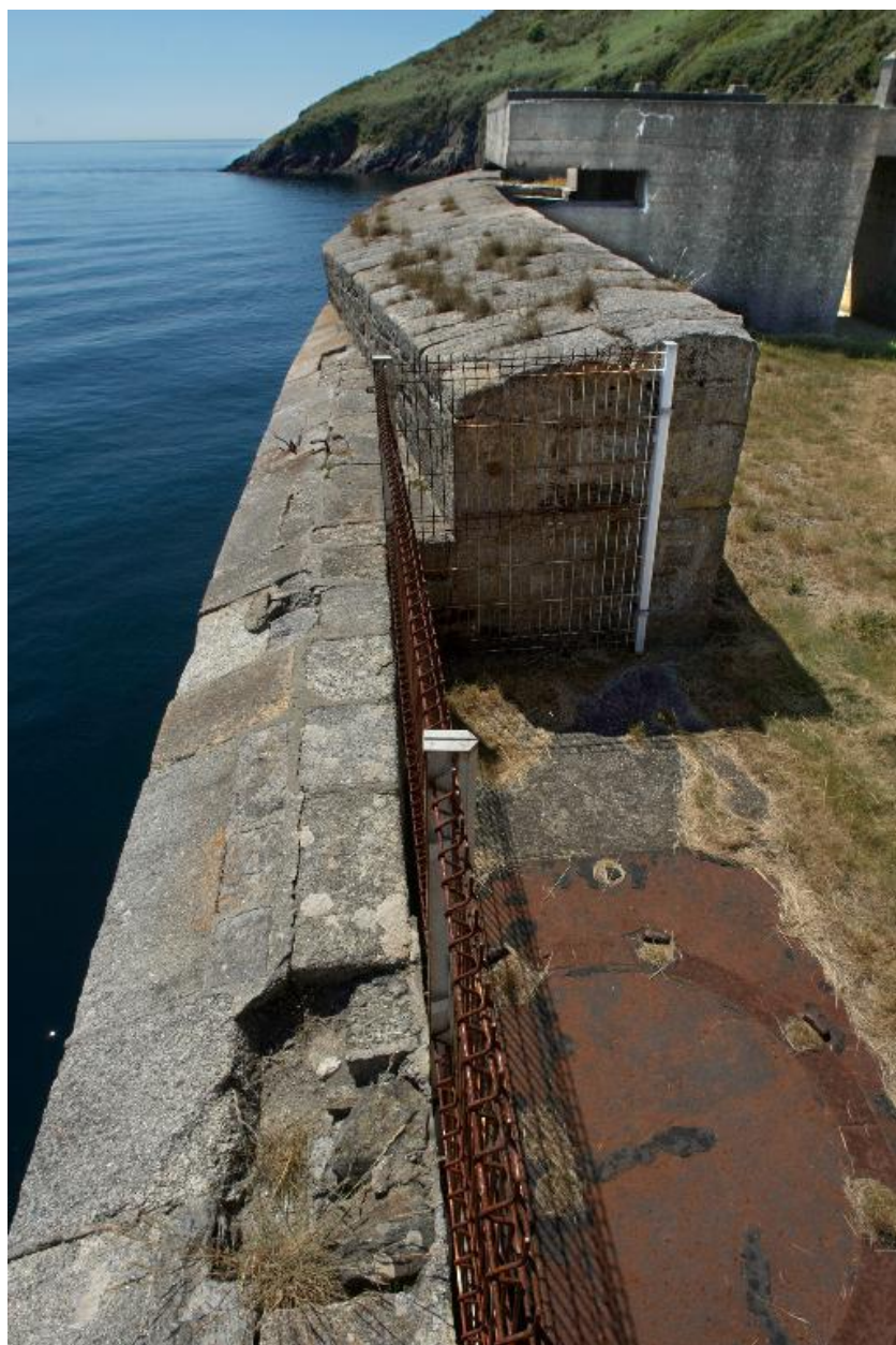
Plouzané : vue du fort du Mengant, détail de la batterie basse, sous-selle d'affût pour canon de 47 mm à tir rapide, parapet et poste de combat (vraisemblablement allemand)
