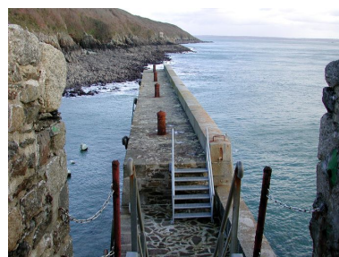
Vue du fort du Mengant : môle, quatre canons-bollards permettaient de capeler l'oeil des amarres Phot. Guillaume Lécueillier IVR53_20052903320NUCA
