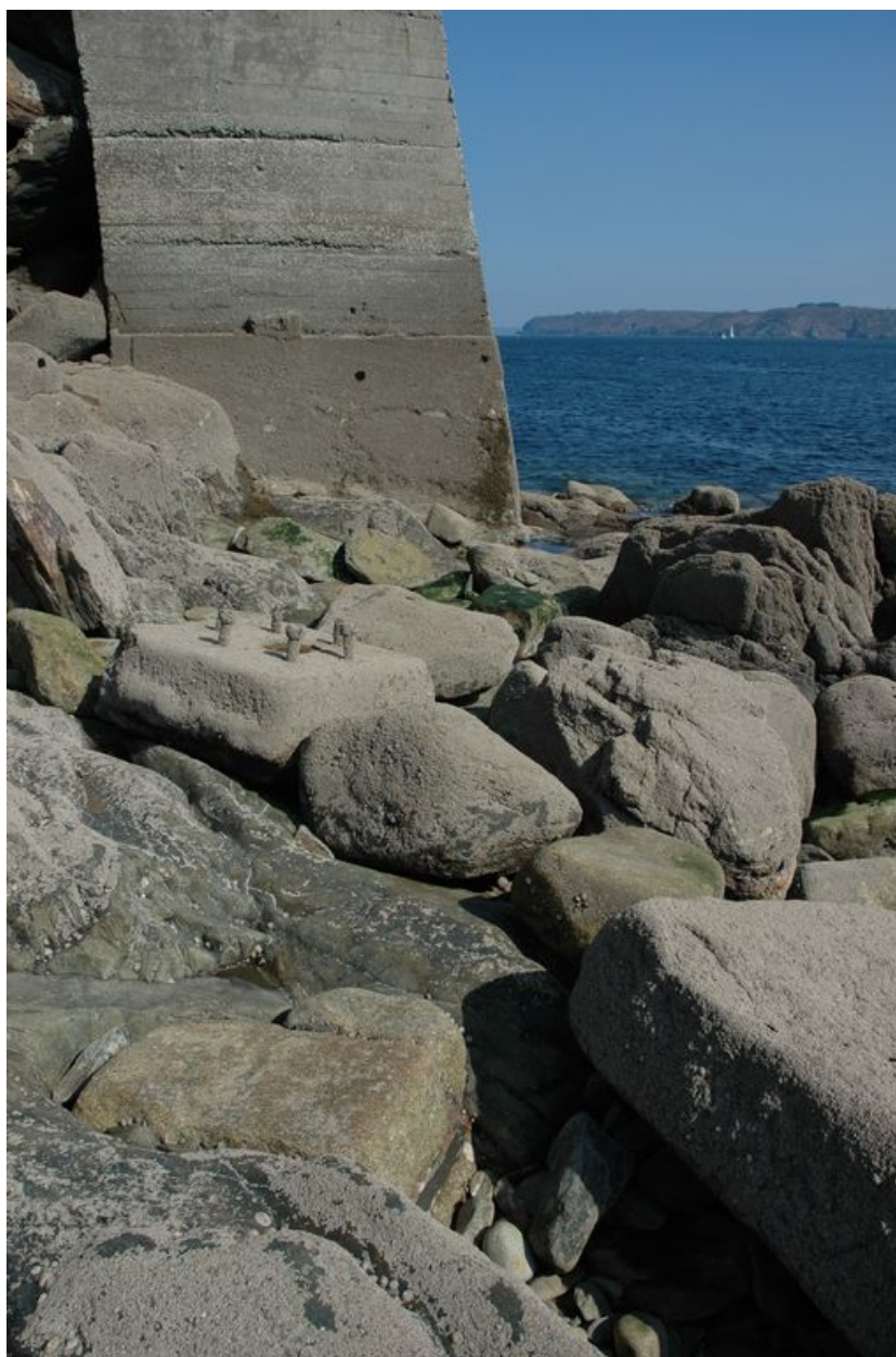
Vue de la batterie basse du Mengant : extrémité ouest ruinée
