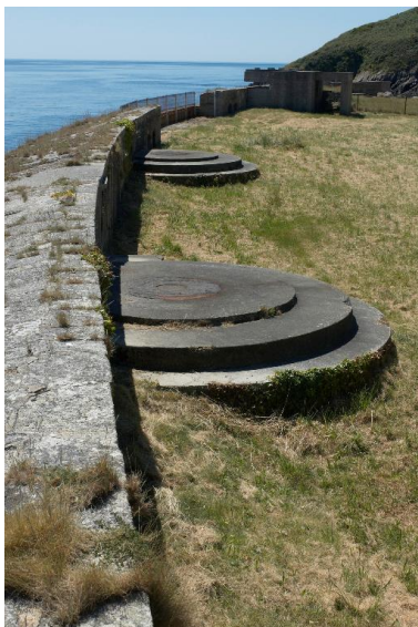
Plouzané : vue du fort du Mengant, détail de la batterie basse, plate- formes bétonnées pour canon Phot. Bernard Bègne IVR53_20122901612NUCA
