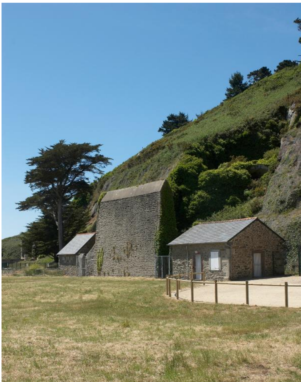
Plouzané : vue du fort du Mengant, corps de garde
