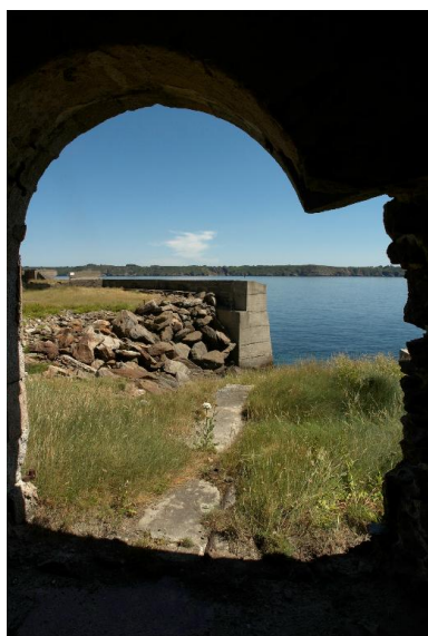
Plouzané : vue du fort du Mengant, abri de jour du projecteur Phot. Bernard Bègne IVR53_20122901638NUCA
