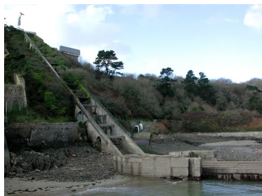
Vue du fort du Mengant depuis le môle construit en 1877 : partie basse du funiculaire, môle de translation Phot. Guillaume Lécueillier IVR53_20052903314NUCA
