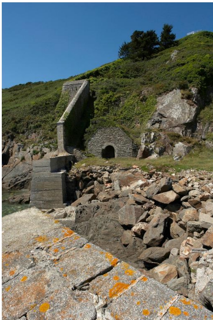
Plouzané : vue du fort du Mengant, mur d'enceinte dit branche tombante ouest percée de créneaux de mousqueterie depuis la batterie basse. Abri de jour du projecteur
