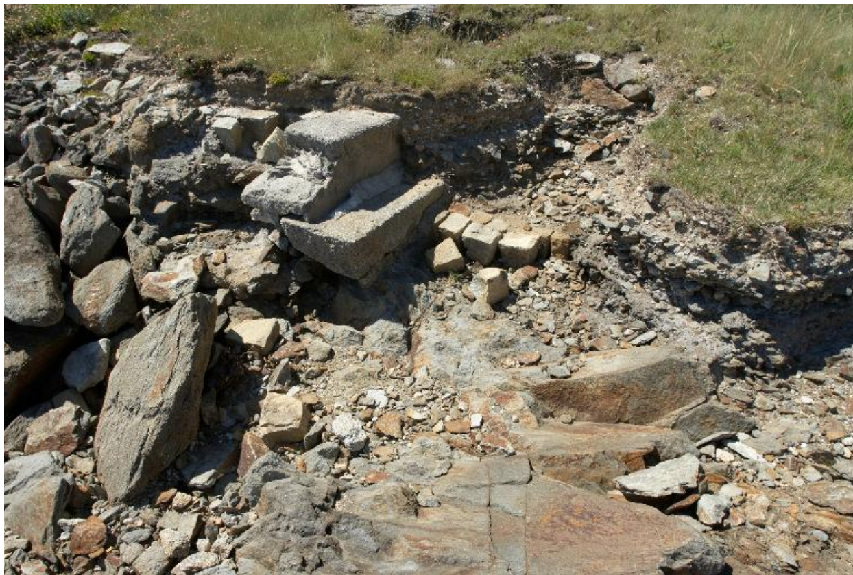
Plouzané : vue du fort du Mengant, détail de la batterie basse, extrémité ouest ruinée, niveau de sol primitif
