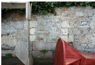
Vue de la batterie haute du Mengant : embrasure murée Phot. Guillaume Lécueillier IVR53_20072905868NUCA
