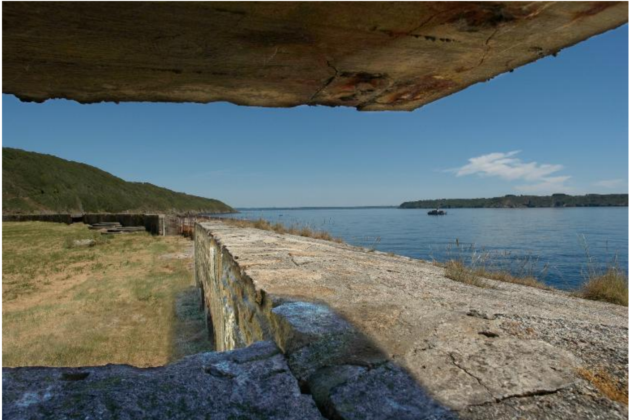
Plouzané : vue du fort du Mengant, détail de la batterie basse, parapet et poste de combat en béton armé (vraisemblablement allemand), panorama
