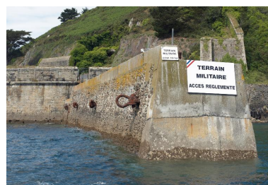
Plouzané : vue du fort du Mengant, môle construit en 1877 dans l'anse Phot. Bernard Bègne IVR53_20122901652NUCA
