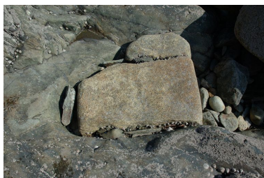
Vue de la batterie basse du Mengant : extrémité ouest ruinée Phot. Guillaume Lécueillier IVR53_20072905857NUCA
