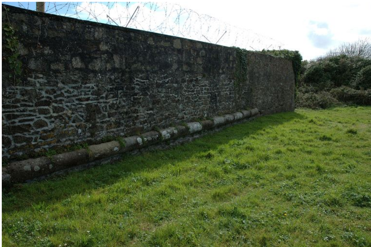
Vue de la batterie haute du Mengant : cortine de gorge. Situé au ras du sol du fait du comblement des fossés, le cordon
