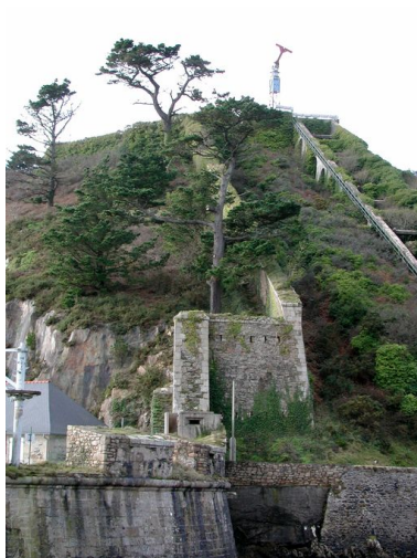
Vue du fort du Mengant depuis le môle construit en 1877 : entrée de la batterie basse flanquée par la branche tombante, funiculaire Phot. Guillaume Lécueillier IVR53_20052903315NUCA
