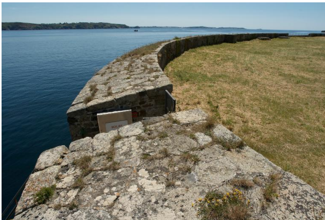
Plouzané : vue du fort du Mengant, détail de la batterie basse, parapet et embrasure
