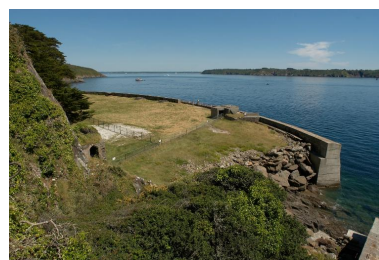
Plouzané : vue du fort du Mengant, abri Phot. Bernard Bègne IVR53_20122901629NUCA
