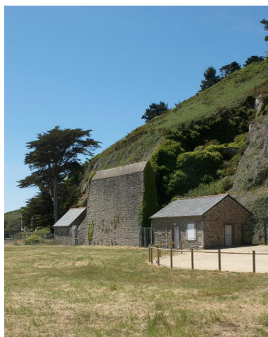
Plouzané : vue du fort du Mengant, corps de garde Phot. Bernard Bègne IVR53_20122901607NUCA
