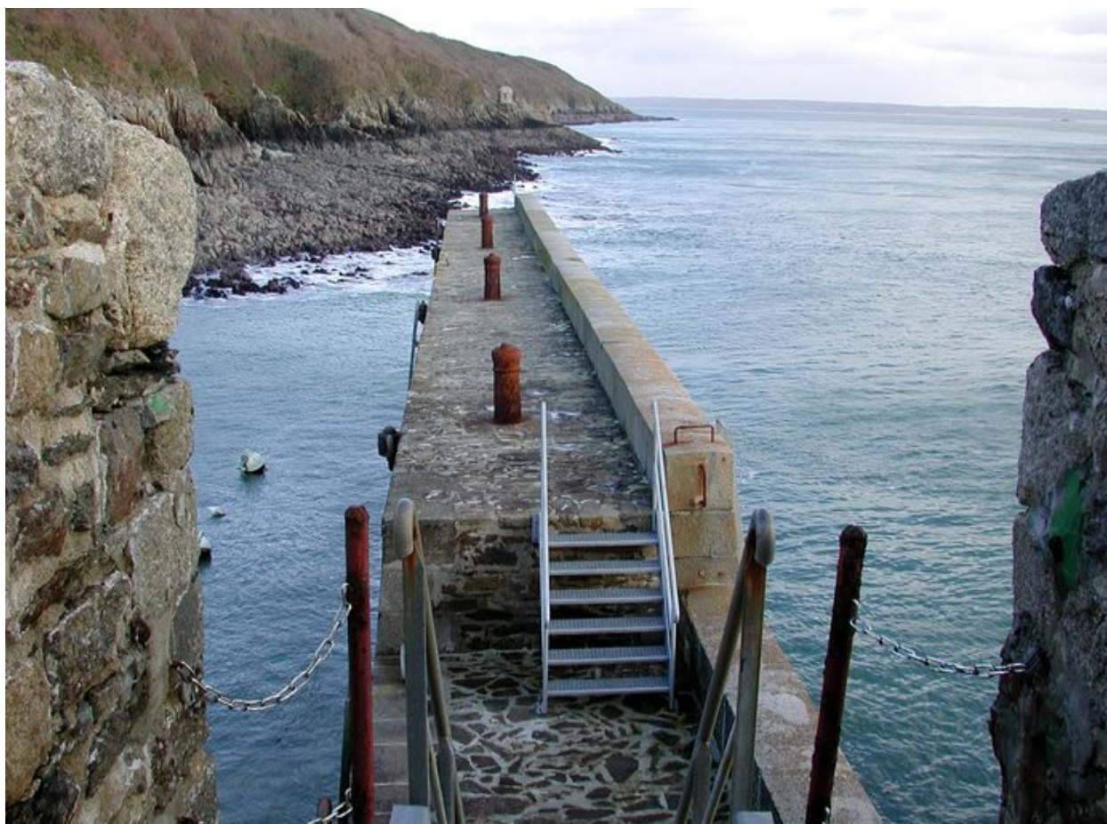
Vue du fort du Mengant : môle, quatre canons-bollards permettaient de capeler l'oeil des amarres
