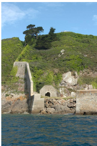
Plouzané : vue du fort du Mengant, mur d'enceinte dit branche tombante ouest percée de créneaux de mousqueterie et escalier parallèle. Abri de jour du projecteur Phot. Bernard Bègne IVR53_20122901653NUCA
