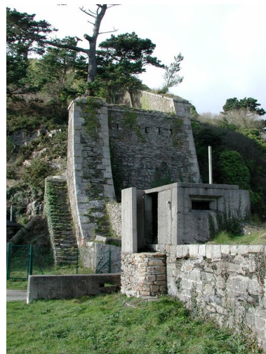
Vue du fort du Mengant : entrée de la batterie basse flanquée par la branche tombante. Ouvrage bétonné allemand protégeant l'entrée Phot. Guillaume Lécueillier IVR53_20052903317NUCA
