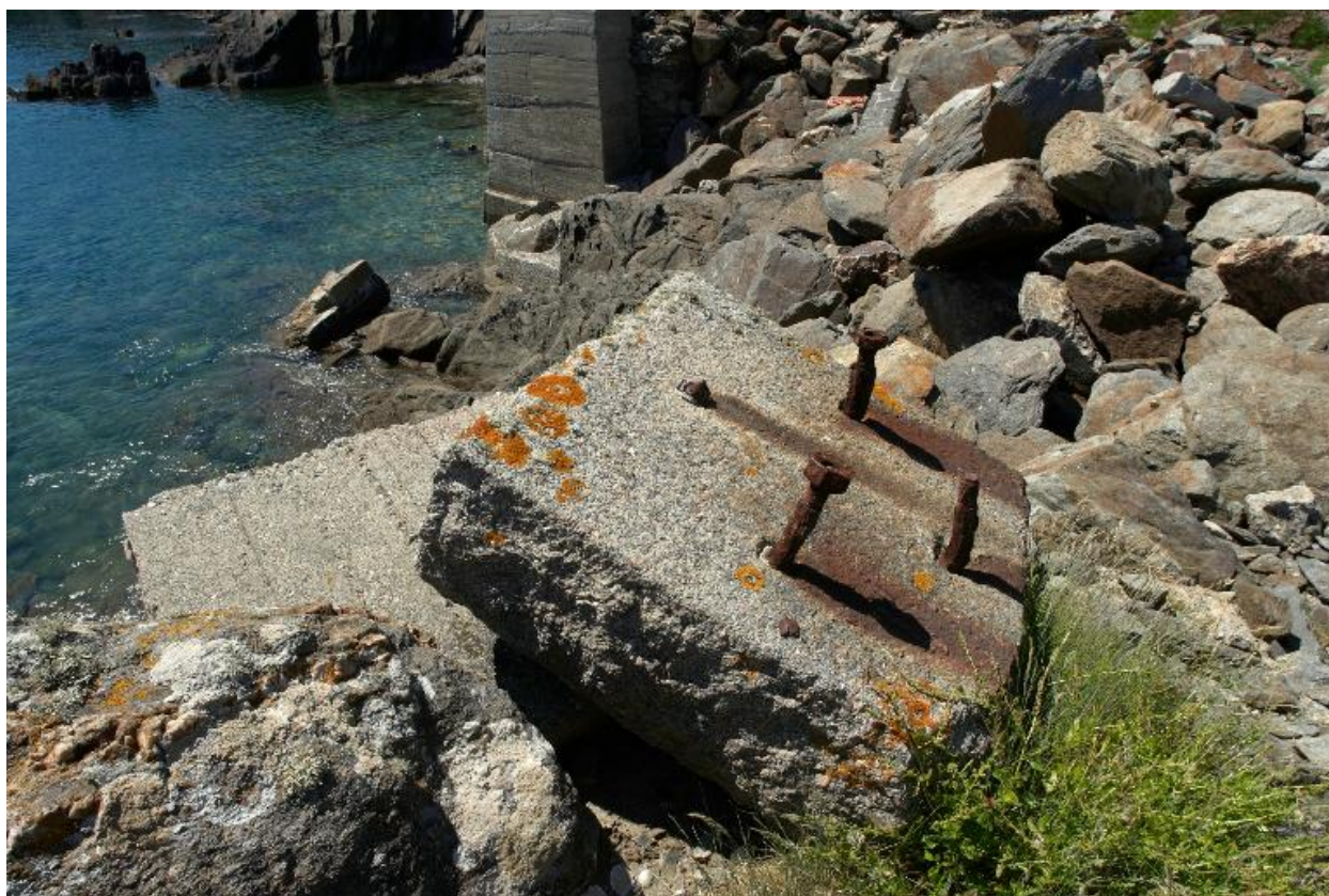
Plouzané : vue du fort du Mengant, détail de la batterie basse, extrémité ouest ruinée, dé, boulons de sellette
