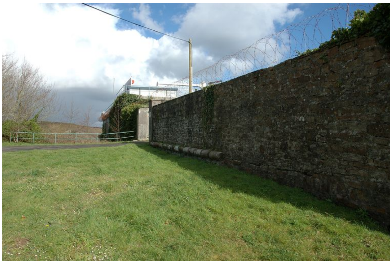
Vue de la batterie haute du Mengant : entrée. Situé au ras du sol du fait du comblement des fossés, le cordon
