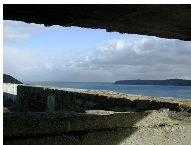
Vue du fort du Mengant : le goulet depuis l'abri bétonné de la batterie basse Phot. Guillaume Lécueillier IVR53_20052903341NUCA
