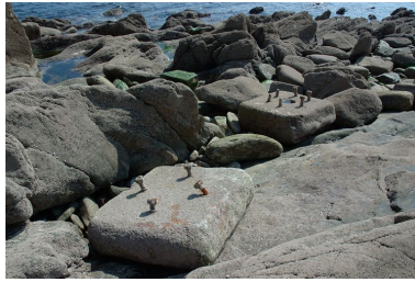
Vue de la batterie basse du Mengant : extrémité ouest ruinée Phot. Guillaume Lécueillier IVR53_20072905836NUCA
