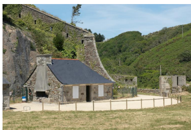
Plouzané : vue du fort du Mengant, corps de garde Phot. Bernard Bègne IVR53_20122901608NUCA
