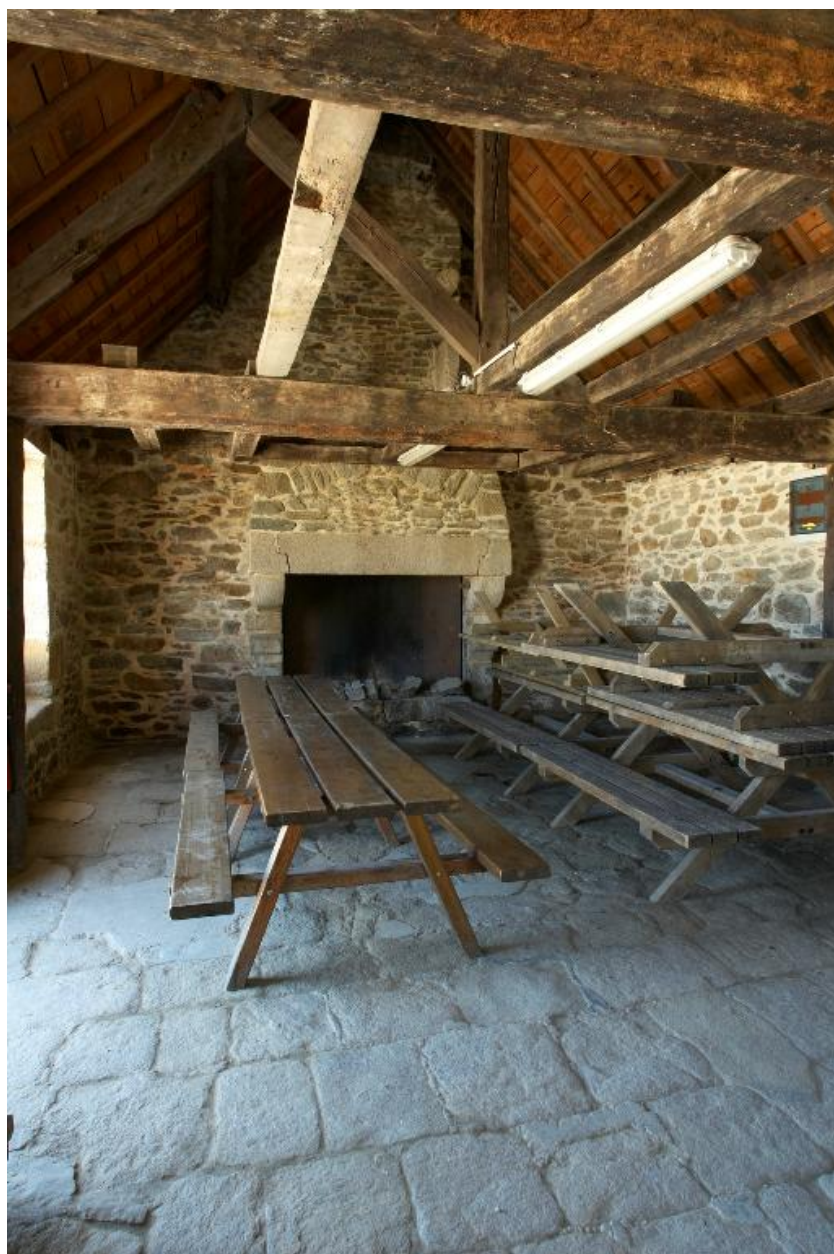
Plouzané : vue du fort du Mengant, corps de garde, cheminée et poutres
