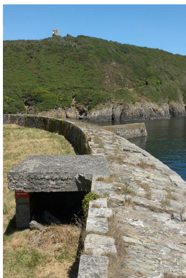
Plouzané : vue du fort du Mengant, détail de la batterie basse, parapet Phot. Bernard Bègne IVR53_20122901610NUCA
