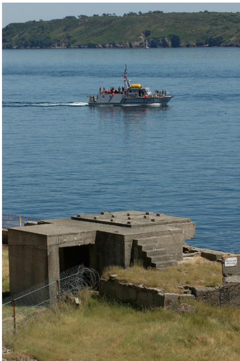
Plouzané : vue du fort du Mengant, détail de la batterie basse, parapet et poste de combat en béton armé (vraisemblablement allemand). En arrière plan : la côte de Cornouaille
