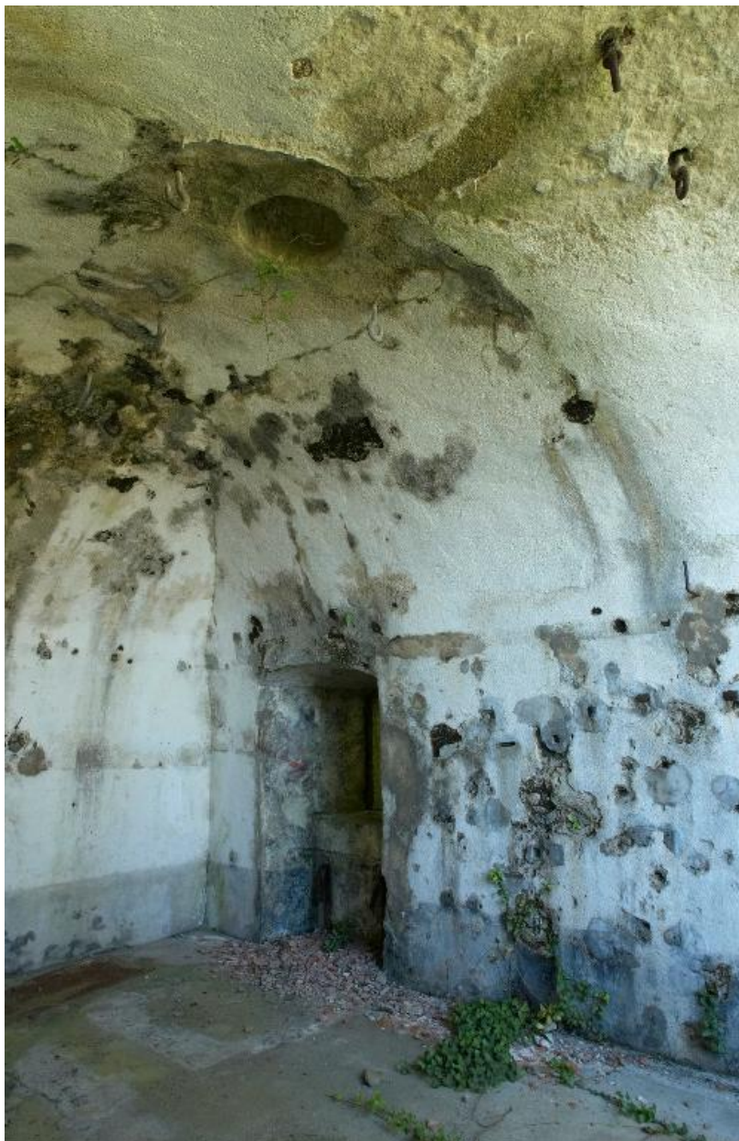
Plouzané : vue du fort du Mengant, usine électrique aménagée à flanc de falaise, intérieur, enduit
