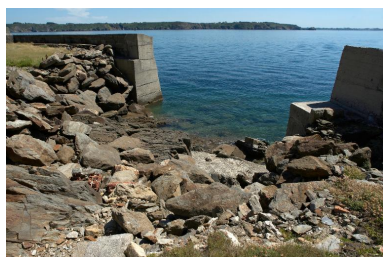
Plouzané : vue du fort du Mengant, batterie basse, extrémité ouest Phot. Bernard Bègne IVR53_20122901628NUCA
