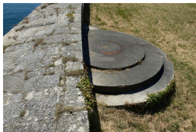
Plouzané : vue du fort du Mengant, détail de la batterie basse, plate- forme bétonnée pour canon Phot. Bernard Bègne IVR53_20122901614NUCA
