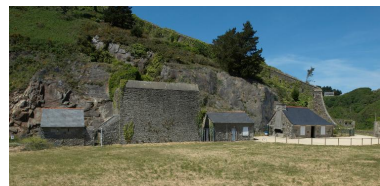
Plouzané : vue du fort du Mengant, corps de garde Phot. Bernard Bègne IVR53_20122901615NUCA
