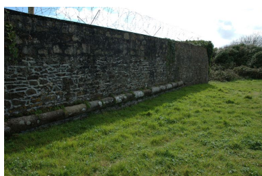
Vue de la batterie haute du Mengant : courtine de gorge. Situé au ras du sol du fait du comblement des fossés, le cordon Phot. Guillaume Lécueillier IVR53_20072905864NUCA
