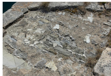
Plouzané : vue du fort du Mengant, détail de la batterie basse, parapet Phot. Bernard Bègne IVR53_20122901611NUCA
