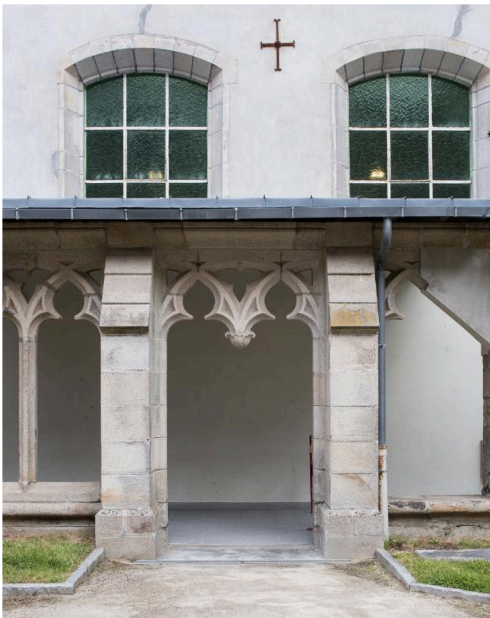
Bâtiments de l'ancien séminaire, détail sur un élément du cloître des Carmes de Pont-L'Abbé (15e siècle, remonté ici en 1902).
