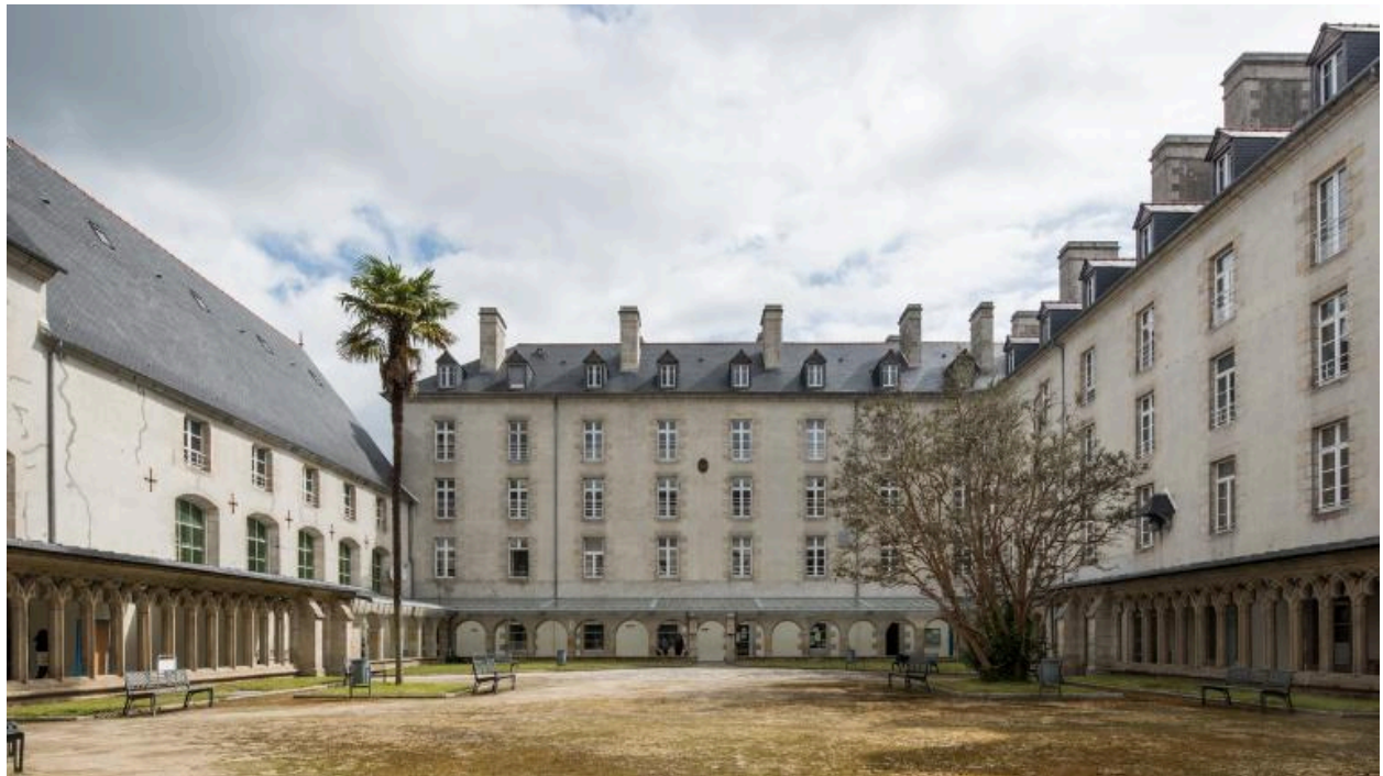
Bâtiments de l'ancien séminaire, vue d'ensemble de la cour vers l'aile nord-est. A gauche la chapelle des Sœurs du Calvaire (1663).
