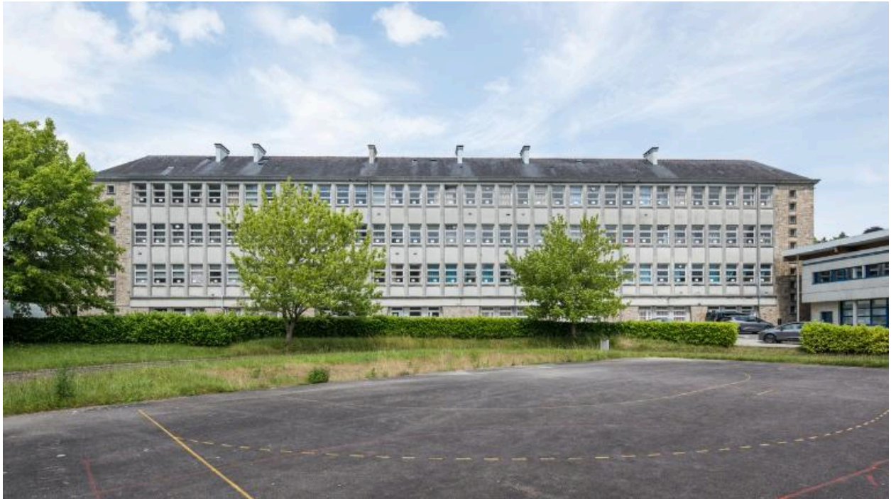
Externat, façade sud. Jacques Lachaud, architecte, 1962.
