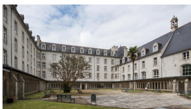
Ancien séminaire, ailes sud-est, sud-ouest et nord-ouest. A droite chapelle des Sœurs du Calvaire (1663). Devant les bâtiments, cloître des Carmes de Pont-L'Abbé (15e siècle), remonté ici en 1902.. Phot. Delia Gaulin-Crespel IVR53_20192900385NUCA
