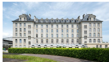
Ancien séminaire, aile sud-ouest, Henri Rapine, architecte, 1899. Au rez-de-chaussée bas, extension pour agrandir le réfectoire. Phot. Delia Gaulin-Crespel IVR53_20192900411NUCA
