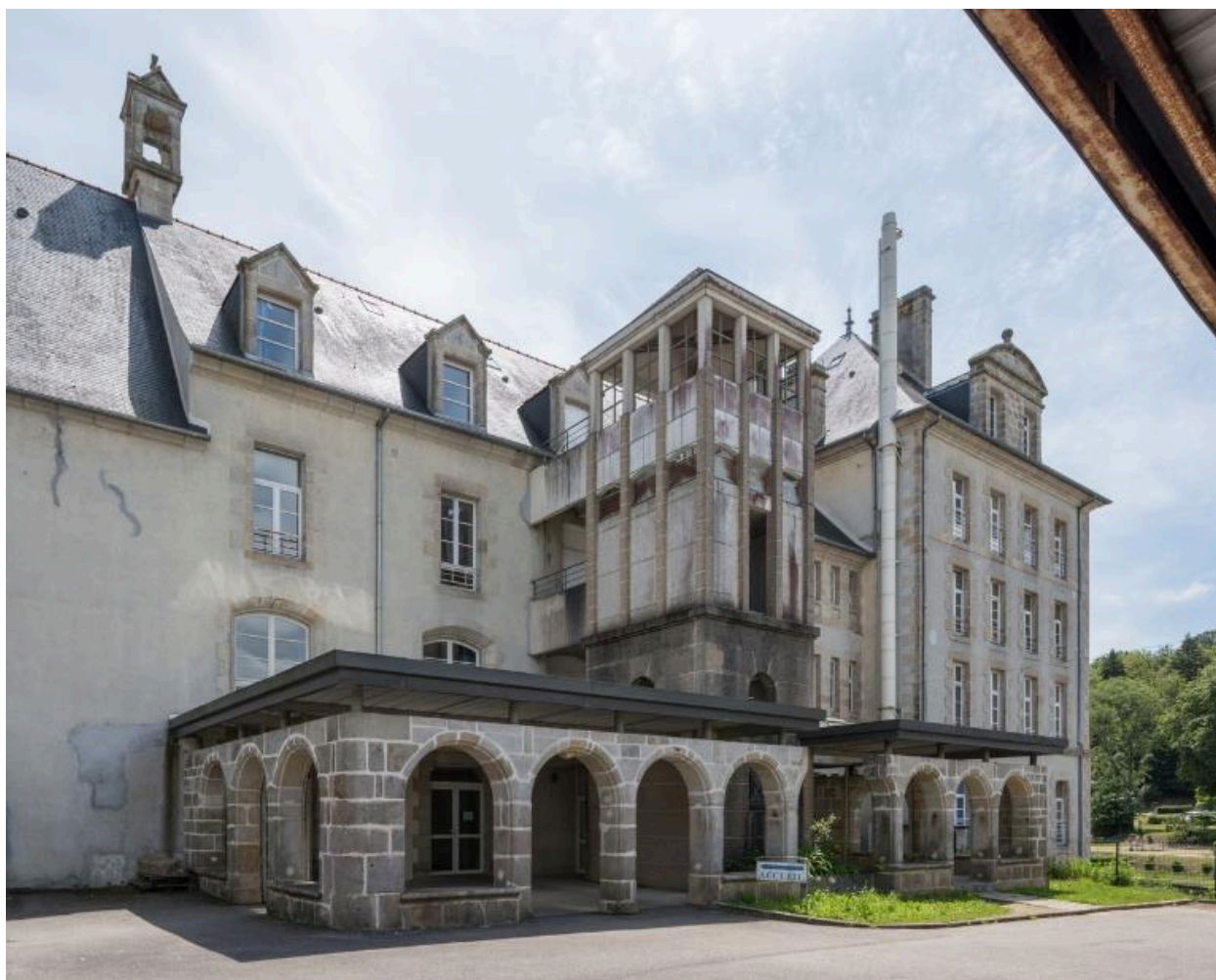
Ancien séminaire, aile nord-ouest, façade nord-ouest. Des éléments de cloître remontés matérialisent l'entrée de la cour centrale. Une cage d'escalier extérieure a été ajoutée.
