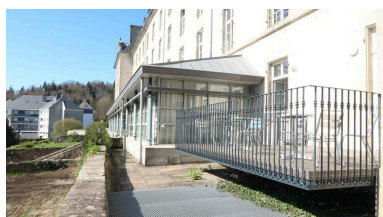
restructuration du CDI et extension au rez-de-chaussée. Archipôle Urbanisme et Architecture, architectes, 1999. Phot. Thierry Goyet IVR53_20202905033NUCA
