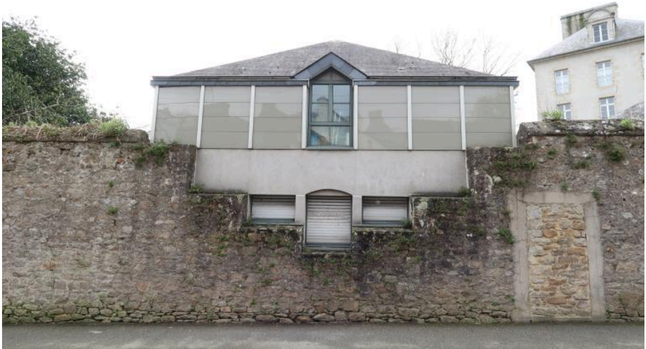
Logement de fonction vu depuis la rue.
