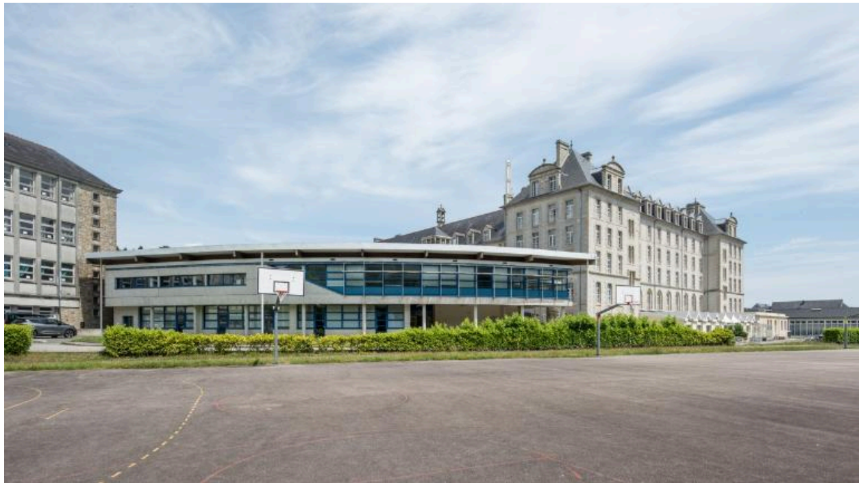
Bâtiment des formations hôtelières, façade ouest, atelier Duhamel, architectes, 1994. A droite, l'ancien séminaire.
