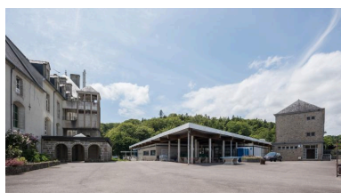
Vue d'ensemble prise depuis l'entrée. De gauche à droite, ancien séminaire, bâtiment des formations hôtelières (1994) et pignon est de la barre d'externat (1962). Phot. Delia Gaulin-Crespel IVR53_20192900405NUCA
