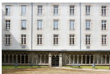
Bâtiments de l'ancien séminaire, détail sur une façade et sur le cloître des Carmes de Pont-L'Abbé (15e siècle), remonté ici en 1902. Phot. Delia Gaulin-Crespel IVR53_20192900375NUCA
