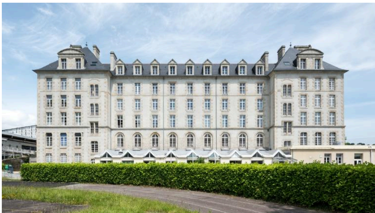
Ancien séminaire, aile sud-ouest, Henri Rapine, architecte, 1899. Au rez-de-chaussée bas, extension pour agrandir le réfectoire.
