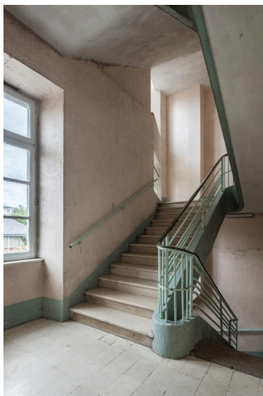
Cage d'escalier dans l'ancien séminaire réhabilitée (vers 1950-1960). Phot. Delia Gaulin-Crespel IVR53_20192900382NUCA
