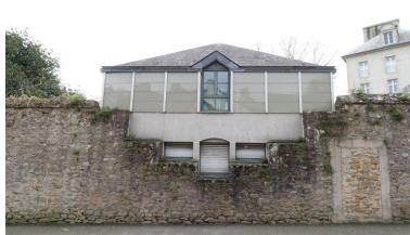
Logement de fonction vu depuis la rue. Phot. Thierry Goyet IVR53_20202905023NUCA
