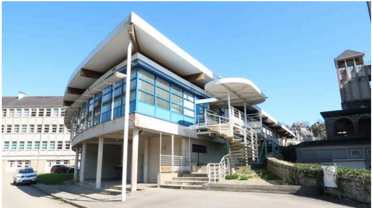
Angle sud-ouest du bâtiment des formations hôtelières, atelier Duhamel, architectes, 1994.
