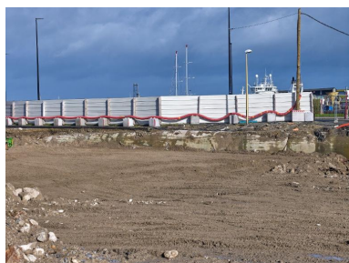
Vue depuis le sud-ouest (couverture photographique du 22 janvier 2026). Sur la dalle de couverture du bunker passe la chaussée Éric Tabarly Phot. Bernard Bègne IVR53_20263500059NUCA
