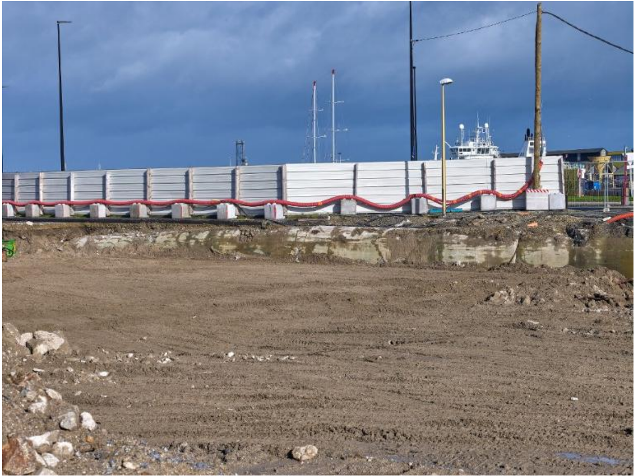
Vue depuis le sud-ouest (couverture photographique du 22 janvier 2026). Sur la dalle de couverture du bunker passe la chaussée Éric Tabarly
