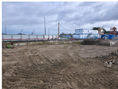
Vue de situation depuis l'ouest-nord-ouest (couverture photographique du 22 janvier 2026) Phot. Bernard Bègne IVR53_20263500058NUCA
