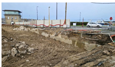
Vue de situation depuis le sud (couverture photographique du 17 décembre 2025). Seule la dalle de couverture est visible sous le remblai Phot. Guillaume Lécueillier IVR53_20263510065NUCA
