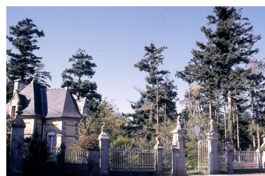
Portail d'entrée et conciergerie Phot. Catherine Hervé-Commereuc IVR53_19962205000ZA
