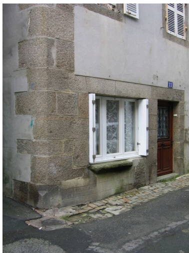
Maison n° 11 rue de Reims, détail : porte et baie avec étal Phot. Françoise Péron IVR53_20062908410NUCA
