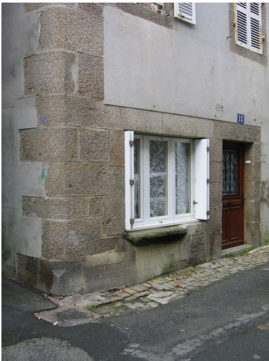
Maison n° 11 rue de Reims, détail : porte et baie avec étal
