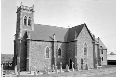
Elévation Sud-Ouest : vue générale Phot. Guy Artur, Phot. Norbert Lambart IVR53_19943500859X
