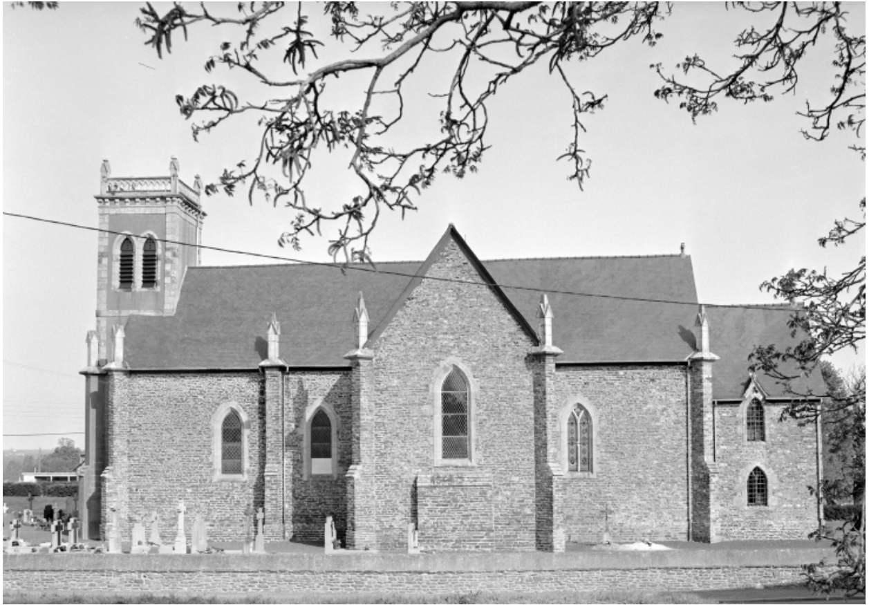
Elévation Sud : vue générale
