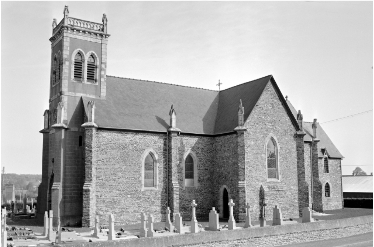
Elévation Sud-Ouest : vue générale
