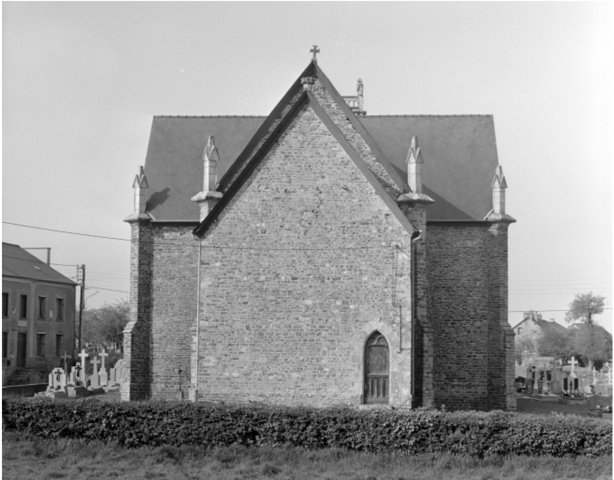
Elévation Est : vue générale
