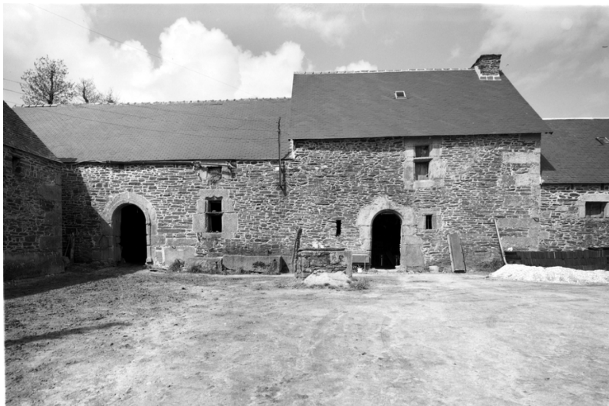
Vue générale façade sud
