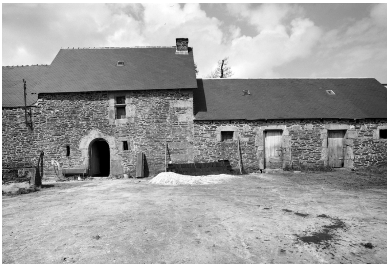
Vue générale façade sud
