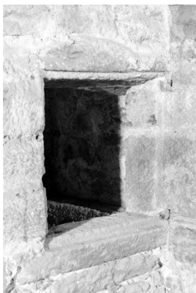
Intérieur, clocher, deuxième étage, niche armoire : vue générale. Phot. François Dagorn IVR53_19723500136V
