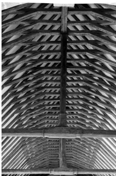
Intérieur, nef, charpente : vue générale. Phot. François Dagorn IVR53_19723500130V
