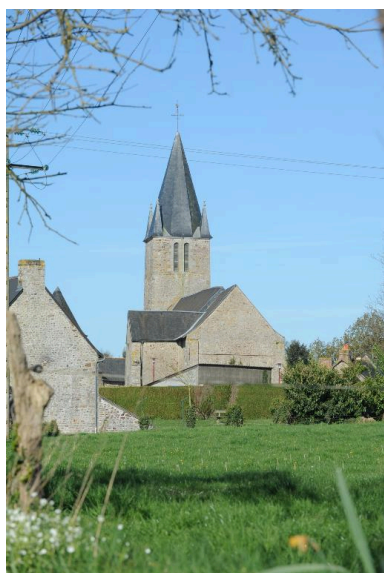
Vue générale Phot. Norbert Lambart IVR53_20143500235NUCA
