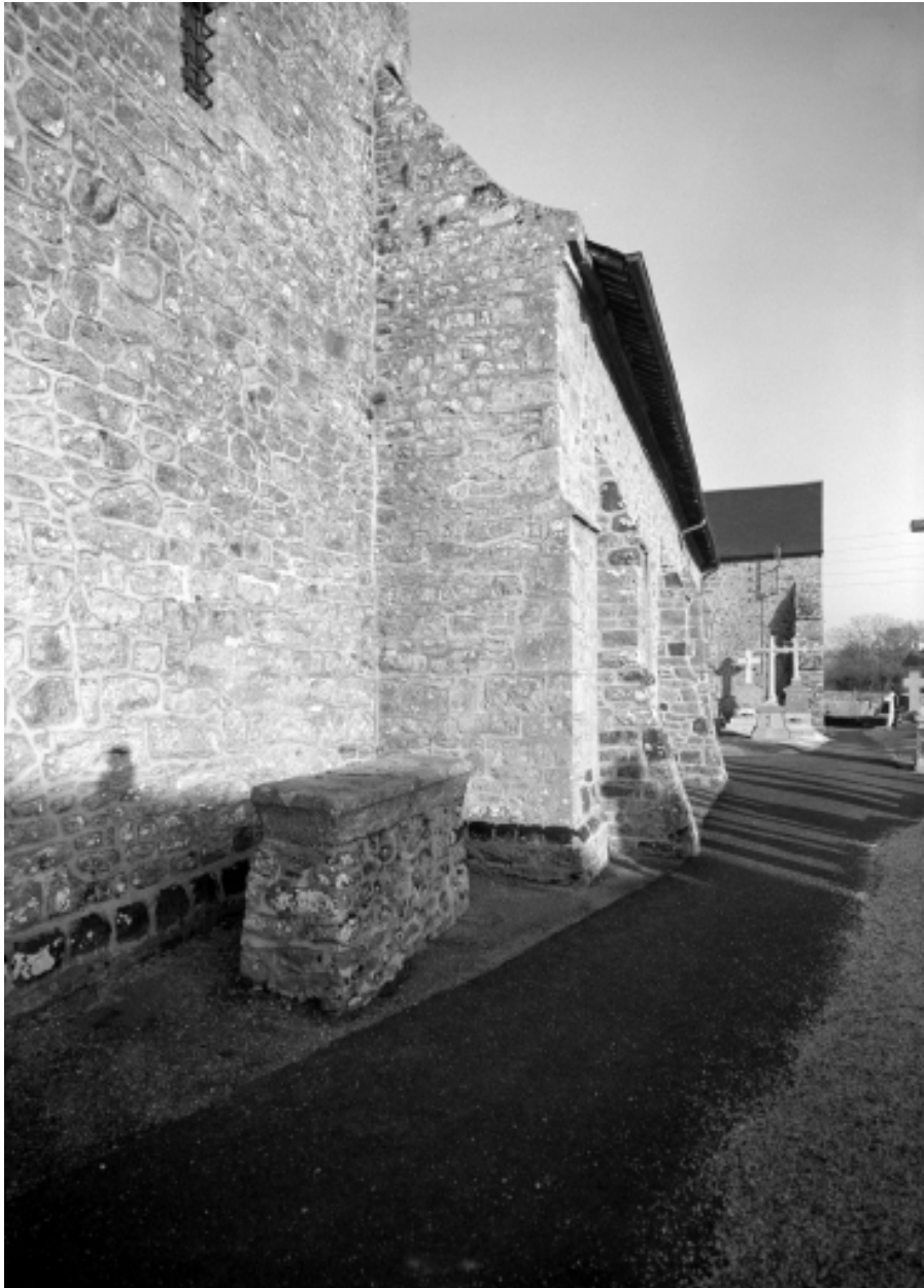
Elévation sud, partie ouest : détail de l'alignement
