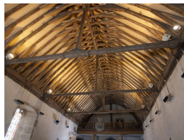
Vue de la charpente Phot. Bernard Bègne IVR53_20143500027NUCA
