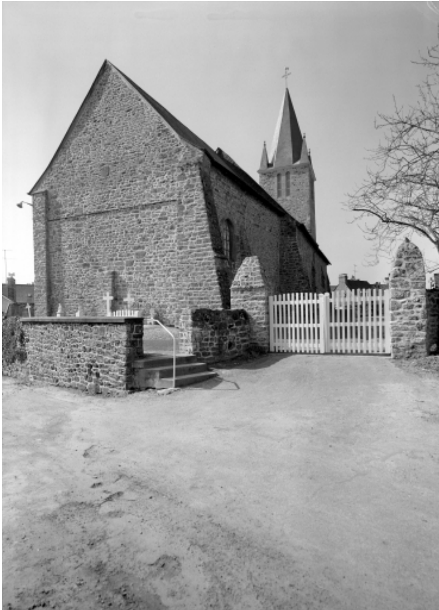
Elévation nord-est : vue générale
