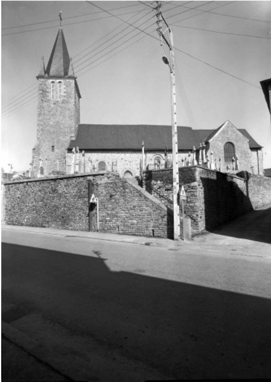
Elévation sud : vue générale
