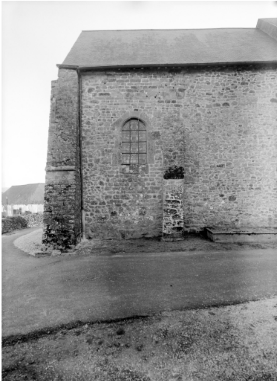
Elévation nord, partie est : vue générale
