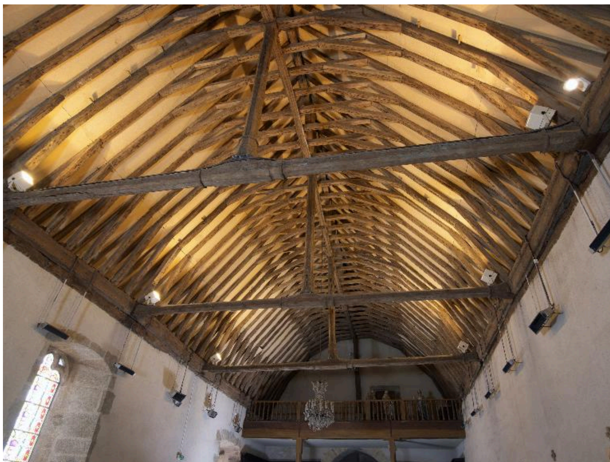
Vue de la charpente
