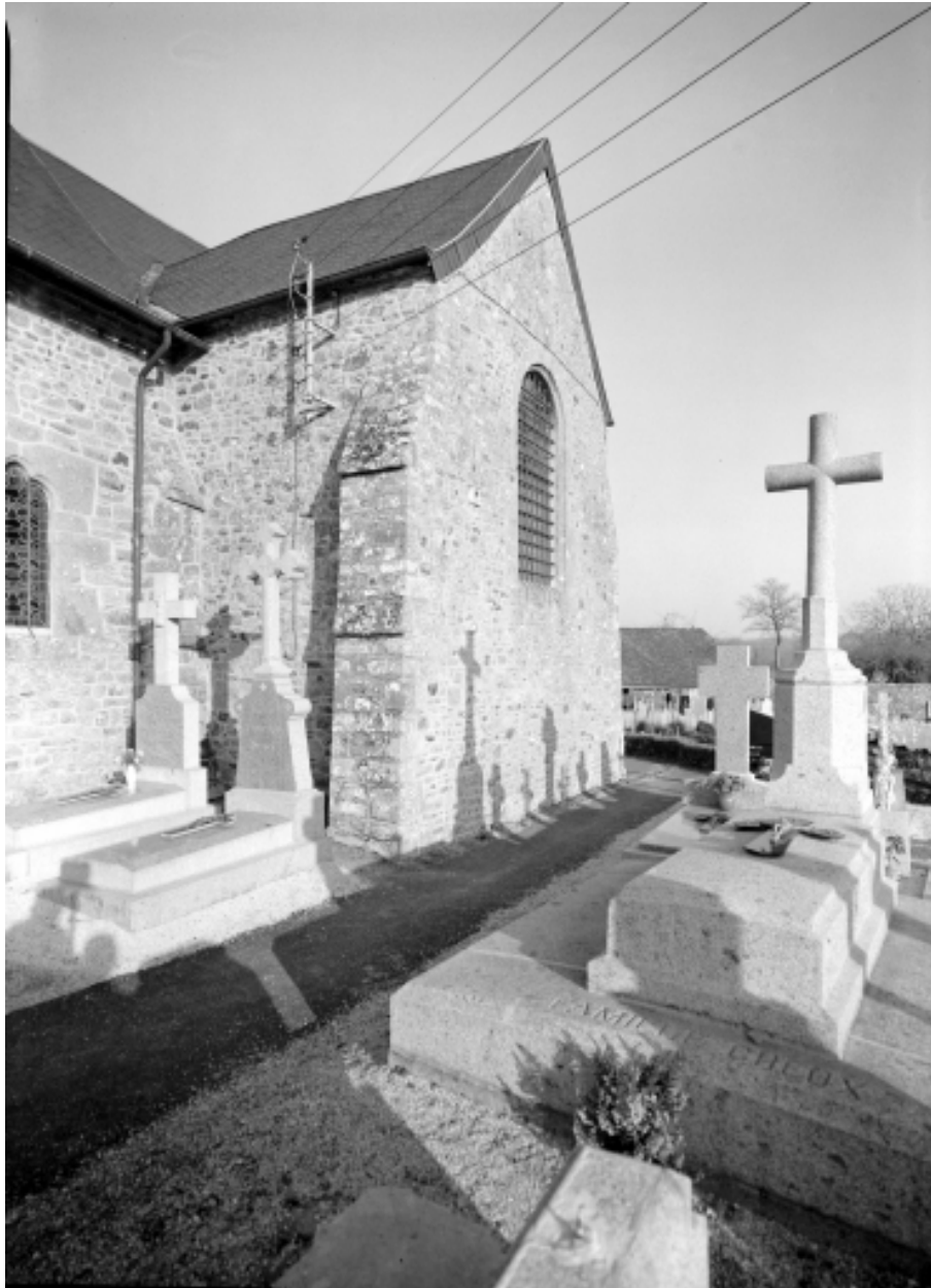
Elévation sud-ouest, sacristie : vue générale
