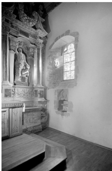
Intérieur, chœur, mur sud, fenêtre : vue générale. Phot. François Dagorn IVR53_19723500008V
