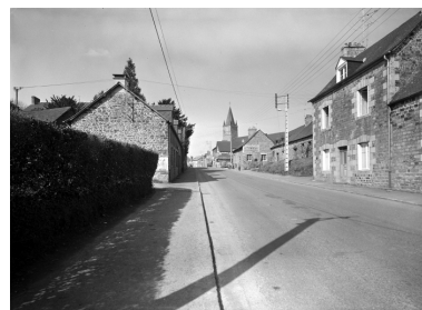
Elévation sud-est : vue de situation Phot. François Dagorn IVR53_19723500106V
