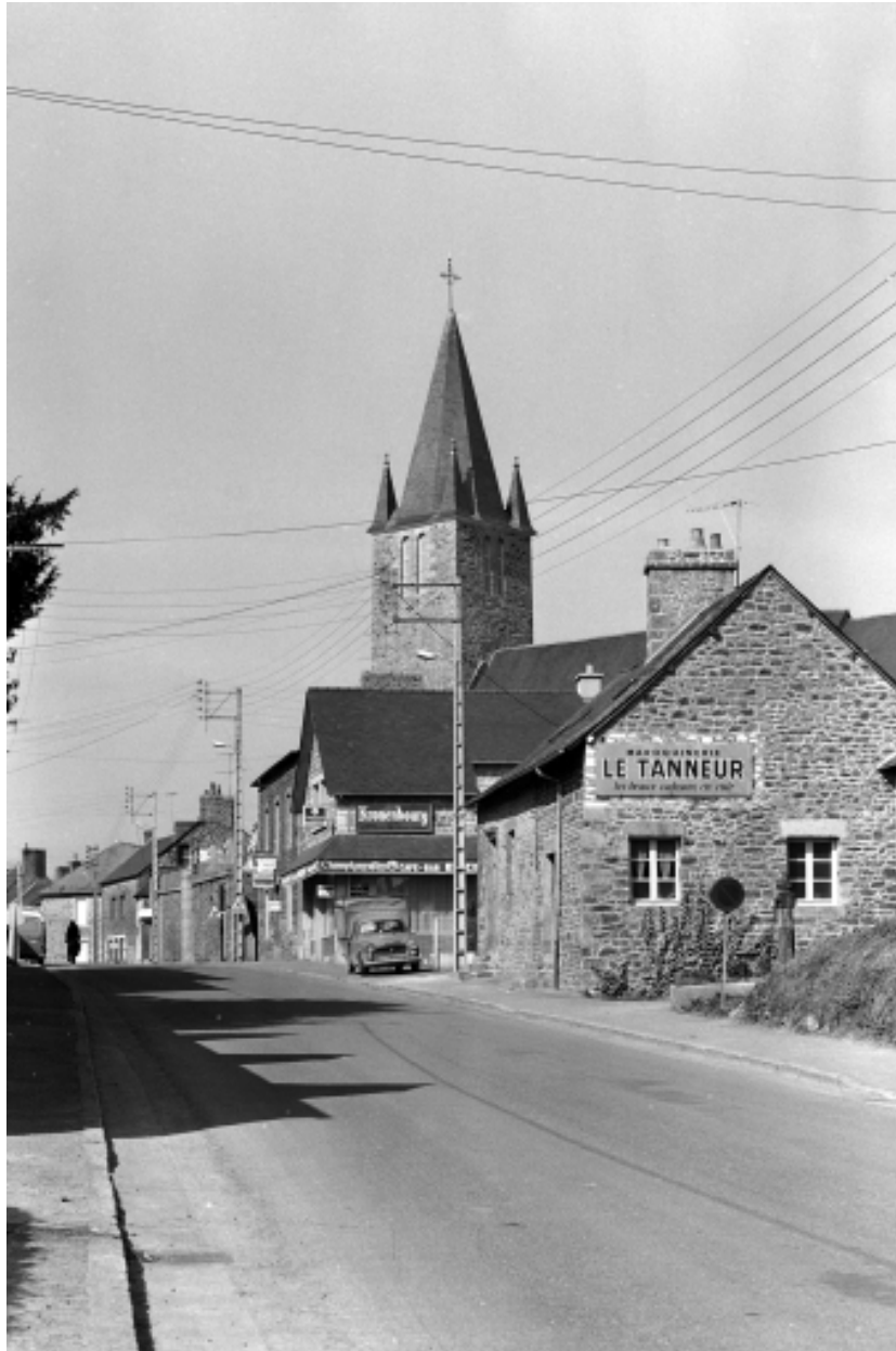
Elévation sud-est : vue de situation
