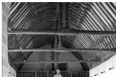
Intérieur, nef, charpente : vue générale. Phot. François Dagorn IVR53_19723500004V
