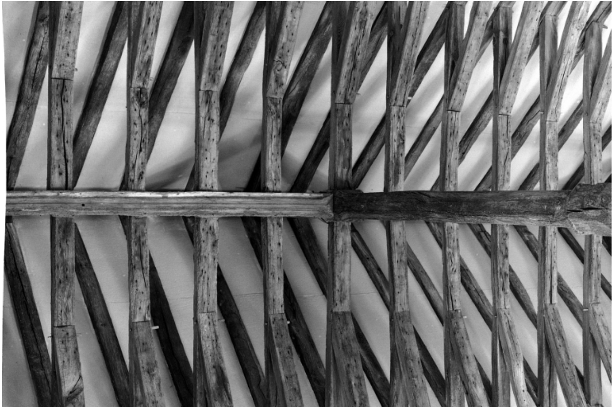
Intérieur, nef, charpente : vue générale.
