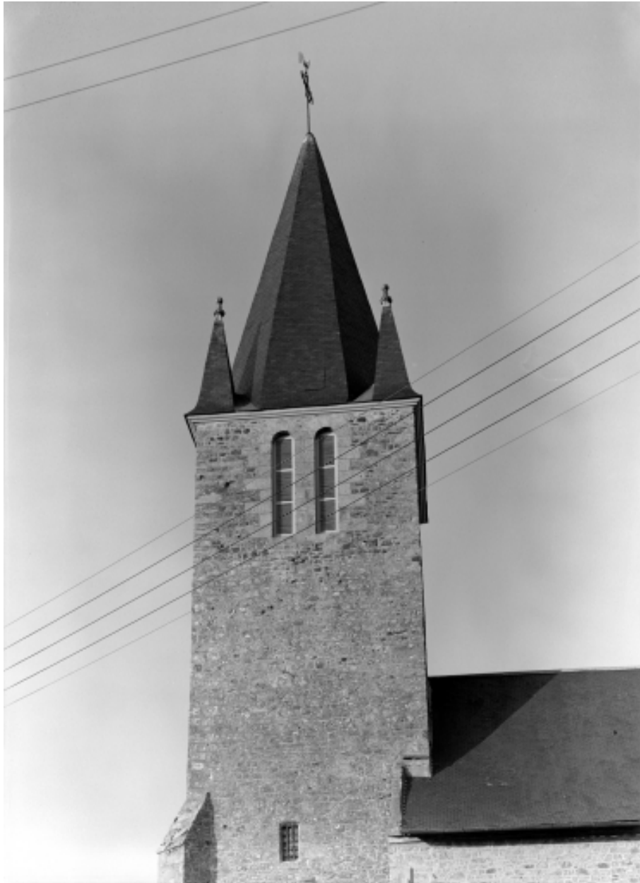
Elévation sud, clocher, partie haute : vue générale
