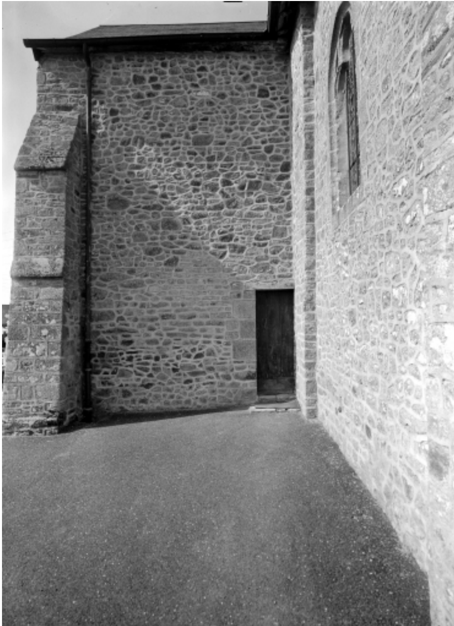
Elévation est, sacristie : vue générale
