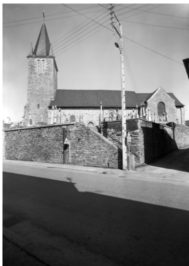
Elévation sud : vue générale Phot. François Dagorn IVR53_19723500112V
