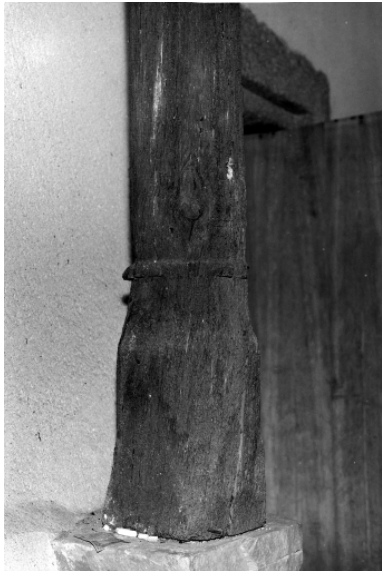
Intérieur, nef, charpente : détail de la retombée du poinçon occidental. Phot. François Dagorn IVR53_19723500135V
