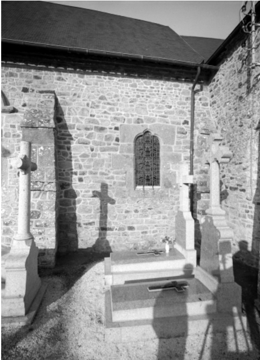
Elévation sud, fenêtre est : vue générale
