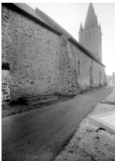
Elévation nord, partie centrale : détail de l'alignement Phot. François Dagorn IVR53_19723500033V
