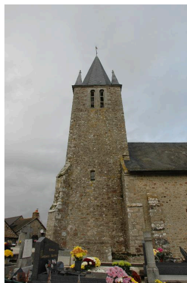
Le clocher Phot. Stéphanie Bardel IVR53_20143507404NUCA
