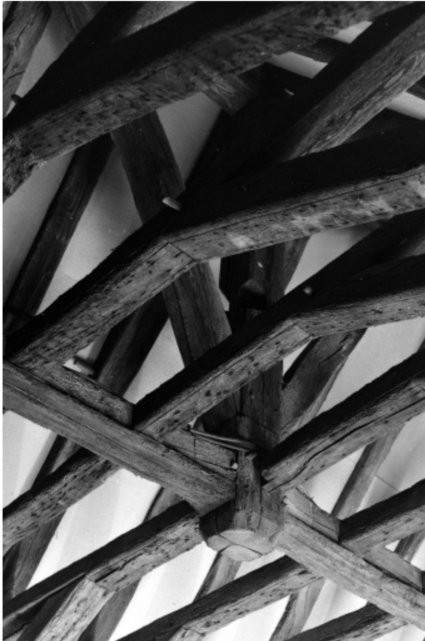
Intérieur, nef, charpente : détail sous le faitage.
