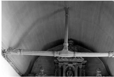
Intérieur, nef, charpente : vue générale. Phot. François Dagorn IVR53_19723500126V
