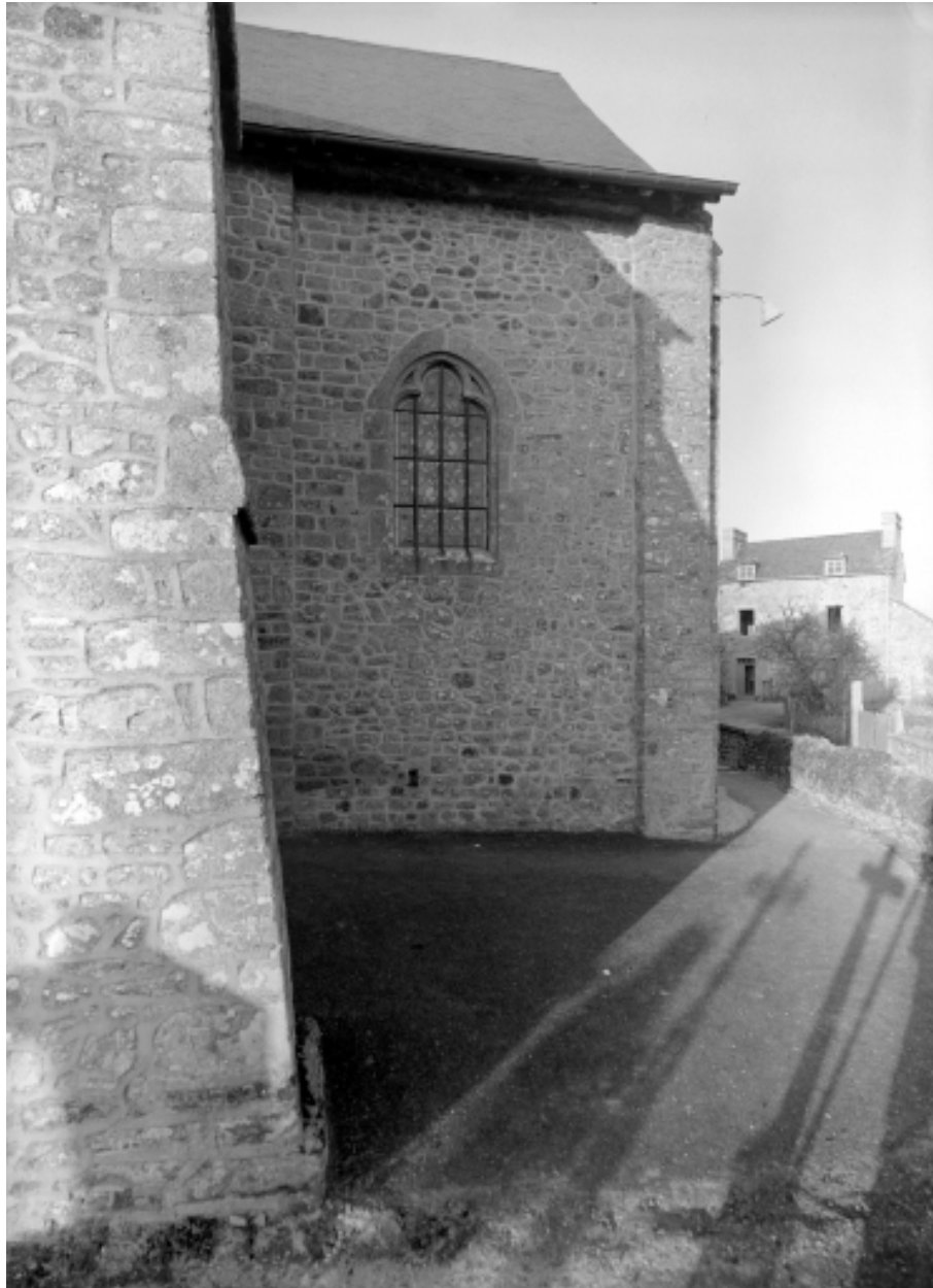
Elévation sud, partie est : vue générale
