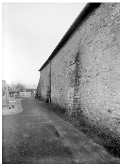
Elévation nord, partie centrale : détail de l'alignement Phot. François Dagorn IVR53_19723500032V
