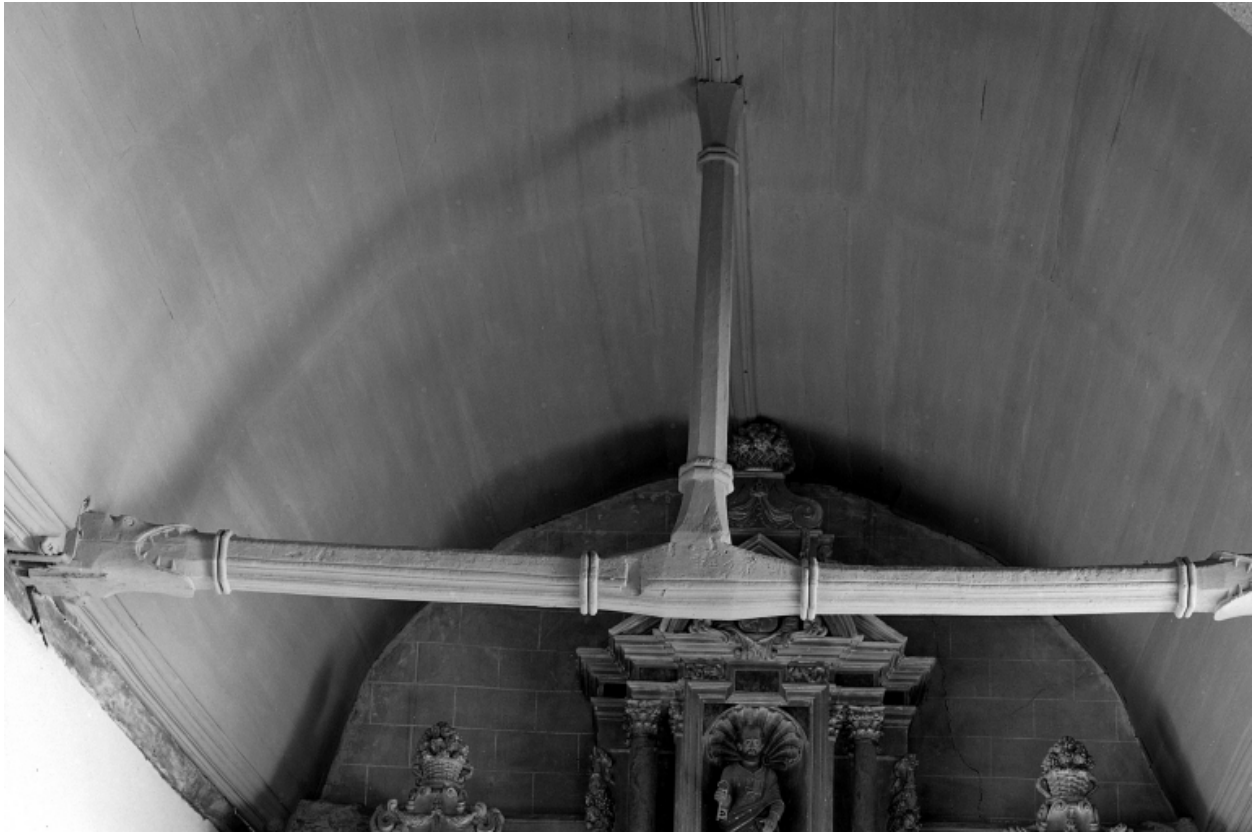
Intérieur, nef, charpente : vue générale.
