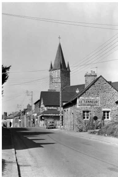
Elévation sud-est : vue de situation Phot. François Dagorn IVR53_19723500107V
