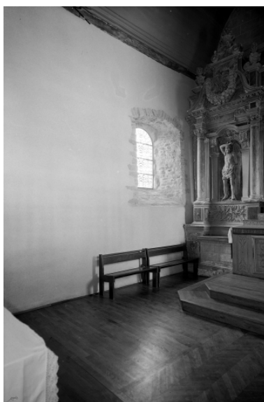
Intérieur, chœur, mur nord : vue générale. Phot. François Dagorn IVR53_19723500010V
