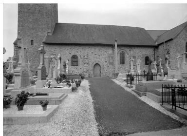
Elévation sud, partie centrale : vue générale Phot. François Dagorn IVR53_19723500040V
