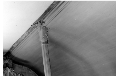
Intérieur, choeur, charpente : détail de la sablière et de l'entrave. Phot. François Dagorn IVR53_19723500127V
