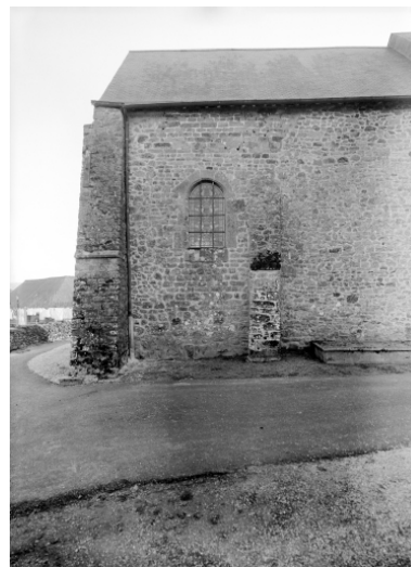
Elévation nord, partie est : vue générale Phot. François Dagorn IVR53_19723500030V
