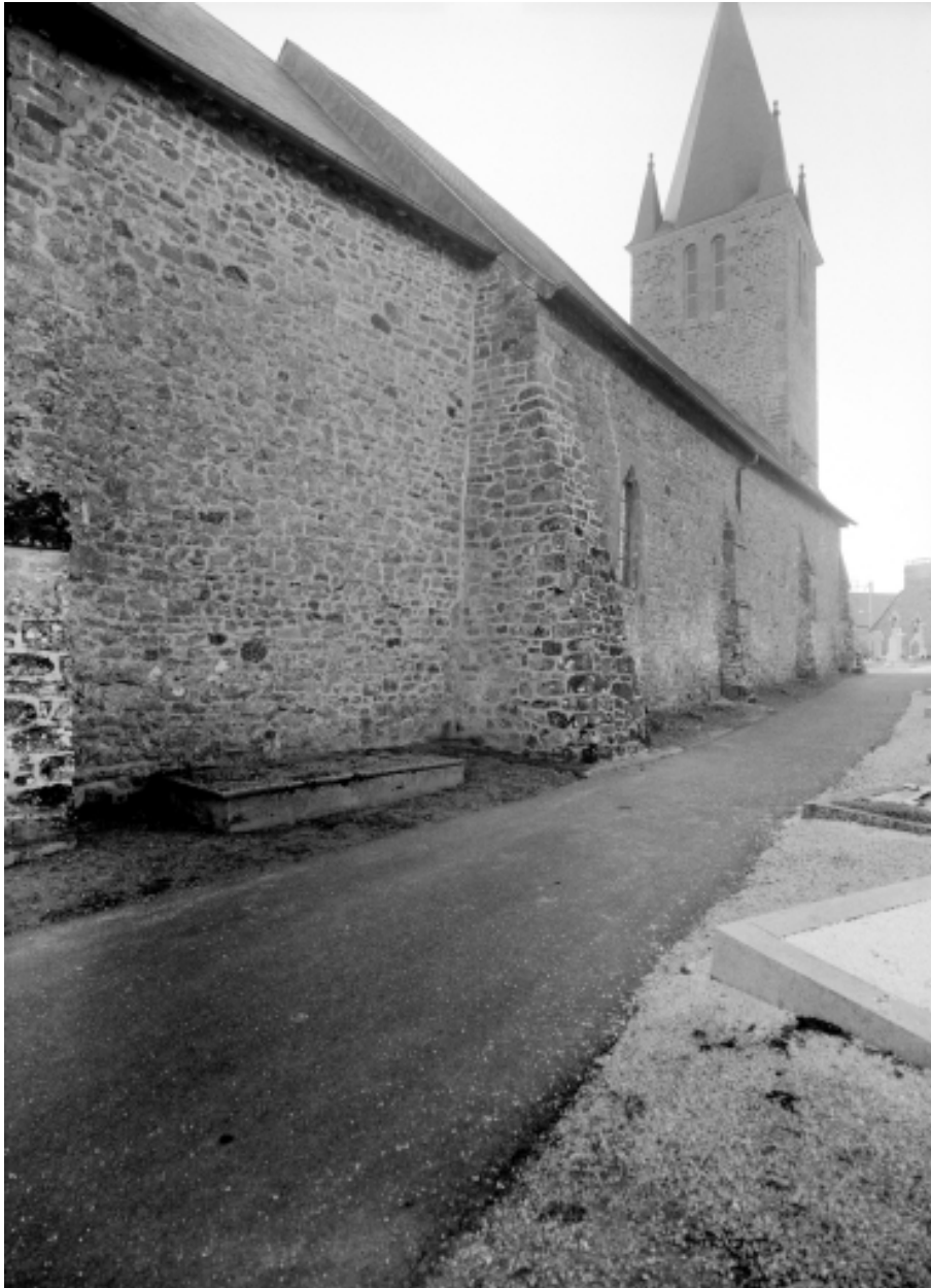
Elévation nord, partie centrale : détail de l'alignement
