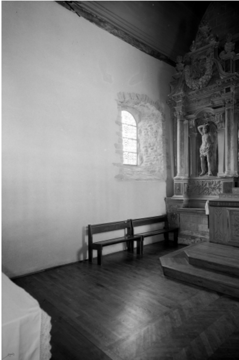
Intérieur, chœur, mur nord : vue générale.
