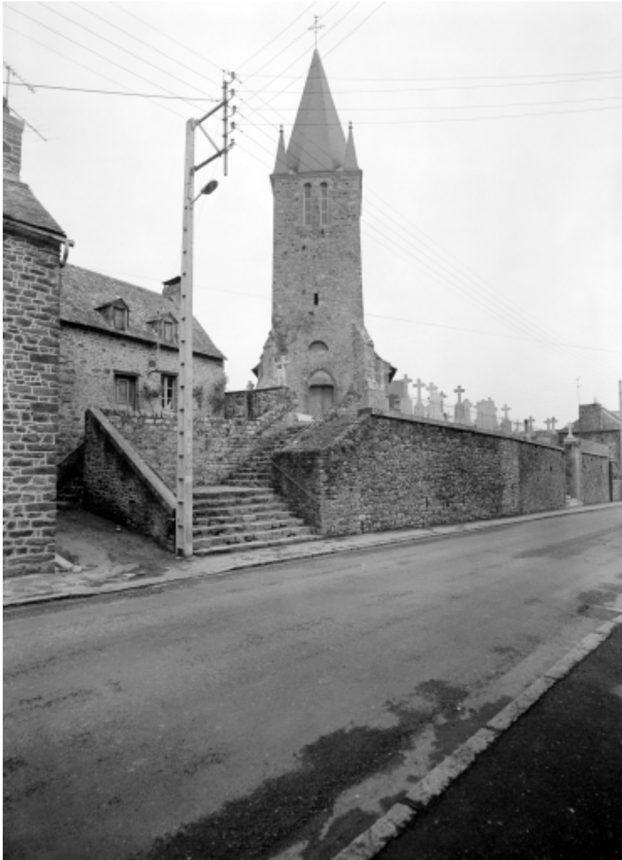
Elévation ouest : vue de situation
