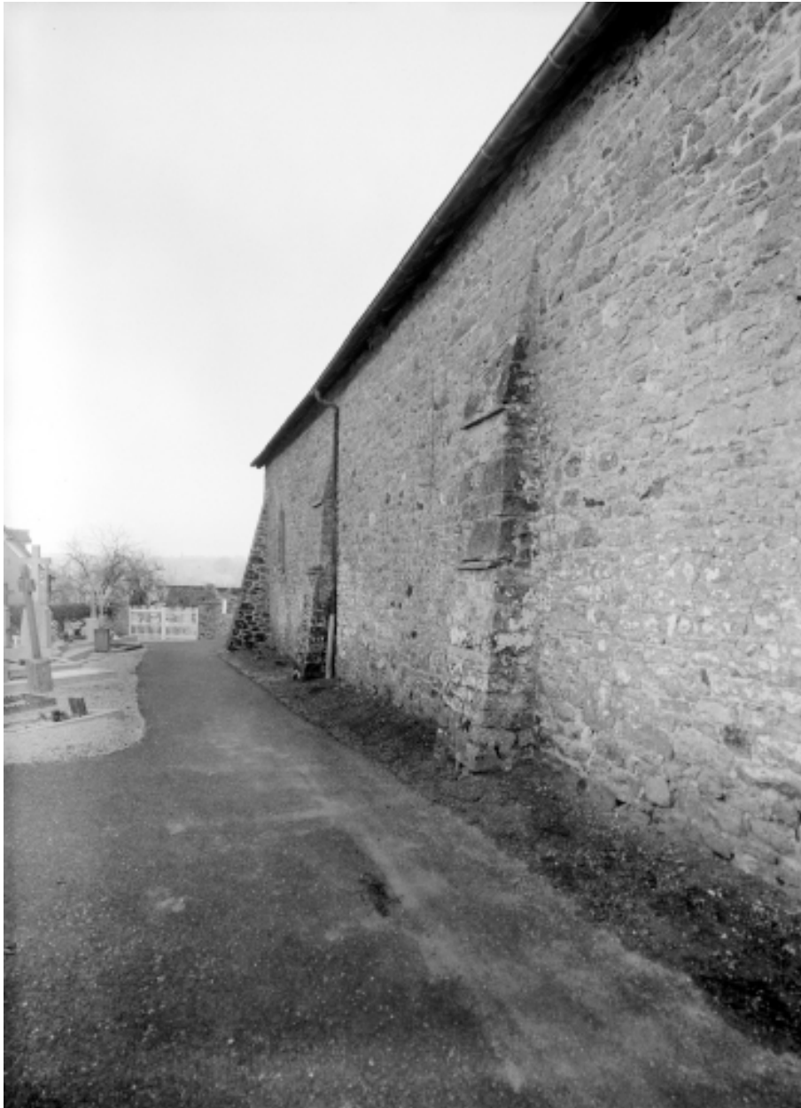
Elévation nord, partie centrale : détail de l'alignement
