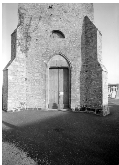
Elévation ouest, porte : vue générale Phot. François Dagorn IVR53_19723500023V
