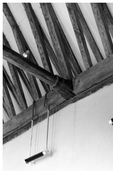
Intérieur, nef, charpente : détail de la sablière et de l'entrave. Phot. François Dagorn IVR53_19723500132V
