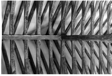
Intérieur, nef, charpente : vue générale. Phot. François Dagorn IVR53_19723500131V
