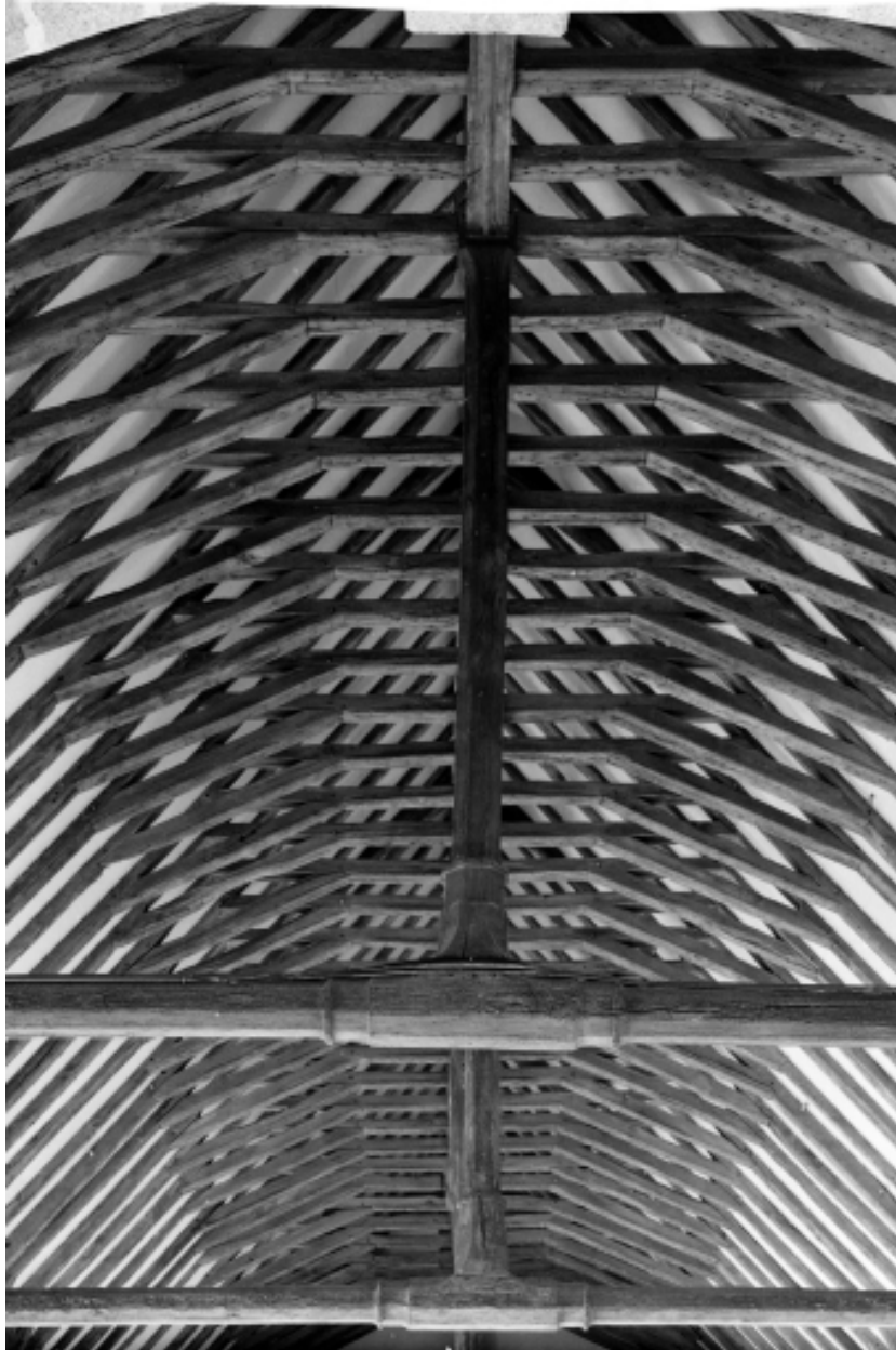
Intérieur, nef, charpente : vue générale.
