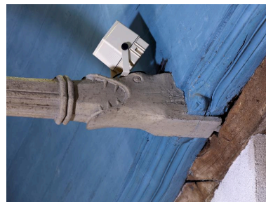
Détail de l'engoulant Phot. Bernard Bègne IVR53_20143500017NUCA
