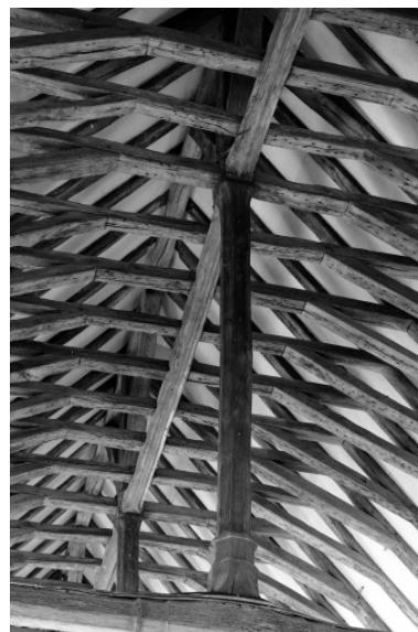
Intérieur, nef, charpente : vue générale. Phot. François Dagorn IVR53_19723500134V
