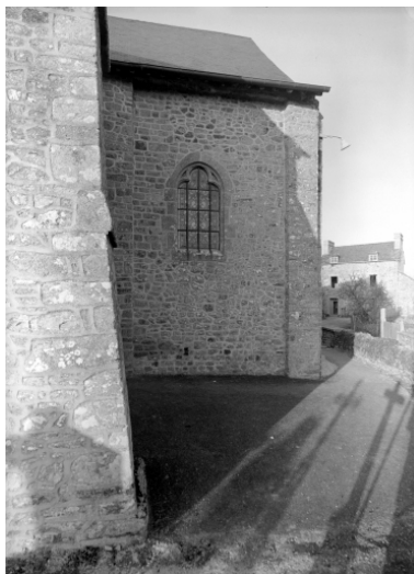
Elévation sud, partie est : vue générale Phot. François Dagorn IVR53_19723500028V
