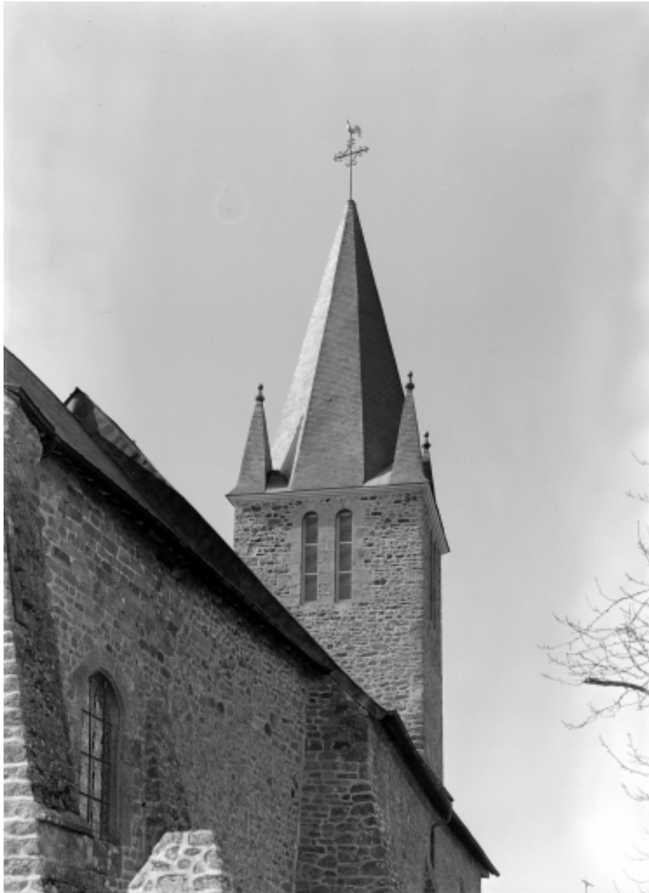
Elévation est, clocher, partie haute : vue générale
