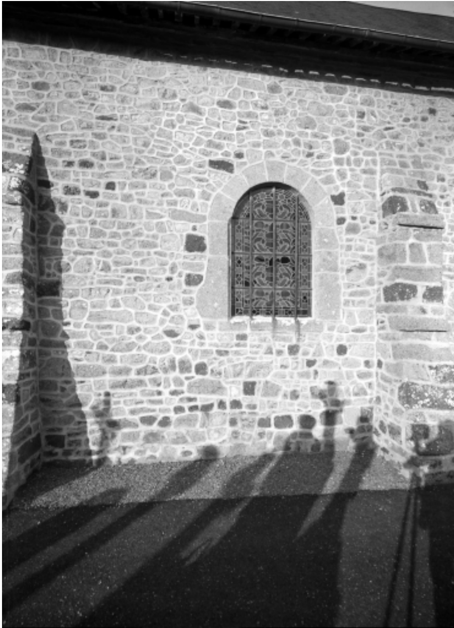
Elévation sud, fenêtre ouest : vue générale
