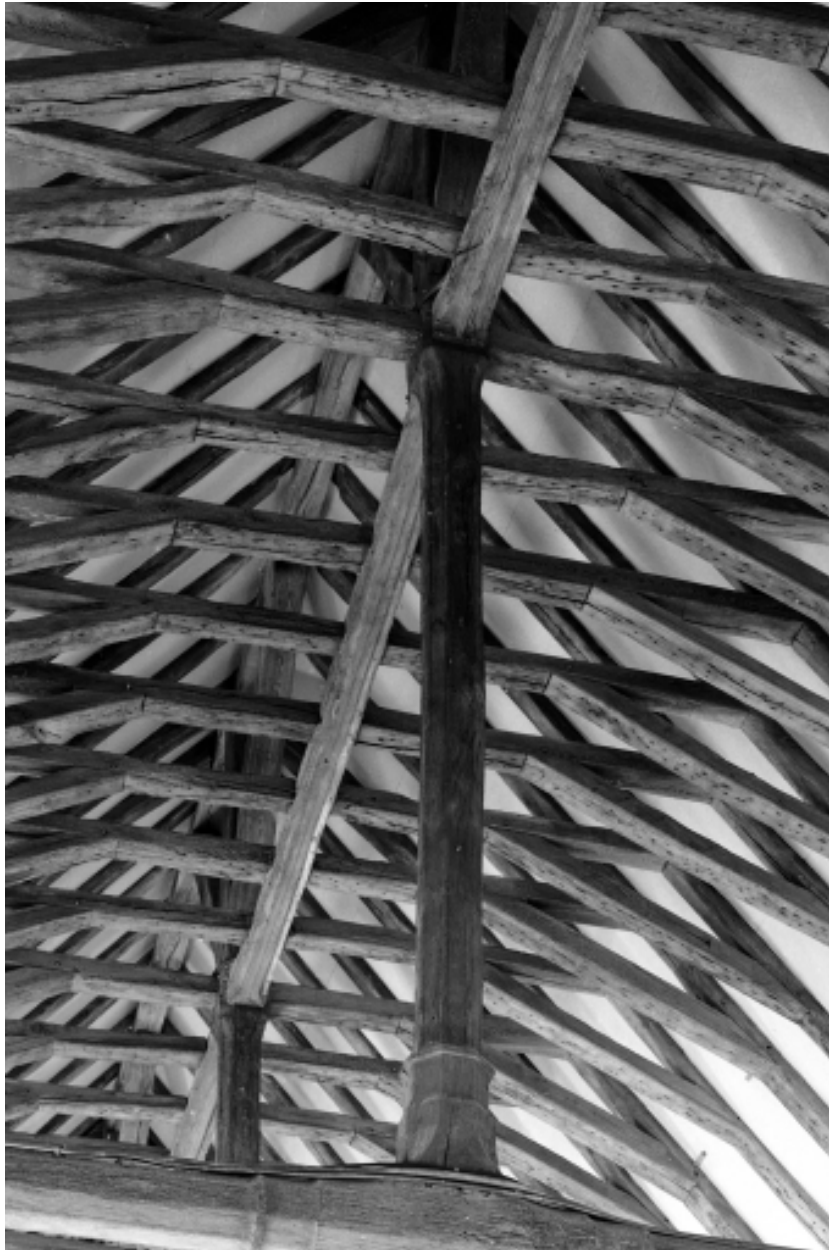
Intérieur, nef, charpente : vue générale.
