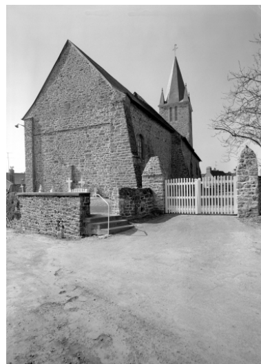
Elévation nord-est : vue générale Phot. François Dagorn IVR53_19723500113V
