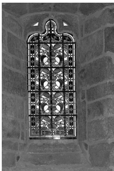
Mur sud, fenêtre 2 et niche, vue générale. Phot. François Dagorn IVR53_19723500096V
