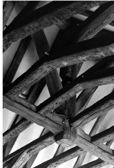
Intérieur, nef, charpente : détail sous le faitage. Phot. François Dagorn IVR53_19723500129V
