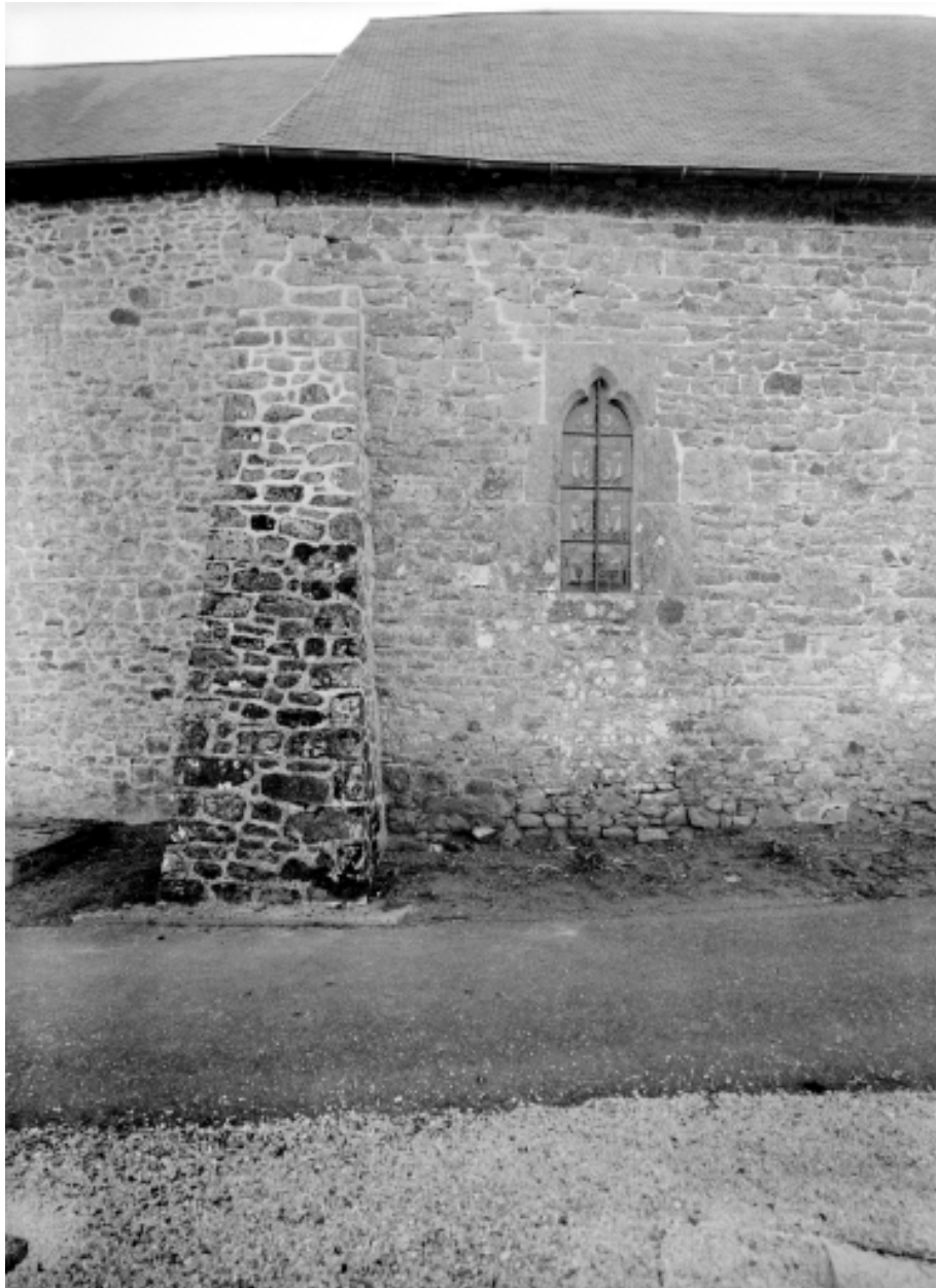
Elévation nord, fenêtre centrale : vue générale
