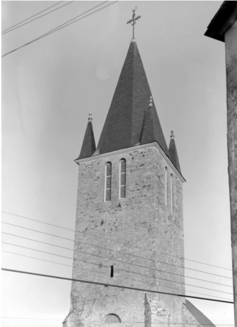
Elévation ouest, clocher, partie haute : vue générale
