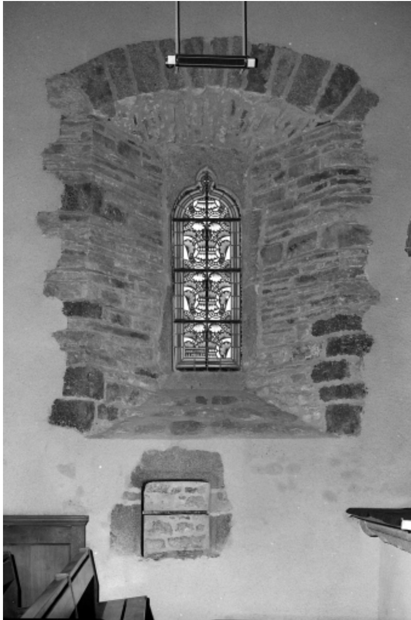
Mur nord, fenêtre et niche, vue générale.
