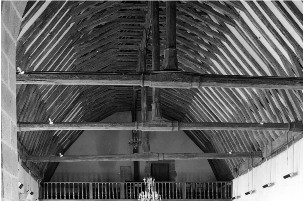
Intérieur, nef, charpente : vue générale.
