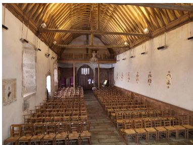
Vue intérieure vers l'entrée Phot. Bernard Bègne IVR53_20143500026NUCA
