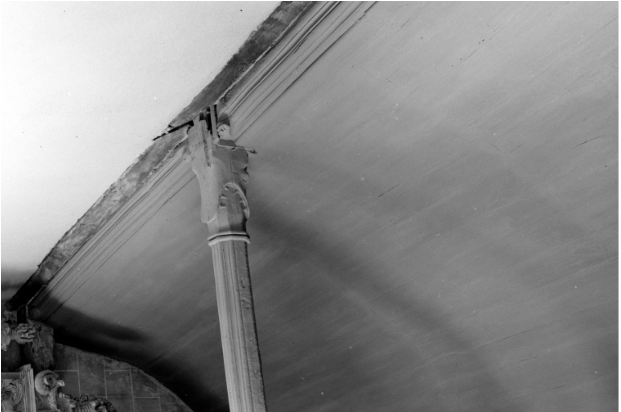
Intérieur, chœur, charpente : détail de la sablière et de l'entrave.
