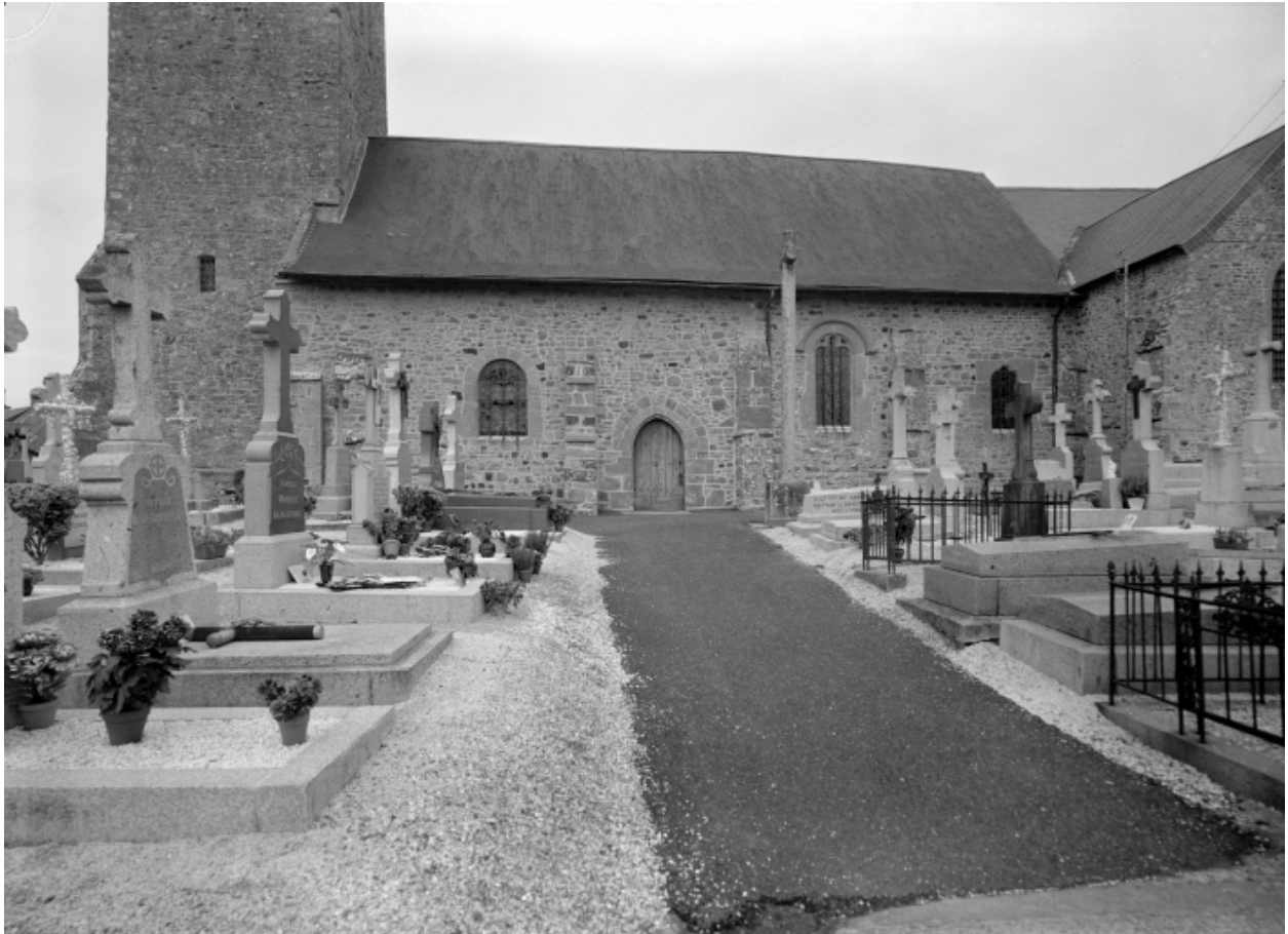
Elévation sud, partie centrale : vue générale
