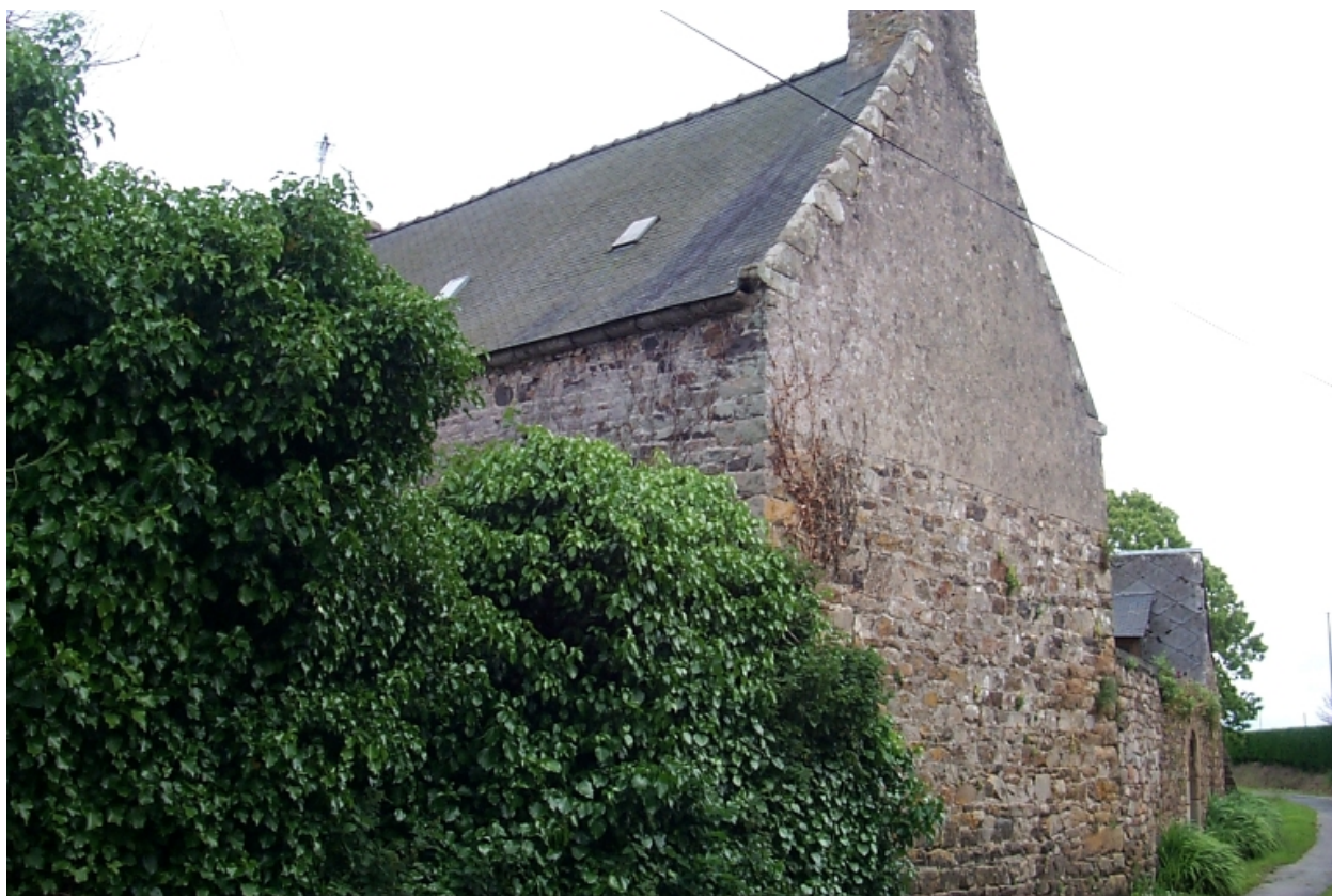
Vue générale (façade postérieure)
