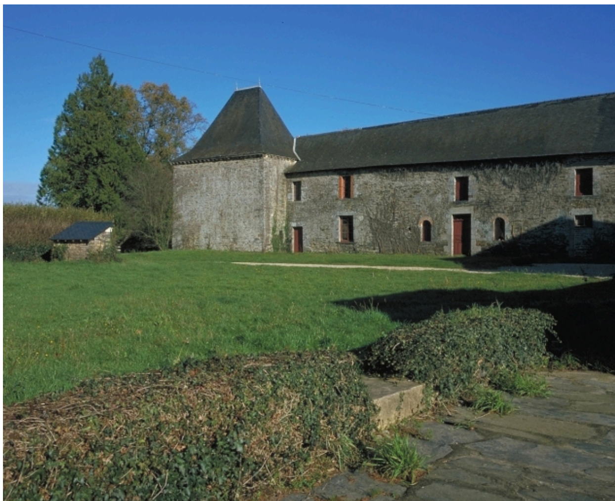
Vue générale ouest de l'ancien manoir
