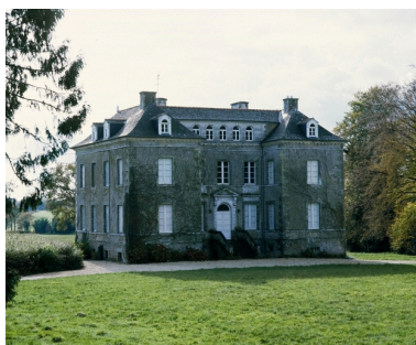
Façade antérieure : vue générale Phot. Guy Artur, Phot. Norbert Lambart IVR53_20003502858XA
