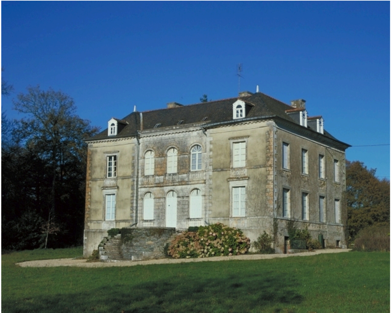
Façade postérieure : vue générale
