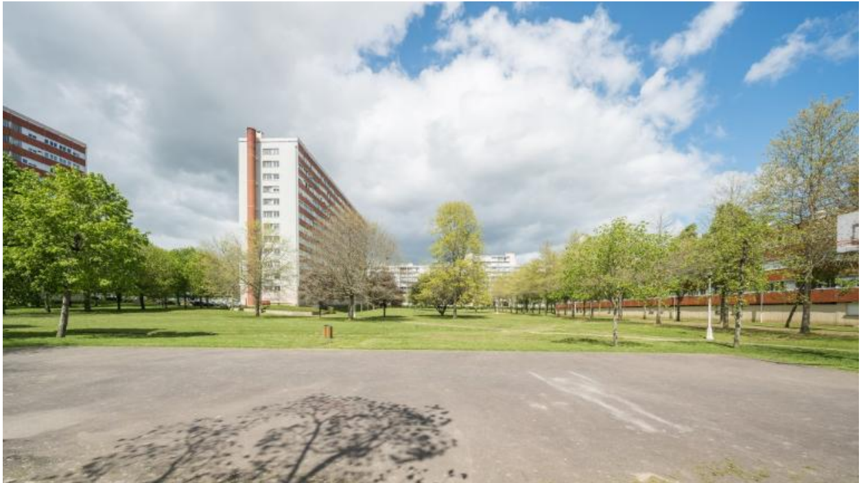
Vue d'ensemble depuis la rue du Bobénil.
