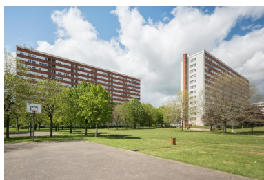
Vue d'ensemble. Phot. Charlotte Barraud IVR53_20243500441NUCA
