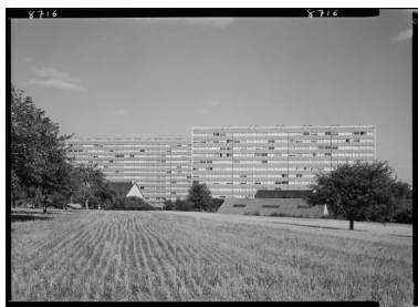
Vue générale des bâtiments A et B vers l'est. 7 septembre 1964. Autr. Créations Artistiques Heurtier IVR53_20253520044NUCA
