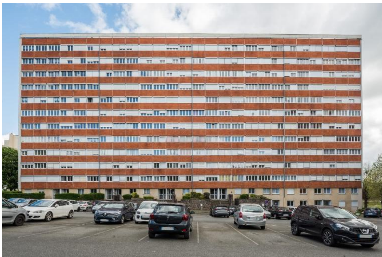
Elévation ouest du bâtiment B.
