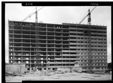
Constrution du bâtiment A. 15 juillet 1961. Autr. Créations Artistiques Heurtier IVR53_20253520046NUCA
