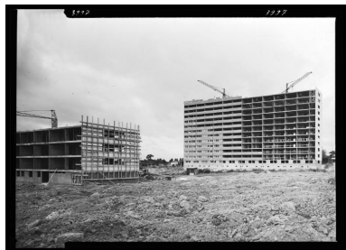
Vue du chantier de construction du grand ensemble des Cloteaux. 15 juillet 1961. Autr. Créations Artistiques Heurtier IVR53_20253520047NUCA
