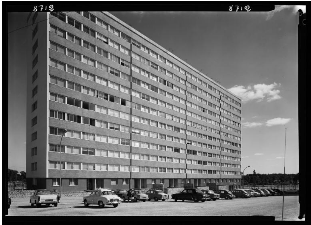
Vue de la façade ouest du bâtiment A. 7 septembre 1964.
