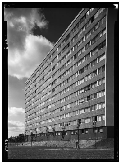
Vue générale du bâtiment B. 7 septembre 1964. Autr. Créations Artistiques Heurtier IVR53_20253520048NUCA
