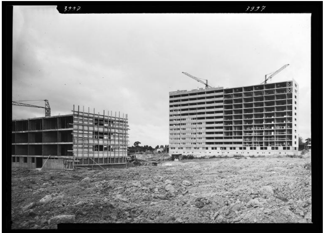
Vue du chantier de construction du grand ensemble des Cloteaux. 15 juillet 1961.
