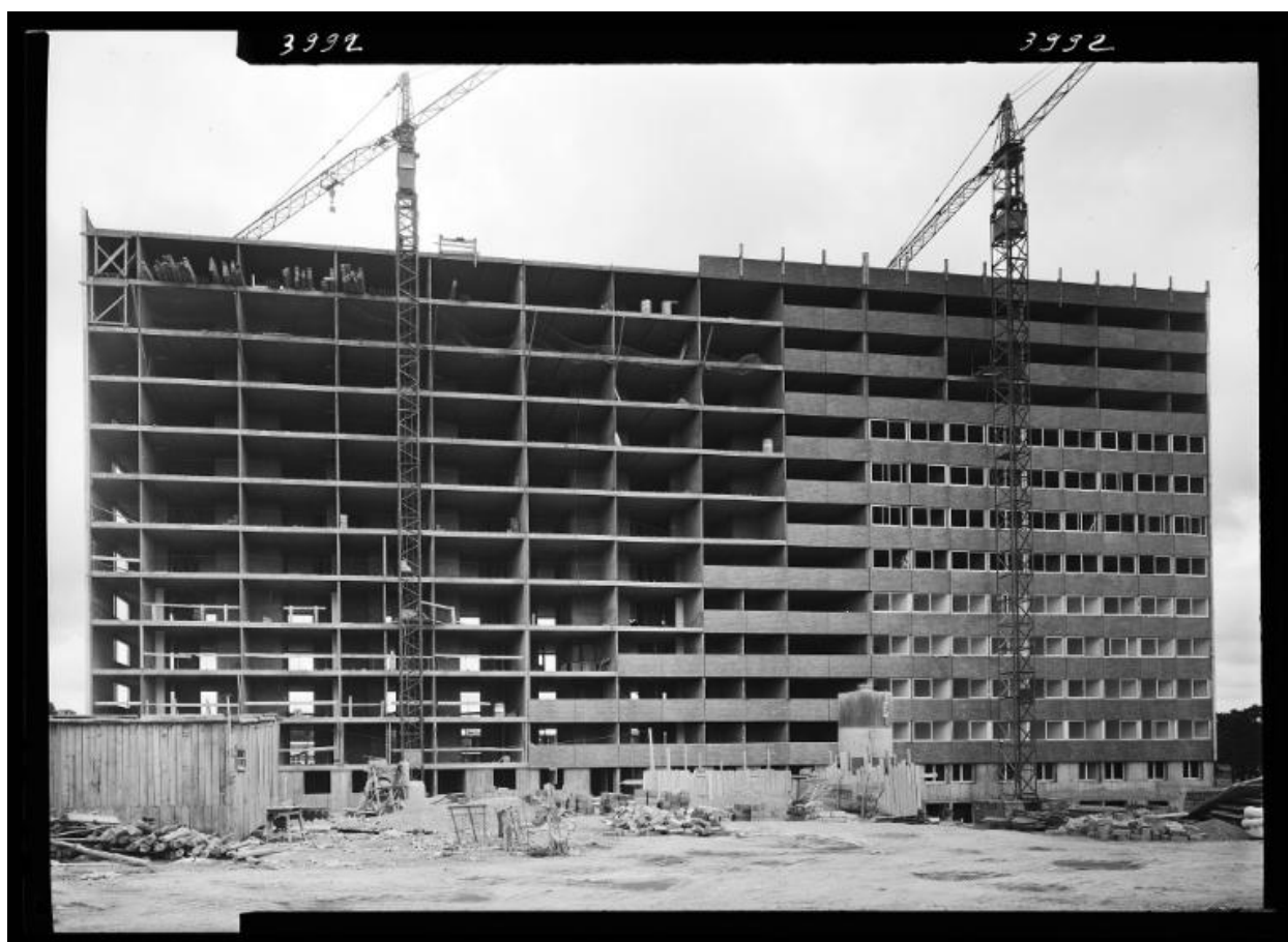
Constrution du bâtiment A. 15 juillet 1961.
