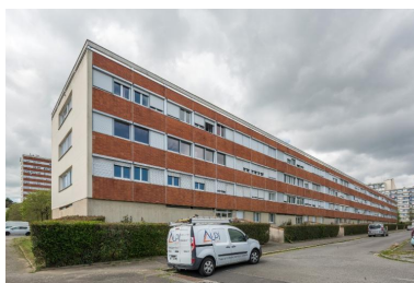
Elévation est du bâtiment C. Phot. Charlotte Barraud IVR53_20243500444NUCA
