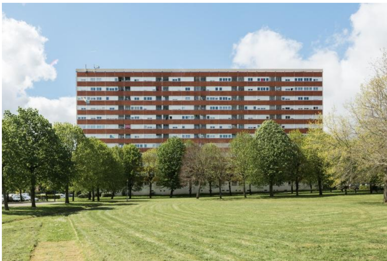
Elévation est du bâtiment B.
