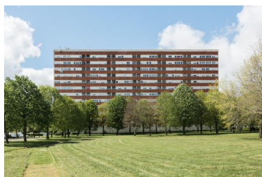
Elévation est du bâtiment B. Phot. Charlotte Barraud IVR53_20243500440NUCA
