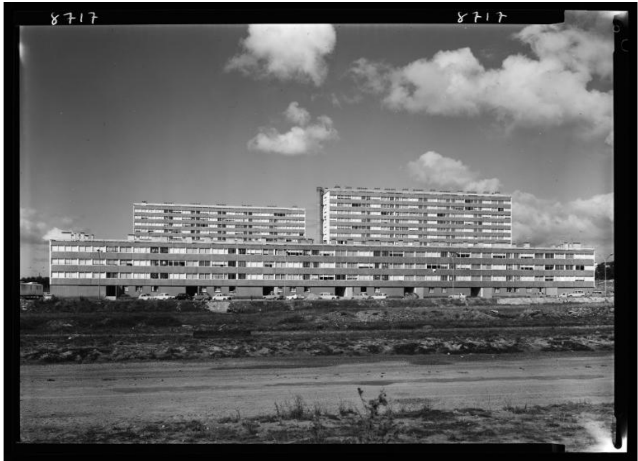
Vue d'ensemble depuis l'est. 7 septembre 1964.
