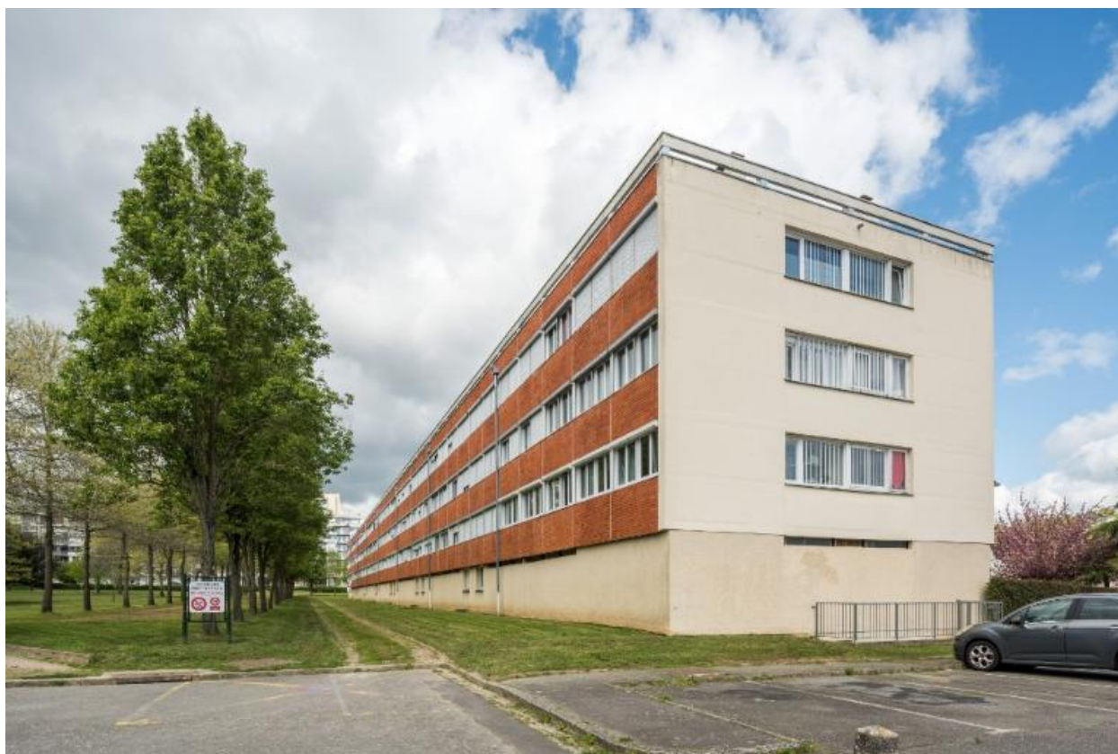
Vue du pignon sud et de la façade ouest du bâtiment C.
