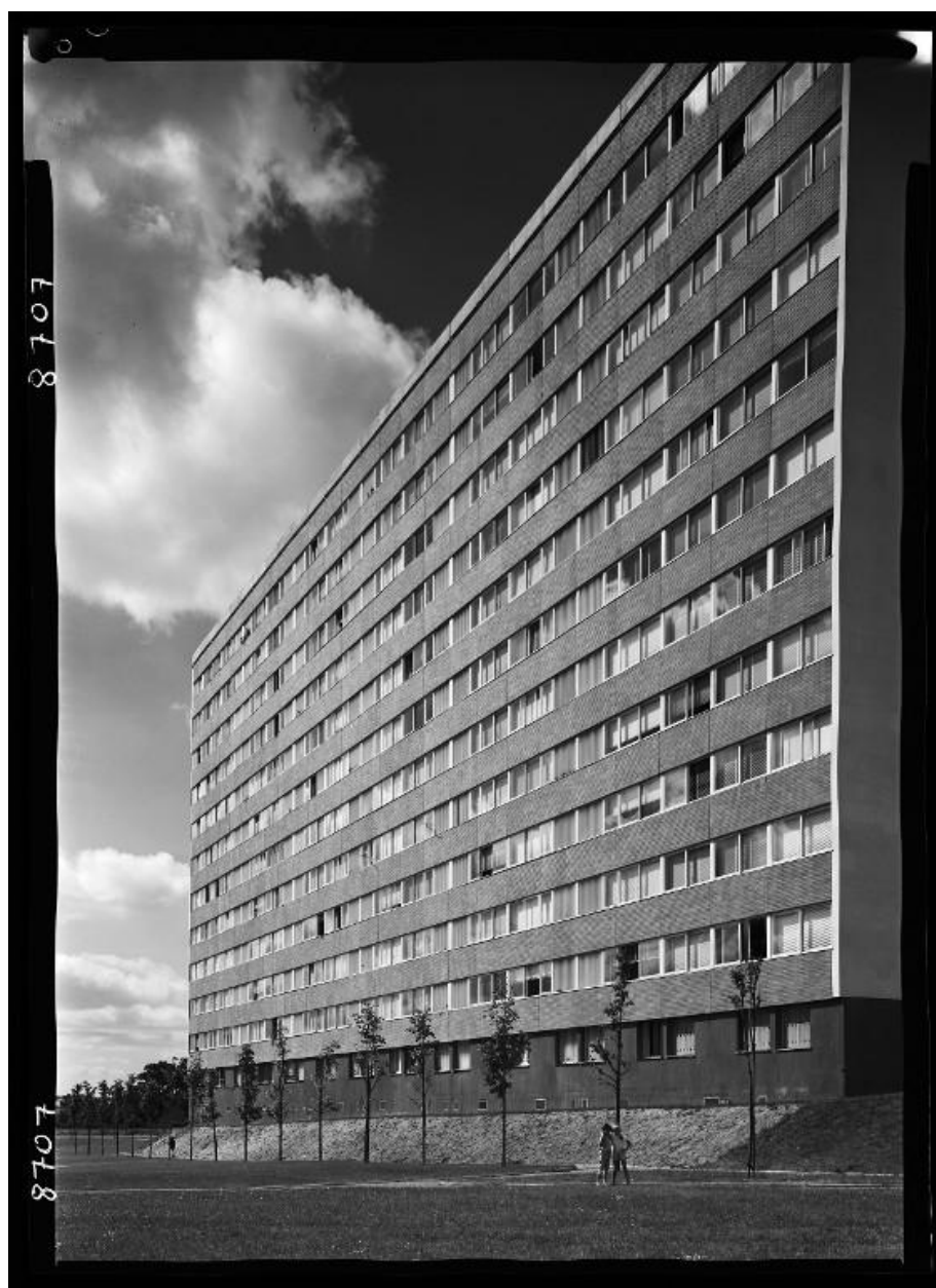
Vue générale du bâtiment B. 7 septembre 1964.
