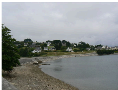
Vue générale de la digue-route de Kervian Phot. Lénaïg L'Aot IVR53_20072908965NUCA
