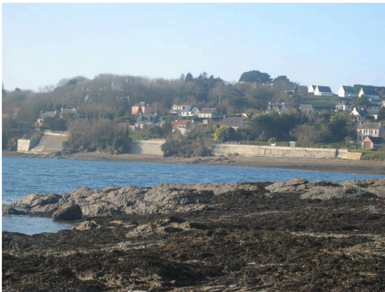
Mur de soutènement au sud de la digue-route de Kervian
