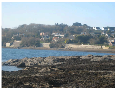
Mur de soutènement au sud de la digue-route de Kervian Phot. Guillaume Marie IVR53_20072908967NUCA
