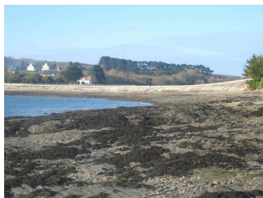
Digue-route de Kervian Phot. Guillaume Marie IVR53_20072908968NUCA
