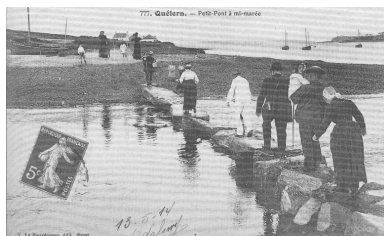
Carte postale : Petit-Pont à mi-marée Repro. Florence Desprez IVR53_20082908504NUC
