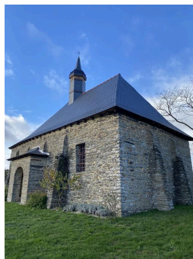
Vue sud-est Phot. Baptiste Oligo IVR53_20265610494NUCA
