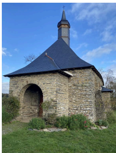
Vue sud-ouest Phot. Baptiste Oligo IVR53_20265610493NUCA
