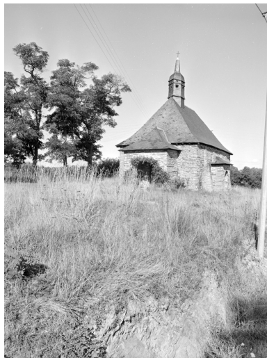
Vue générale sud-ouest. Phot. François Dagorn IVR53_19775600938X
