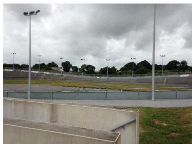
Vue de la ligne droite opposée Phot. Clément Robert IVR53_20152908430NUCA
