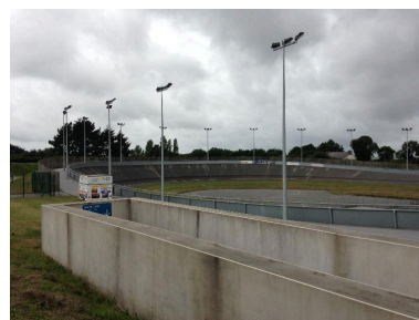
Vue du virage ouest Phot. Clément Robert IVR53_20152908429NUCA
