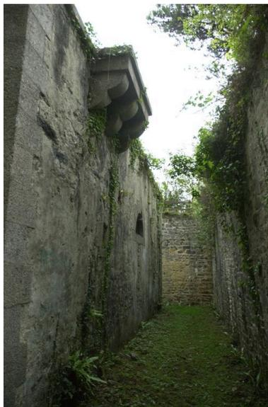
Vue du corps de garde crénelé n° 2 modifié de la pointe de Morgat ou Kador : façade sud protégée par un masque artificiel réalisé avec le déblai provenant de la fouille maintenue par une contrescarpe
