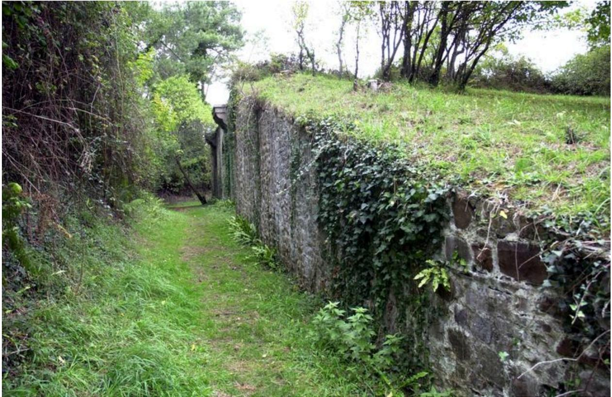
Vue du corps de garde crénelé n° 2 modifié de la pointe de Morgat ou Kador : masque terrassé couvrant le long pan est et le pignon sud. Masque artificiel réalisé avec le déblai provenant de la fouille
