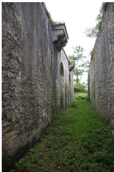
Vue du corps de garde crénelé n° 2 modifié de la pointe de Morgat ou Kador : façade est protégée par un masque artificiel réalisé avec le déblai provenant de la fouille maintenue par une contrescarpe
