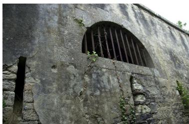
Vue du corps de garde crénelé n° 2 modifié de la pointe de Morgat ou Kador : façade est, baie et créneaux de fusillade
