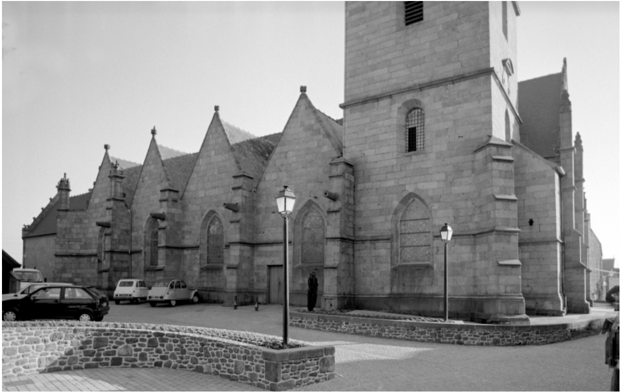
Elévation Nord : vue générale
