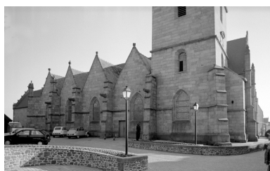
Elévation Nord : vue générale Phot. A. Boden IVR53_19933500616X
