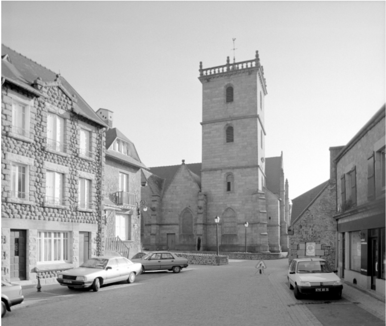
Elévation Nord, partie Est : vue générale
