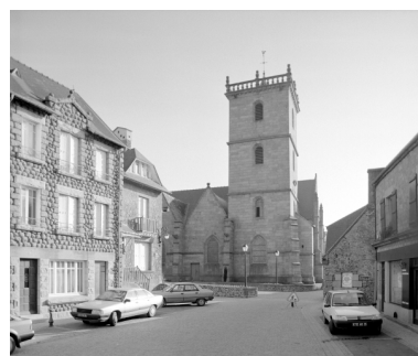
Elévation Nord, partie Est : vue générale Phot. A. Boden IVR53_19933500615X
