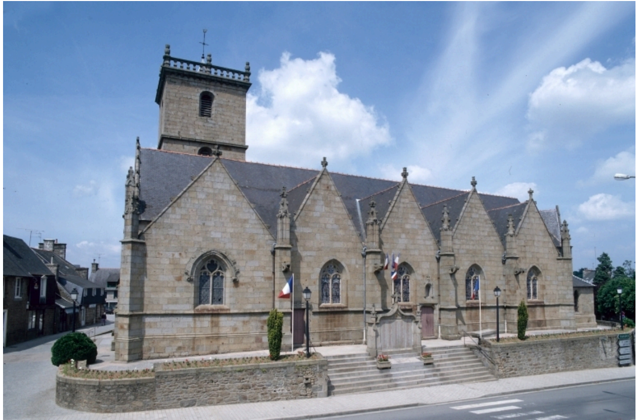
Elévation Sud : vue générale
