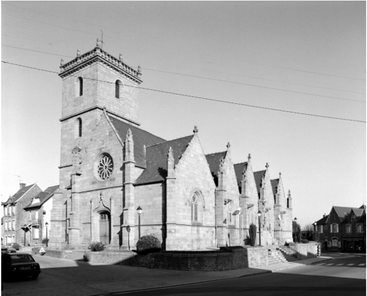
Elévation Sud-Ouest : vue générale
