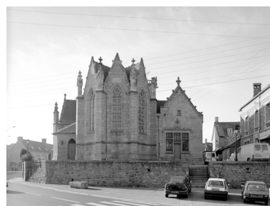
Elévation Est : vue générale Phot. A. Boden IVR53_19933500614X
