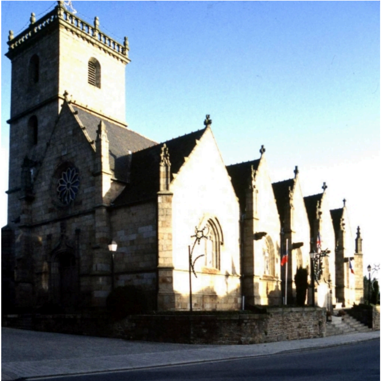
Vue d'ensemble prise du sud ouest.
