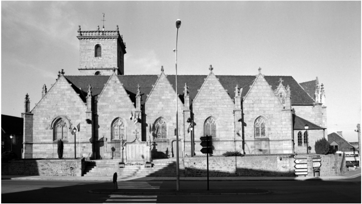
Elévation Sud : vue générale
