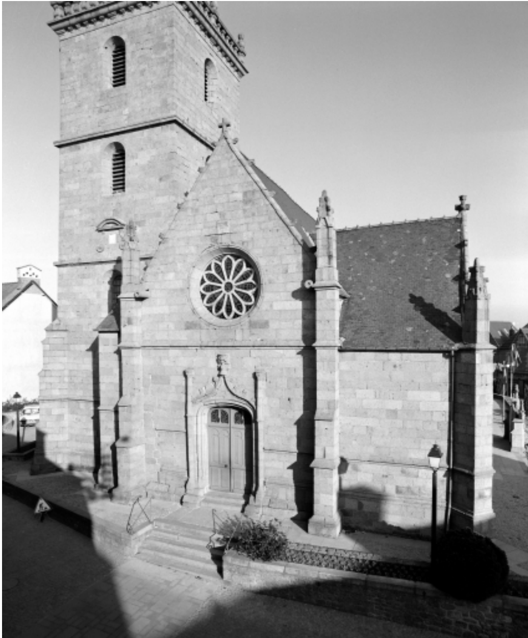
Elévation Ouest : vue générale
