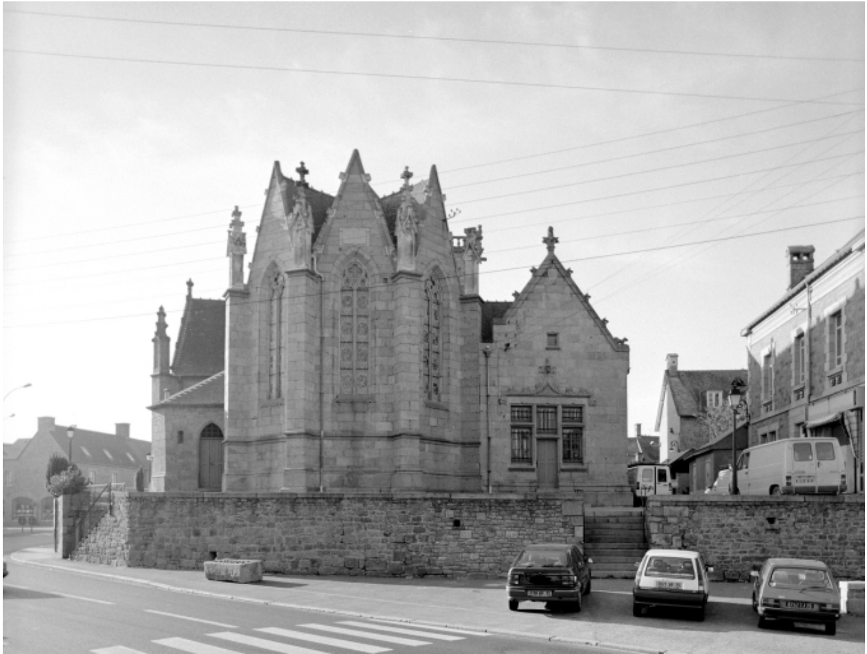
Elévation Est : vue générale
