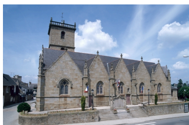
Elévation Sud : vue générale Phot. A. Boden IVR53_19953500389XA
