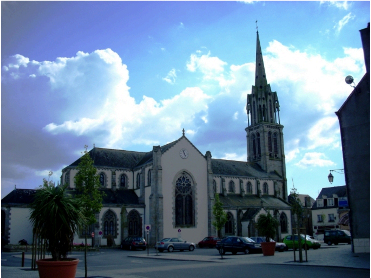
Moëlan-sur-Mer, église paroissiale Saint-Melaine : vue générale nord-est
