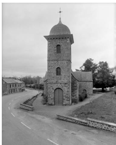
Elévation Ouest : vue générale
