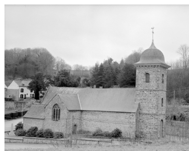
Elévation Nord : vue générale. Phot. Guy Artur, Phot. Norbert Lambart IVR53_19943500713X
