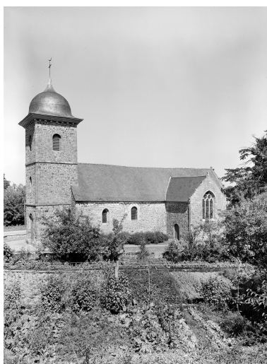
Elévation Sud : vue générale Phot. Guy Artur, Phot. Norbert Lambart IVR53_19853501278V
