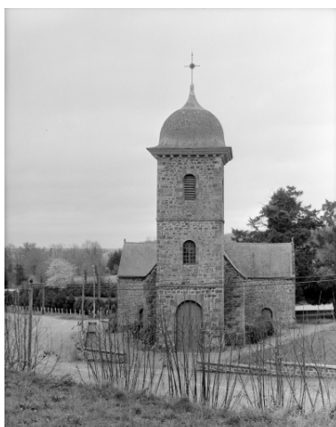
Elévation Ouest : vue générale.
