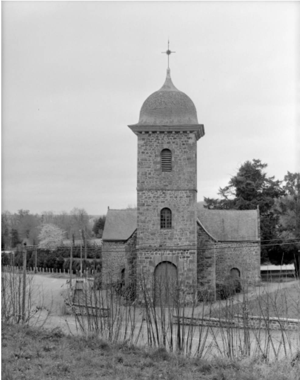
Elévation Ouest : vue générale.
