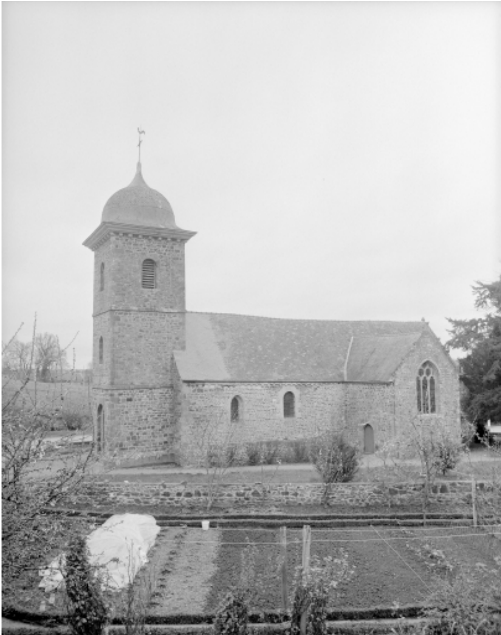
Elévation Sud : vue générale.
