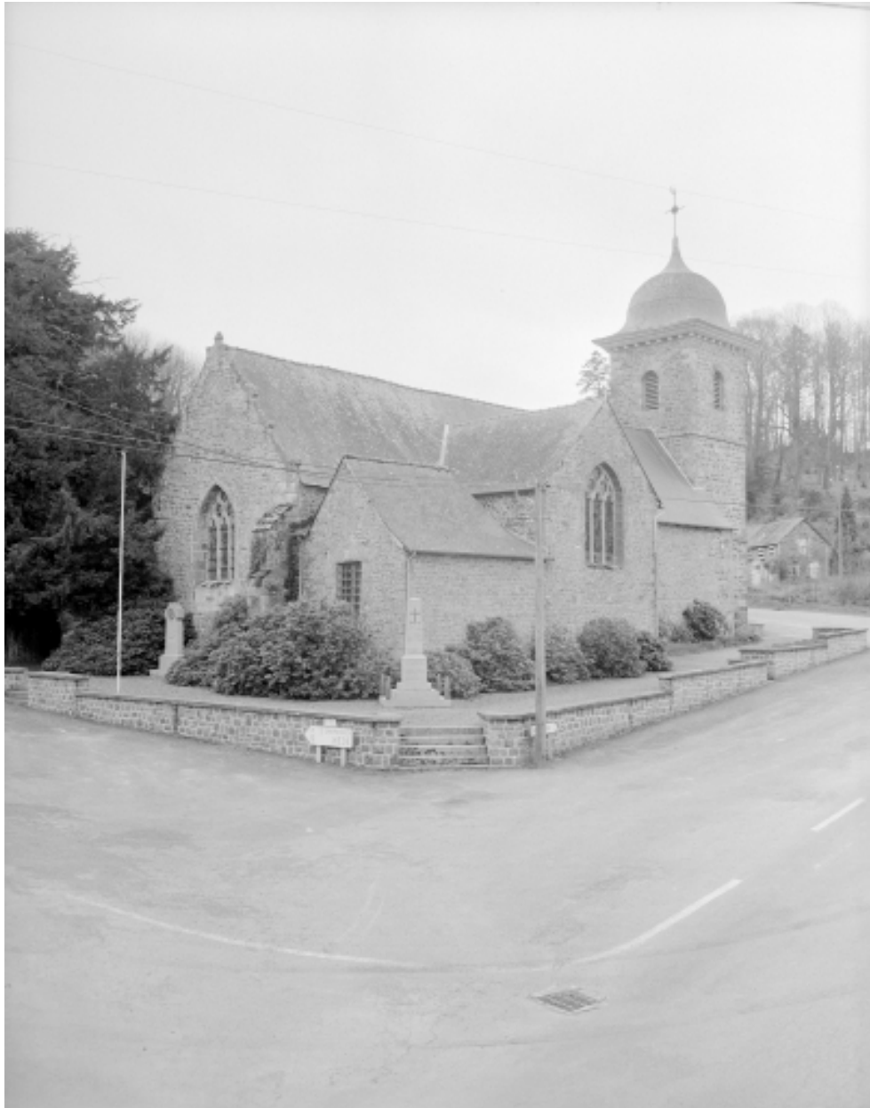
Elévation Nord-Est : vue générale.
