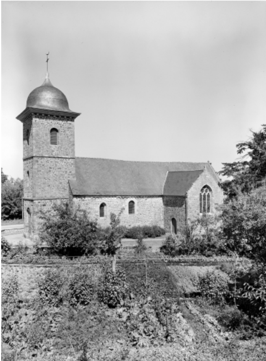
Elévation Sud : vue générale
