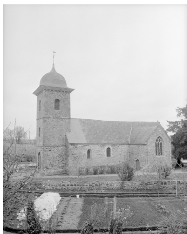
Elévation Sud : vue générale. Phot. Guy Artur, Phot. Norbert Lambart IVR53_19943500714X
