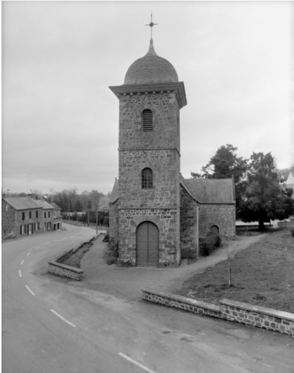
Elévation Ouest : vue générale
