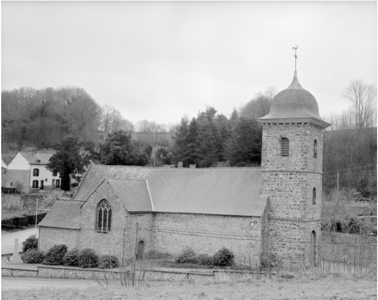
Elévation Nord : vue générale.
