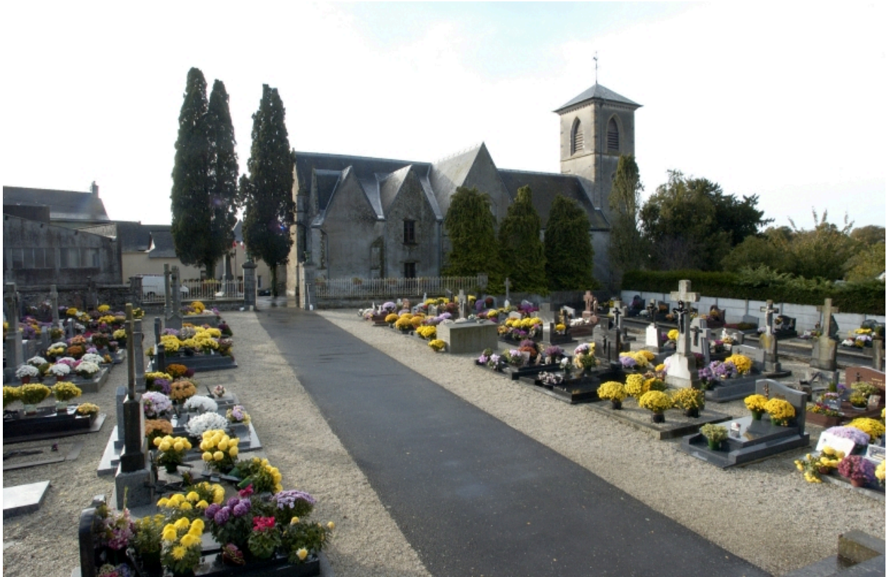
Vue générale nord
