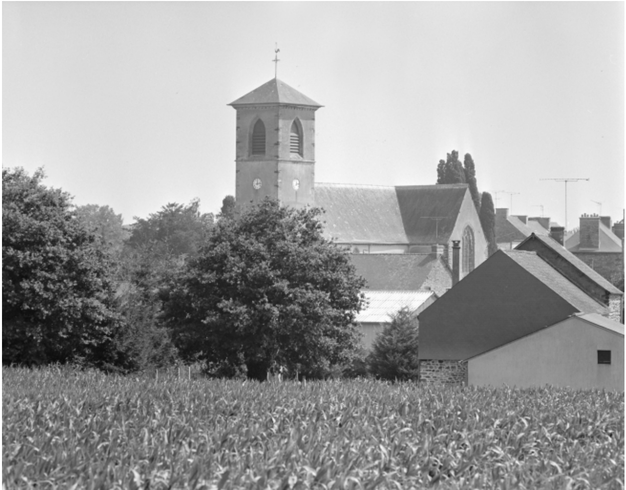
Vue de situation sud ouest
