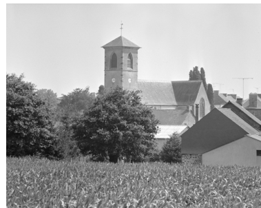
Vue de situation sud ouest Phot. Guy Artur, Phot. Norbert Lambert IVR53_19943501378X
