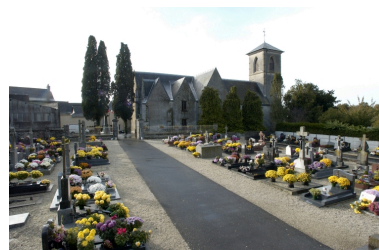
Vue générale nord Phot. Norbert Lambert IVR53_20023503460NUC
