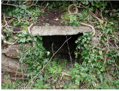
Vue générale (état en 2003) Phot. Guillaume Lécuillier IVR53_20032901966NUCA
