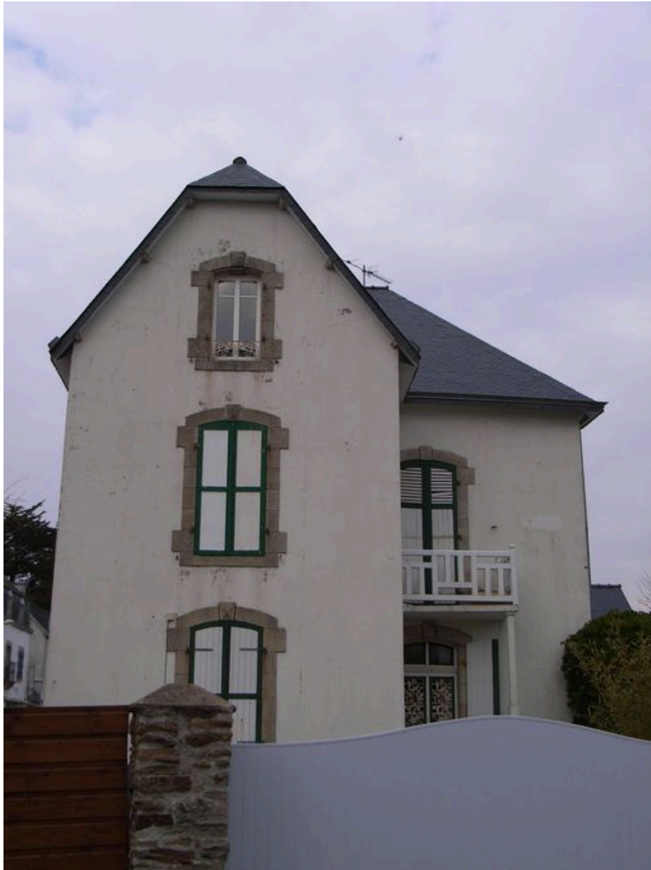
Façade sud de la villa 28 rue des Grands-Sables
