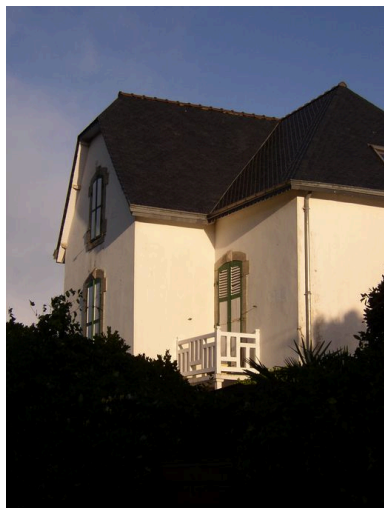
Façade sud de la villa 28 rue des Grands-Sables Phot. Johan Vincent IVR53_20062908689NUCA
